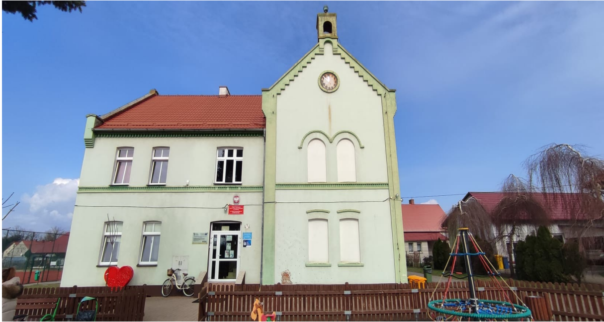
Fot.7.1. Miejsce odkrywki na ścianie elewacji frontowej.
