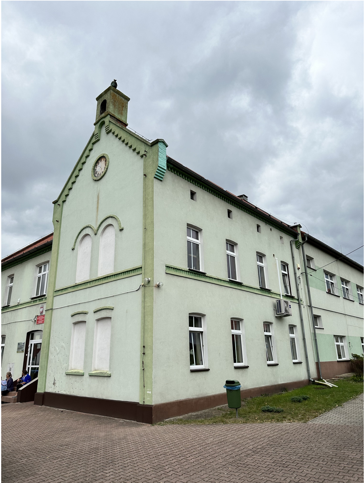
Fot.4. Widok elewacji wschodniej wraz z częścią elewacji frontowej.
