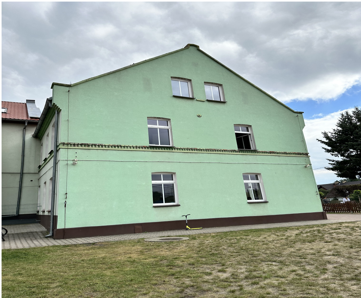
Fot.2. Widok elewacji zachodniej
