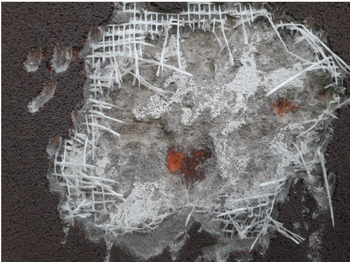
Fot.8. Miejsce odkrywki na ścianie elewacji północnej.
