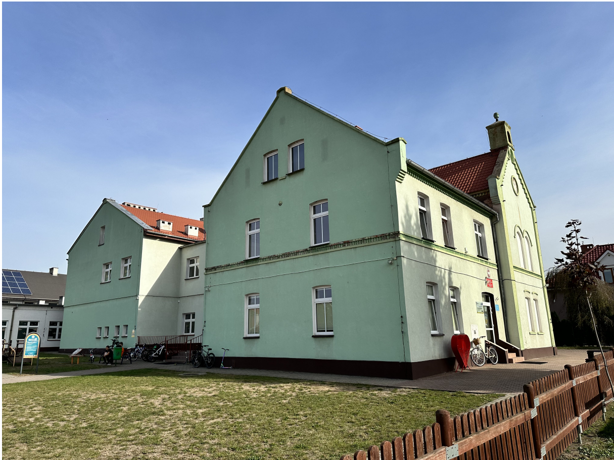
Fot.6. Widok całości budynku od strony zachodniej.
