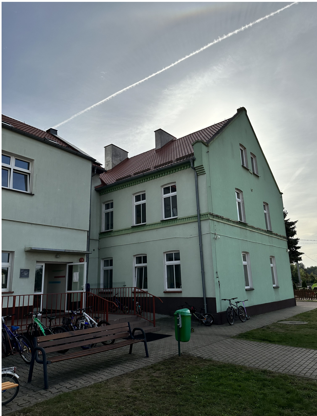
Fot.5. Widok elewacji północnej wraz z elewacją boczną.
