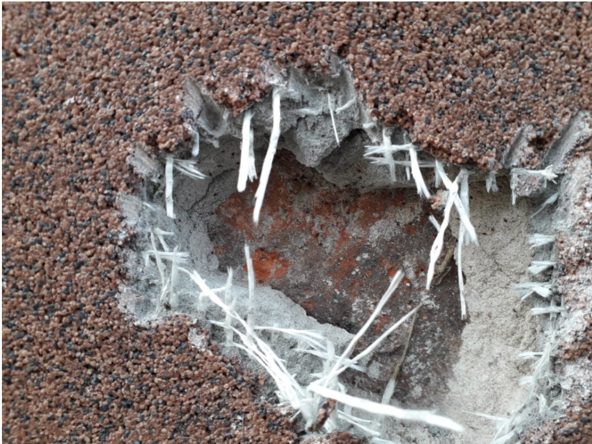
Fot.8. Miejsce odkrytki na ścianie elewacji wschodniej.
