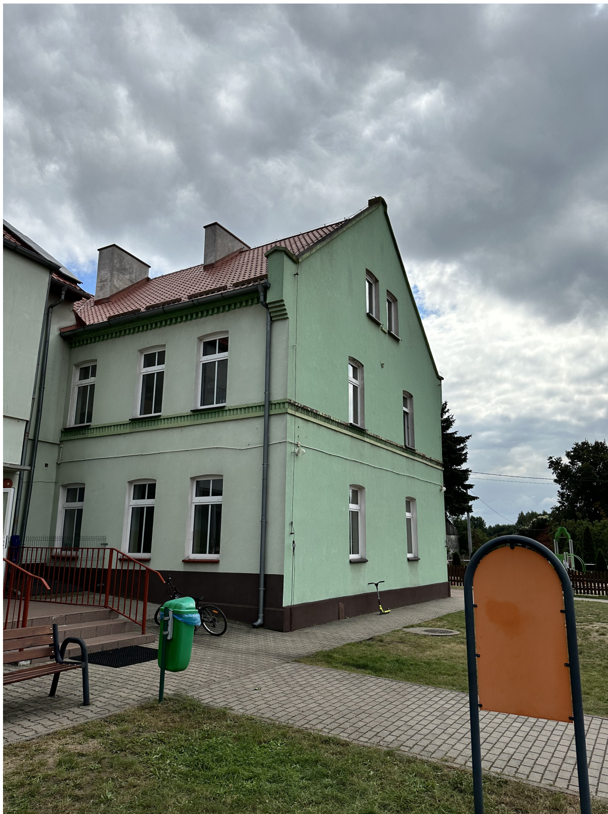
Fot.3. Widok elewacji północnej.
