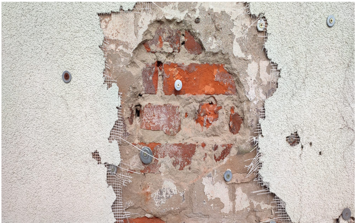
Fot.7. Miejsce odkrywki na ścianie elewacji frontowej.
