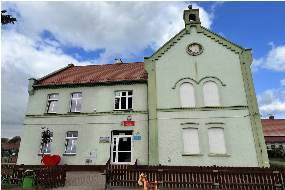
Fot.1 – Widok elewacji południowej (elewacja frontowa)
