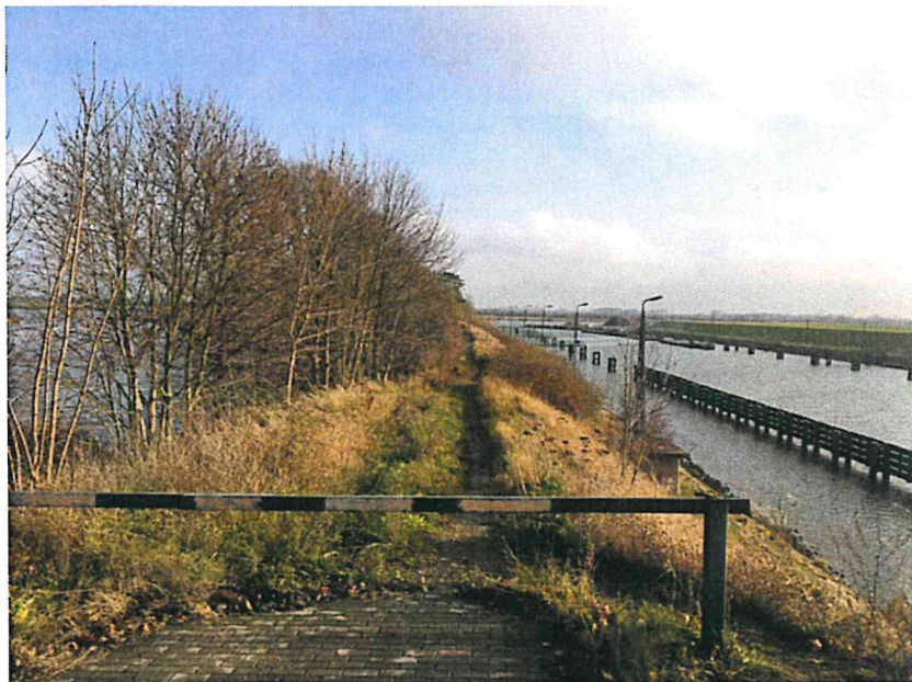
widok od ulicy Akwenowej (wykonany odcinek zjazdu - chodnika zamknięty szlabanem)
