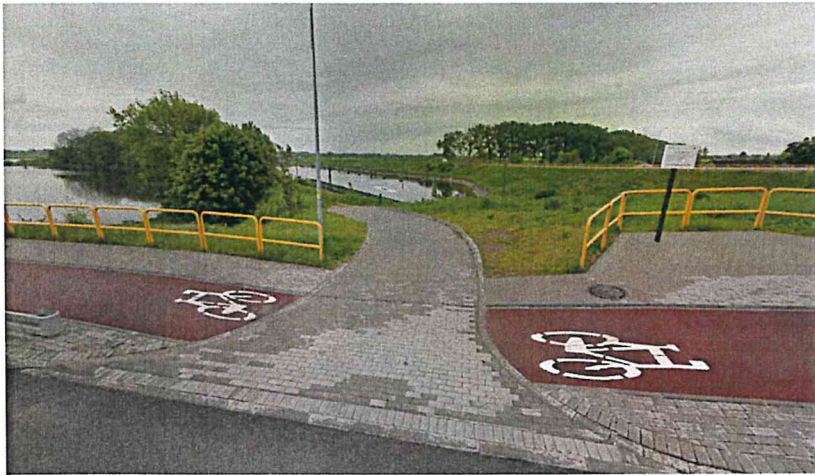
widok od ulicy Akwenowej (wykonany odcinek zjazdu zamknięty szlabanem)
