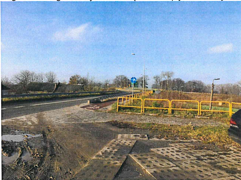
widok na ulicę Akwenową - koniec ścieżki rowerowej początek dojścia do punktu widokowego poprzez istniejący plac z płyt typu Yomb
