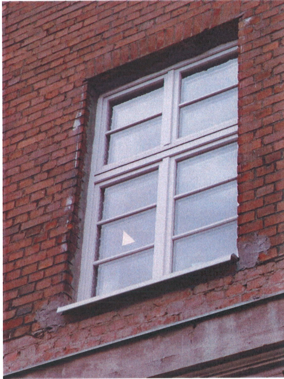
Ubytek gzymsu w pasie ponad parterem i współczesne kity
