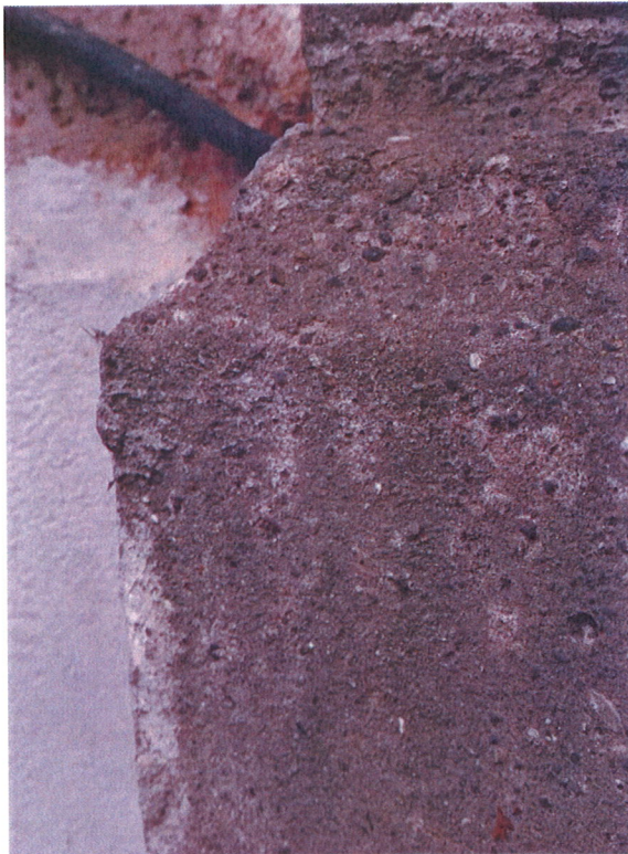
Portal. Ubytek profilu na cokole Ryflowania na zachodniej części portalu
