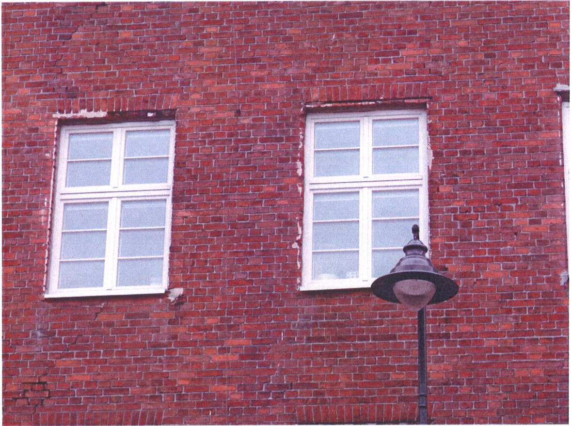
Wtórne kity cementowe na wążku ceramicznym i szczeliny w nadprożach po współczesnej blacharce
