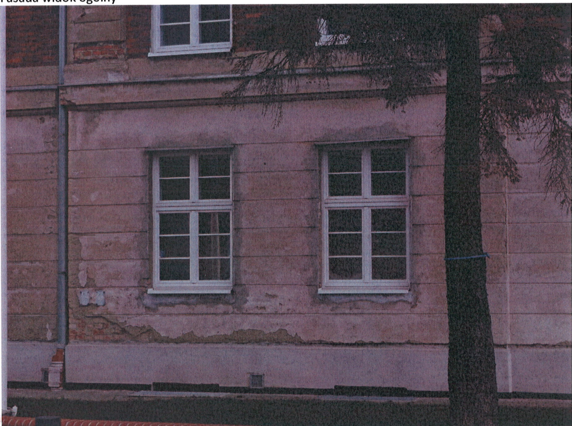
Parter stan zachowania boniowania
