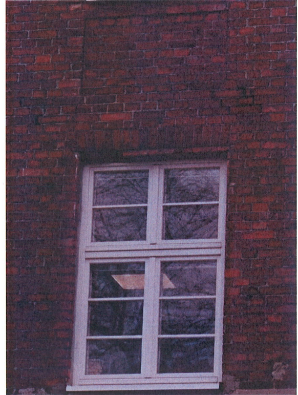
Wtórne kity cementowe na wążku ceramicznym i szczeliny w nadprożach po współczesnej blacharce Pęknięcie ukośne do oceny konstruktora i klawiszujące cegły
