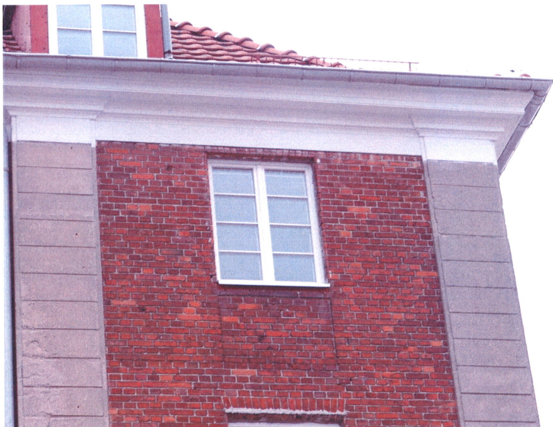
Gzyms wieńczący po remoncie
