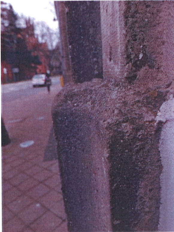
Portal Ubytek profilu na cokole Przykład zachowanego ryflowania zakrytego przemalowaniami
