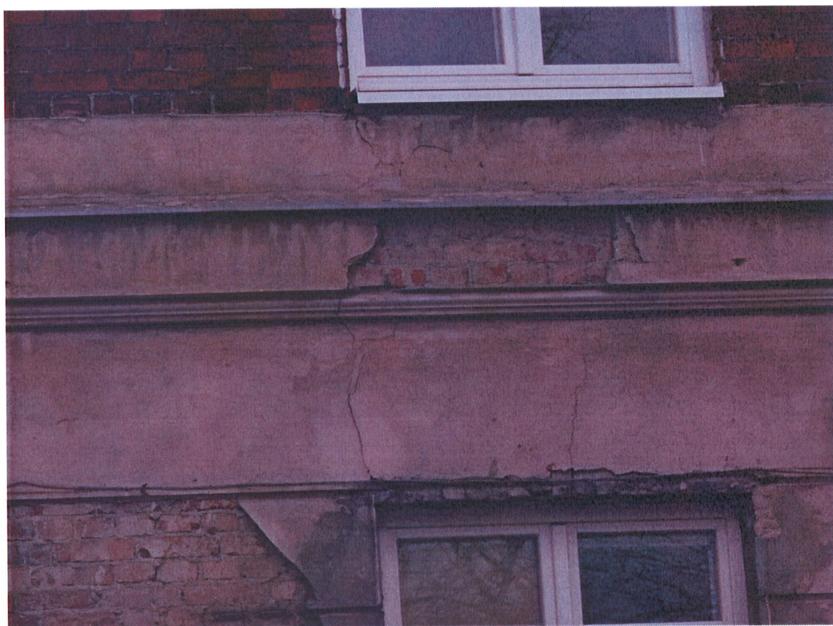
Stan zachowania wypraw sztukatorskich nagzysie ponad parterem i na boniowaniach
