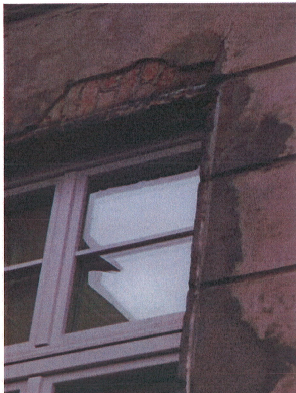
Okno parteru stan zachowania wypraw i uzupełnień Okno parteru stan zachowania wypraw i uzupełnień
