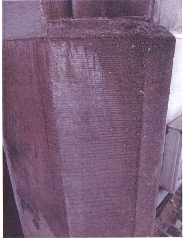
Przykład zachowanego ryflowania zakrytego przemalowaniami. Odkrywka stratygraficzna
