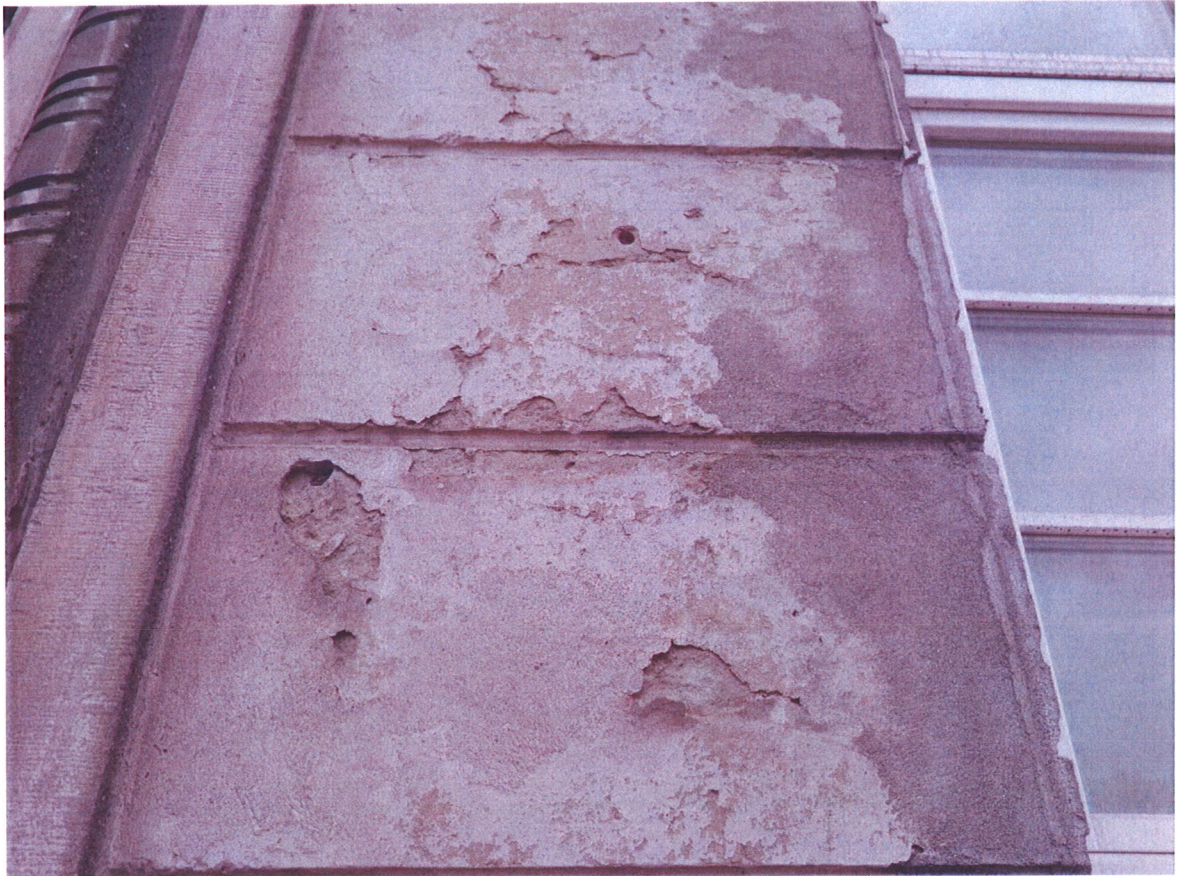
Parter stan zachowania boniowania
