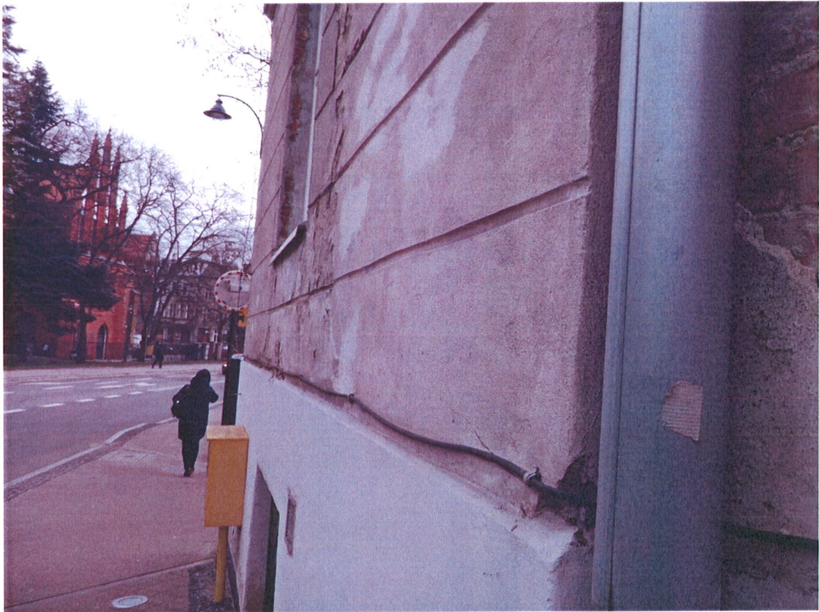
Współczesne nawarstwienia i naprawy zniekształcające rysunek detalu
