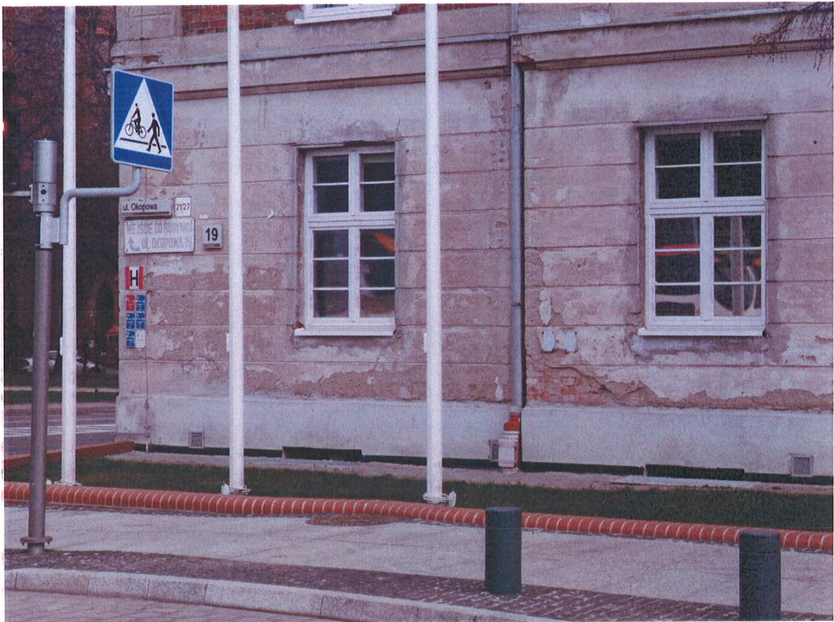
Parter stan zachowania boniowania
