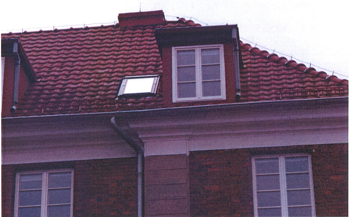
Gzyms wieńczący po remoncie
