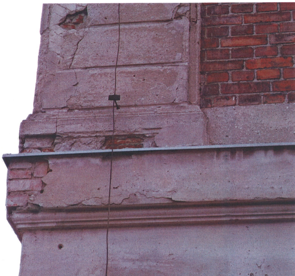
Naroże pn- zach -stan zachowania wypraw i przykład profili do odtworzenia
