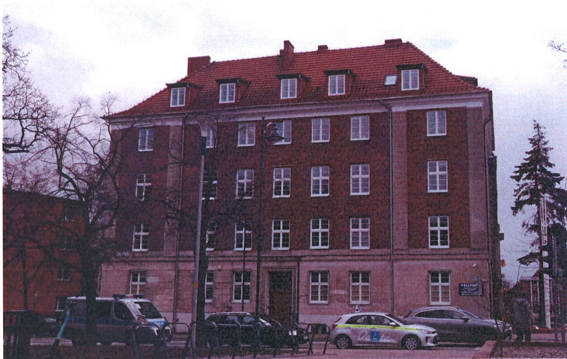
Fasada północna. Widok ogólny
