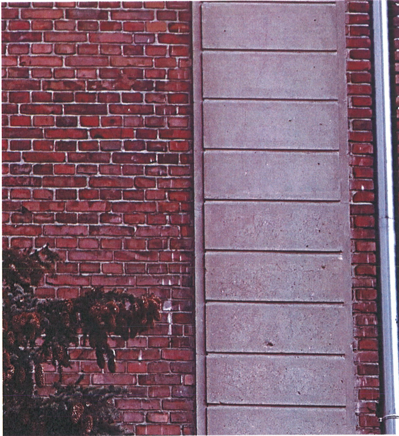
Fasada zachodnia Przykład zachowanych ciosów pilastru
