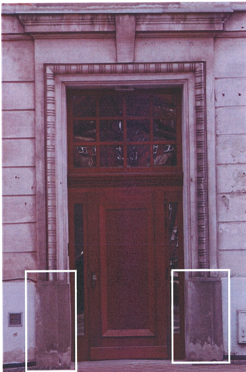
Portal wejściowy zakres przywrócenia lica
