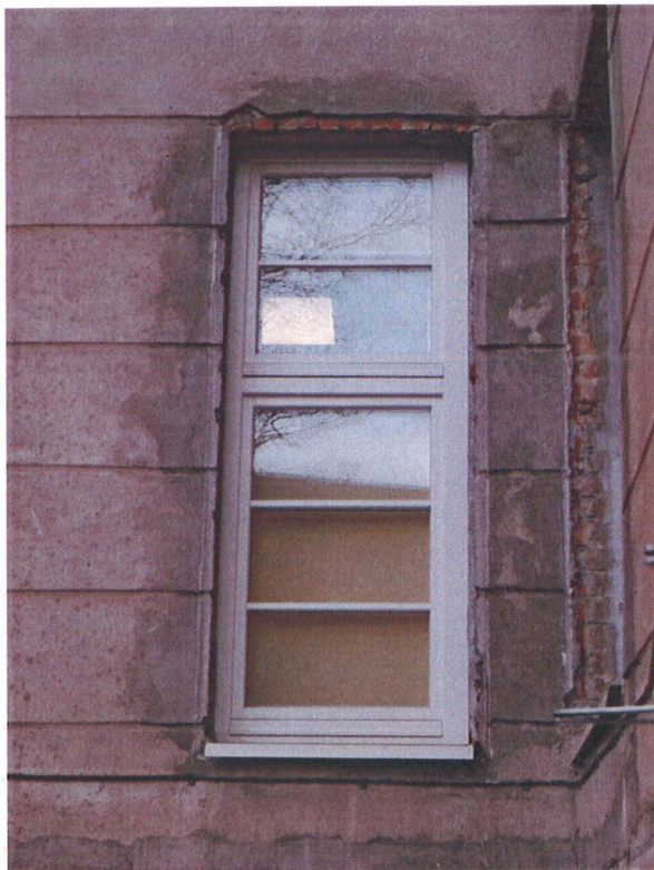
Okno parteru stan zachowania wypraw i uzupełnień Okno parteru stan zachowania wypraw i uzupełnień
