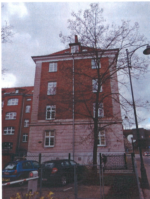
Fasada widok ogólny. Widoczne współczesne uzupełnienia w kolorze szarym
