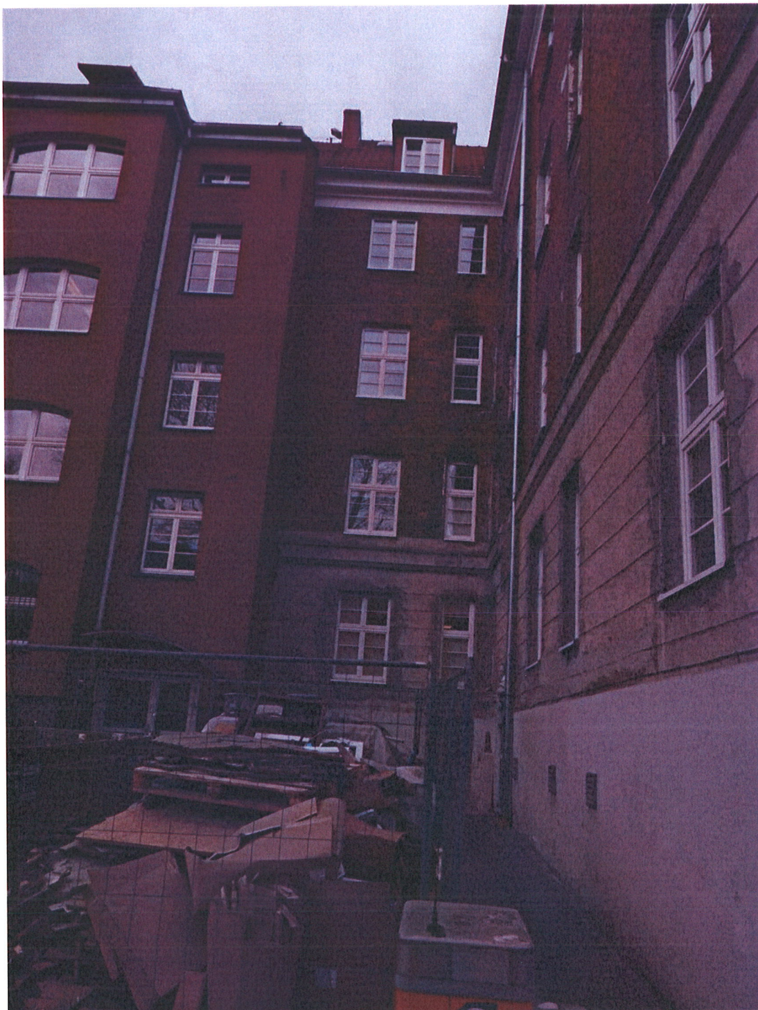
Fasada tylna południowa
