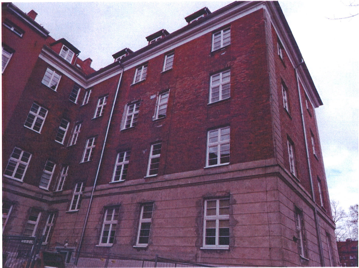
Fasada tylna południowa
