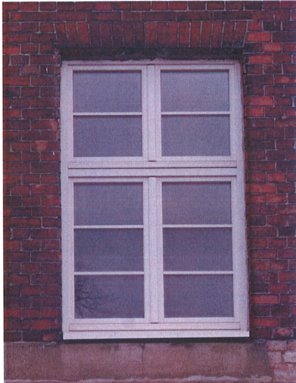
Wtórne kity cementowe na wążku ceramicznym i szczeliny w nadprożach po współczesnej blacharce Pęknięcie ukośne do oceny konstruktora i klawiszujące cegły
