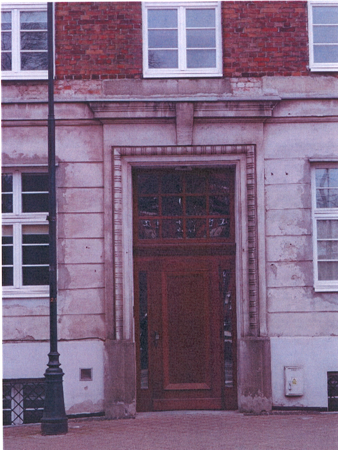
Wejście główne portal wejściowy
