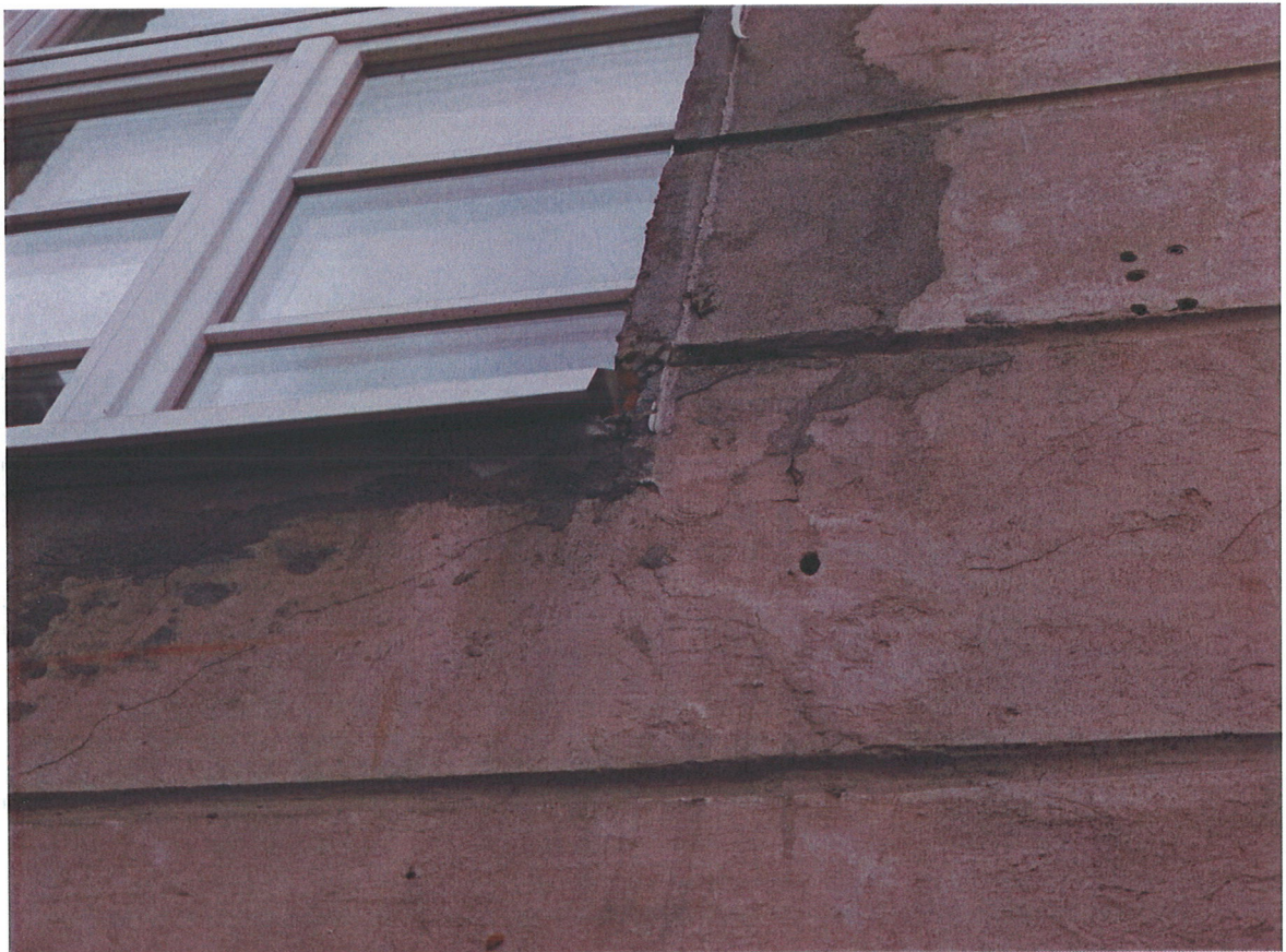
Przekształcone lico boniowanego parteru
