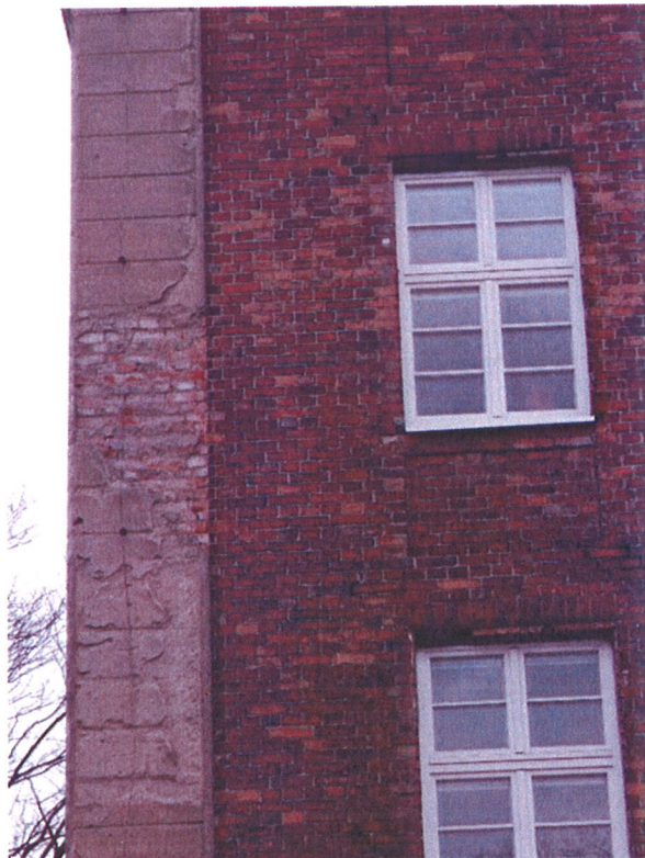
Stan zachowania wypraw sztukatorskich na pilastrach Stan zachowania wypraw sztukatorskich na pilastrach i gzymsie
