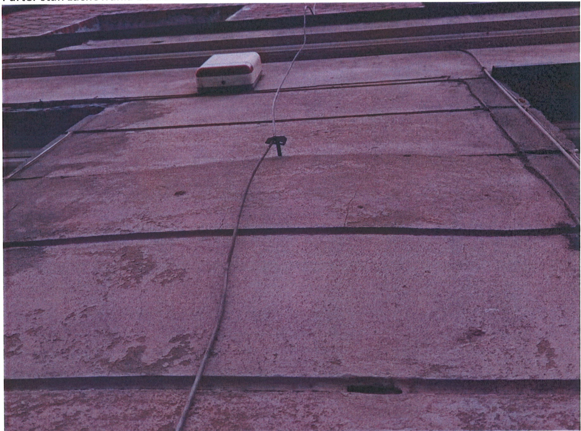
Silne odkształcenie pasa boniowania
