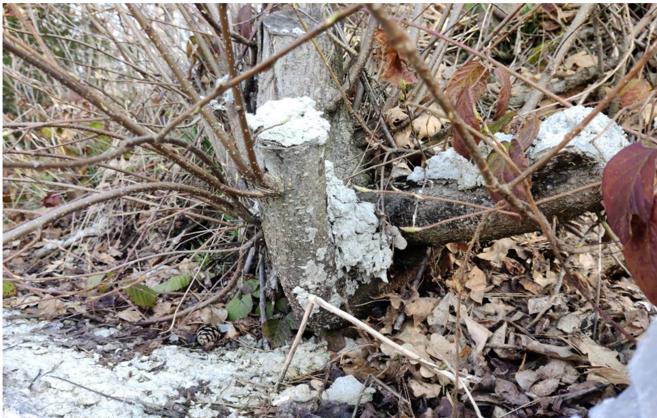
Fot. 11 Wady wykonawcze "Wodospadu na skałach" – resztki szpachli pozostawione na krzewach
