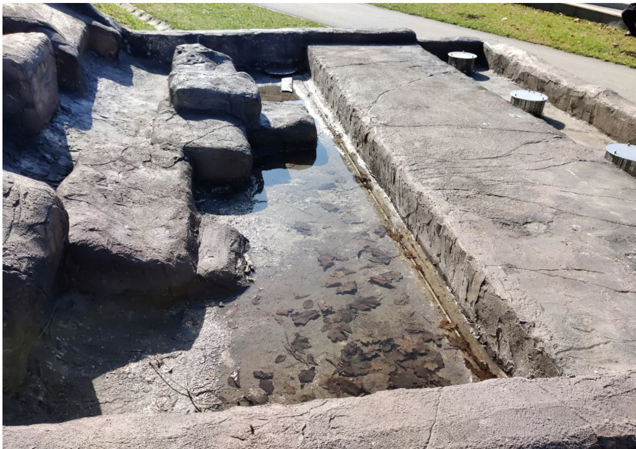
Fot. 23 Przyciótek dolny wodospadu wysokiego - koryto odpływowe
