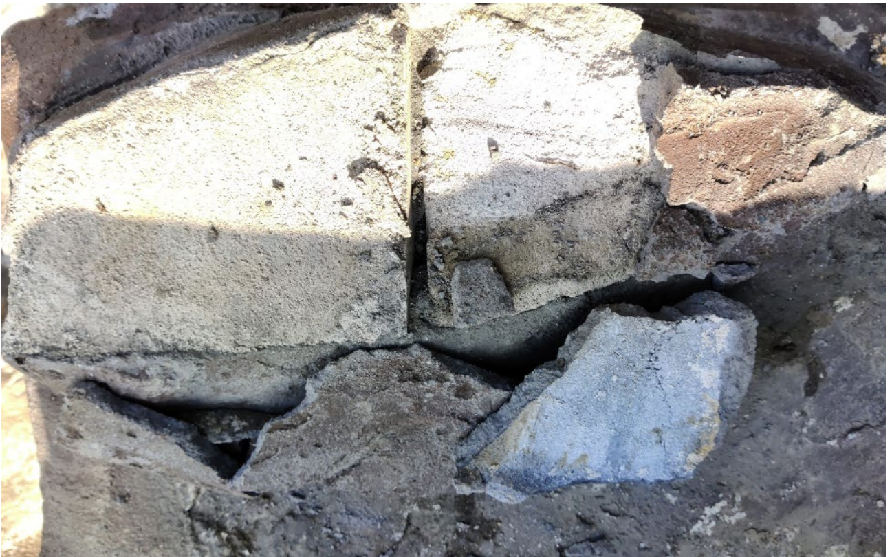
Fot. 19 Gazobeton w konstrukcji koryta wodospadu
