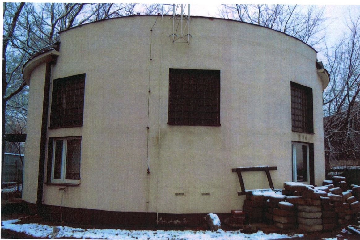
Pompownia centralna – elewacja południowa
