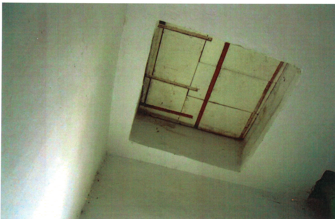
Pompownia centralna – wyjście na dach
