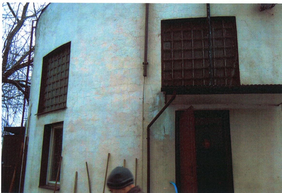
Pompownia centralna – elewacja południowa
