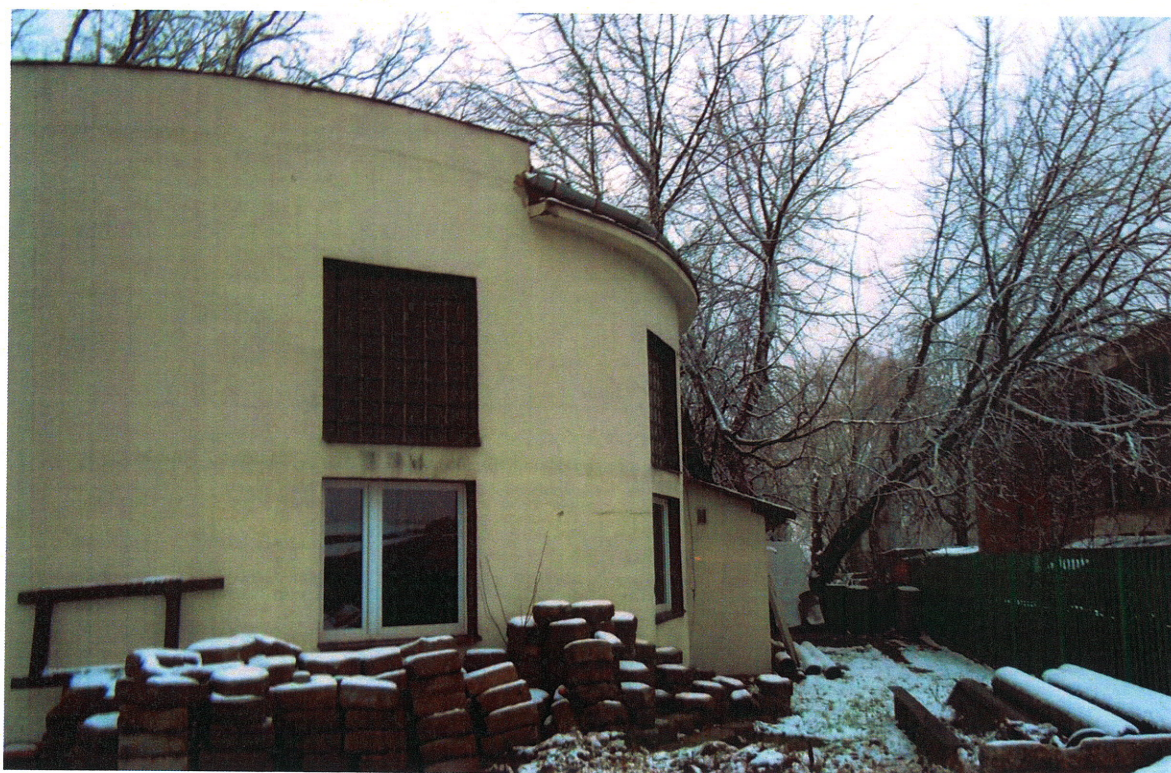
Pompownia centralna – elewacja wschodnia
