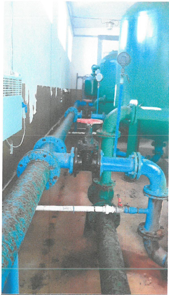
Aerator , rurociągi technologiczne
