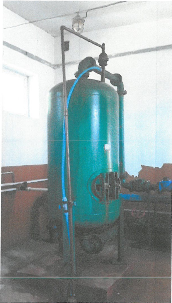
Aerator , rurociągi technologiczne
