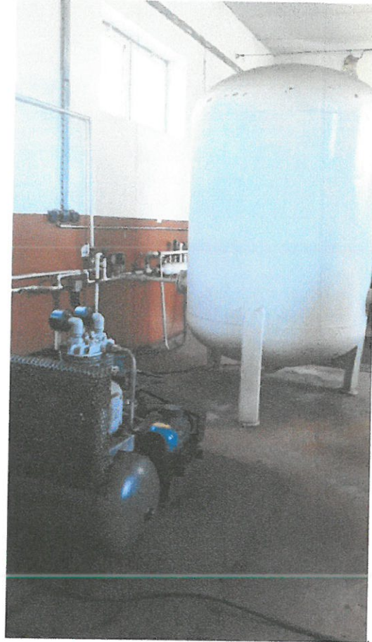
Układ przygotowania powietrza technologicznego
