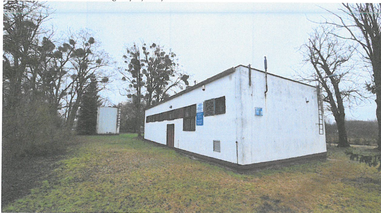
Istniejący budynek SUW
