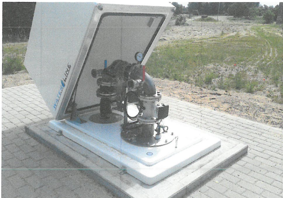
Przykładowa naziemna termoizolacyjna obudowa studni głębinowej
