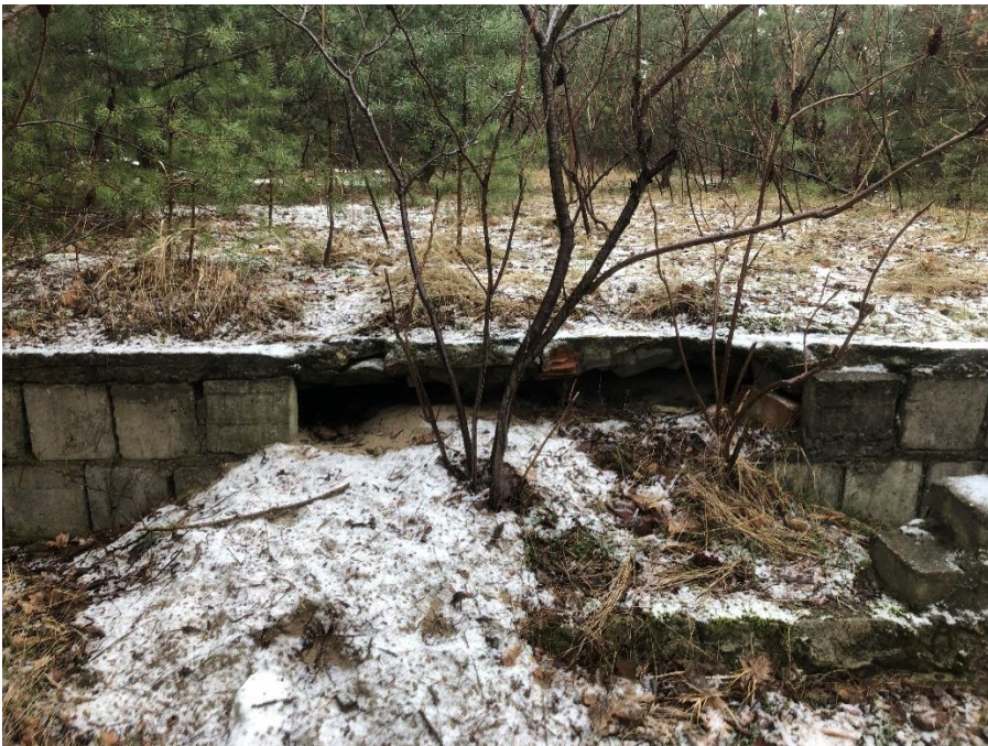
Fundamenty zlokalizowane w południowo-wschodniej części opracowywanego terenu- widok od strony południowej
