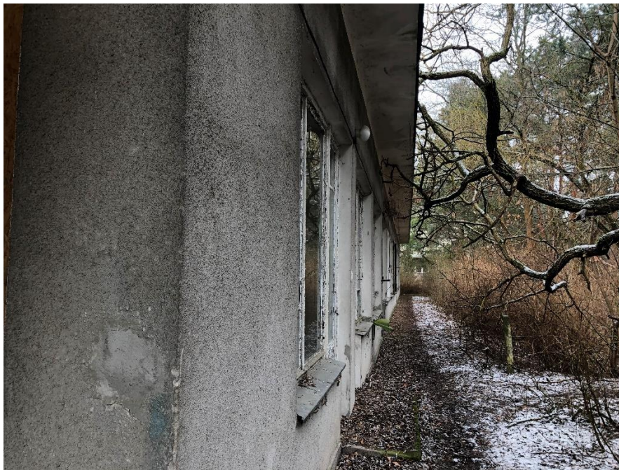
Budynek nr 2 zlokalizowany w centralnej części opracowywanego terenu- widok od strony północnej
