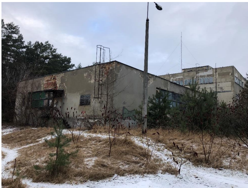
Budynek nr 1 zlokalizowany w północno- zachodniej części opracowywanego terenu- widok od strony południowo wschodniej
