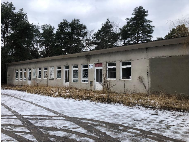
Budynek nr 2 zlokalizowany w centralnej części opracowywanego terenu- widok od strony wschodniej
