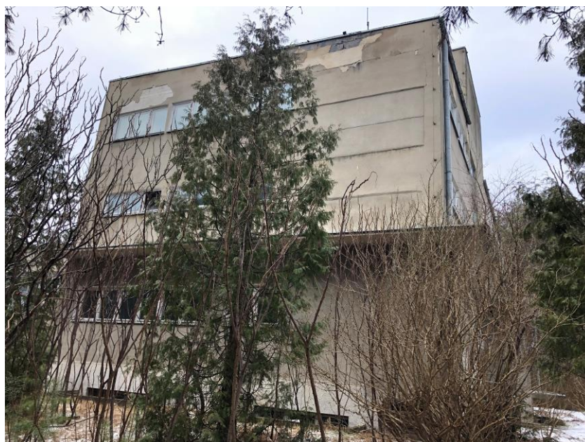
Budynek nr 1 zlokalizowany w północno- zachodniej części opracowywanego terenu- widok od strony zachodniej
