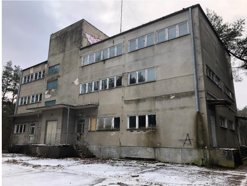
Budynek nr 1 zlokalizowany w północno- zachodniej części opracowywanego terenu- widok od strony północnej
