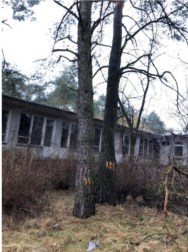
Budynek nr 2 zlokalizowany w centralnej części opracowywanego terenu- widok od strony południowo-zachodniej
