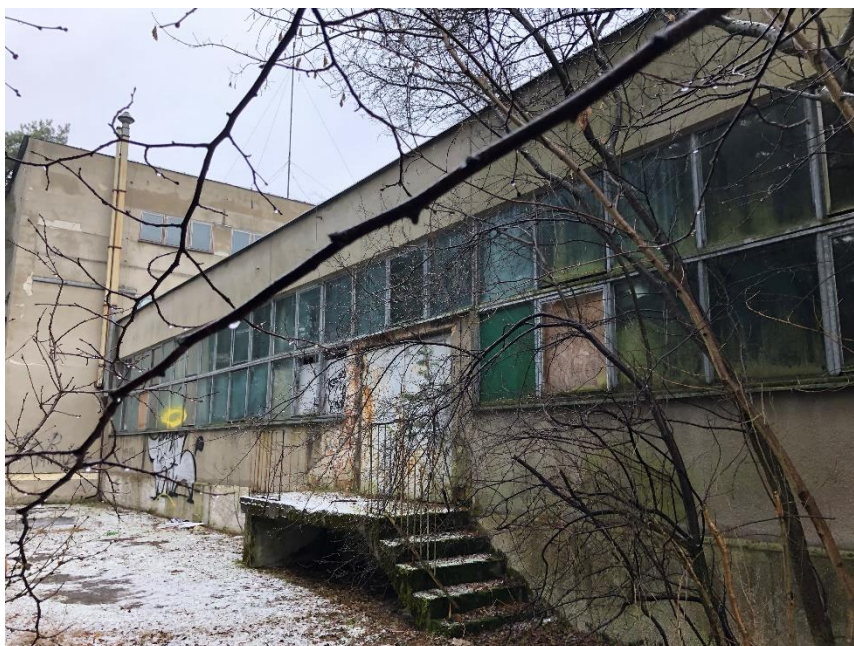
Budynek nr 1 zlokalizowany w północno- zachodniej części opracowywanego terenu- widok od strony wschodniej
