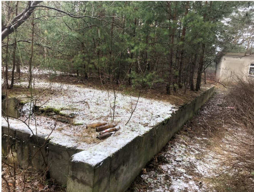
Fundamenty zlokalizowane w południowo-wschodniej części opracowywanego terenu- widok od strony południowo- wschodniej
