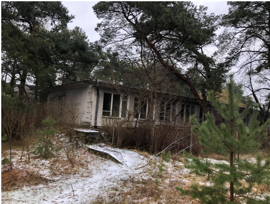
Budynek nr 2 zlokalizowany w centralnej części opracowywanego terenu- widok od strony południowo-zachodniej
