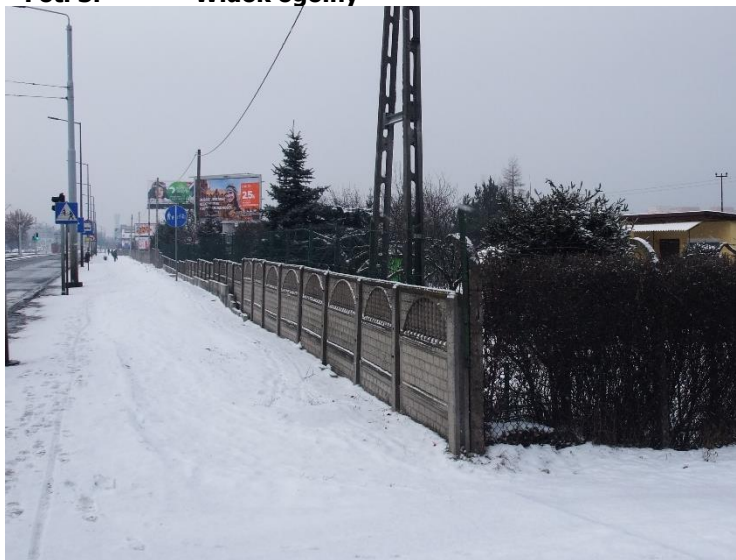
Fot. 3. Widok ogólny
