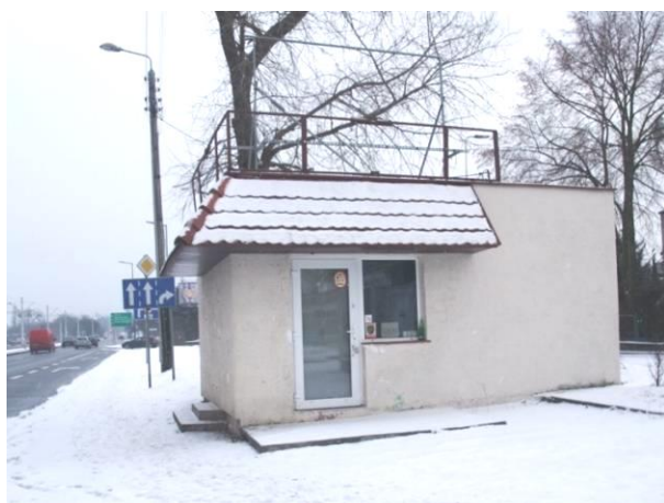
Fot. 1. Elewacja zachodnia
