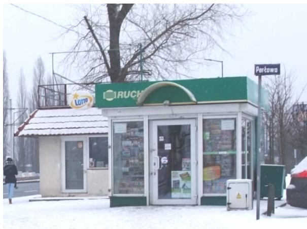
Fot. 2. Widok ogólny
