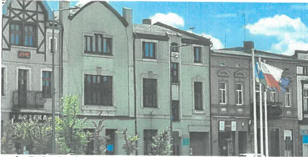
1. Budynek usługowy Mroczna Pl. 1 Maja 9 widok ogólny.
