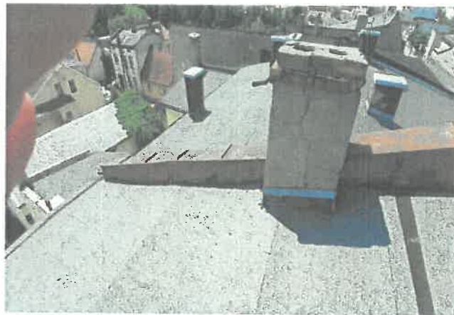
5. Dach -stan techniczny kominów, ogniomurów
