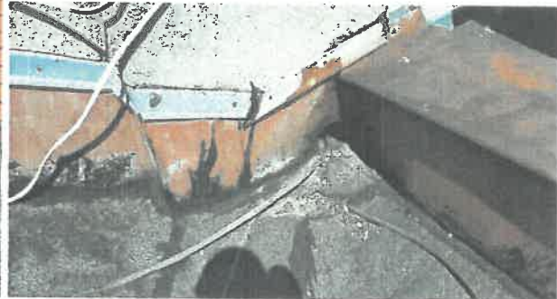
3. Spust wody z attyki -ogrzewanie elektryczne do remontu
