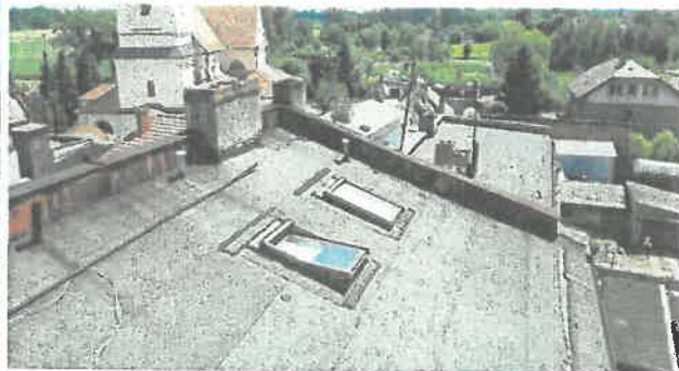
7. Dach -połąc 2 skrzydło, kominy, ogniomury, okna dachowe
