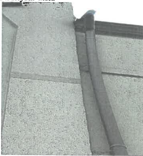
4. Elewacja frontowa -miejsce zamontowania z biorniczka spustowego i nowych rur spustowych
