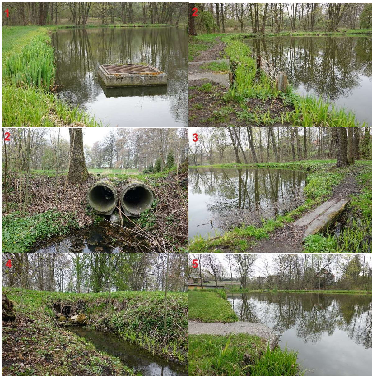
Fot. 9 Widok wiosną obecnej infrastruktury technicznej (fot. własne), przy czym numeracja pkt jest zgodna z oznaczeniami na Rys.2, tj.: pkt 1- zdjęcie podł, pkt 2 - zdjęcie awaryjnych przepustów betonowych, pkt 3 – zdjęcie kładki drewnianej, pkt 4- wlot do stawu (naturalna komora sedymentacyjno-filtracyjna), pkt 5 - miejsce przepływu awaryjnego do zalewisk z roślinnością bagienną
