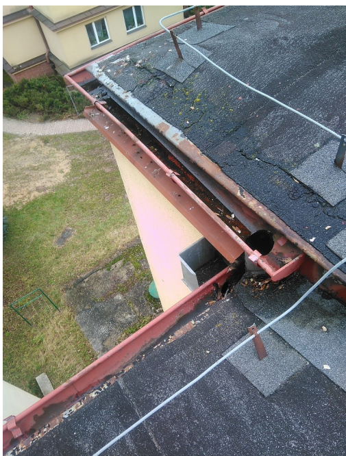
Widok nr 2. Elewacja rynny i kosza od strony balkonowej
