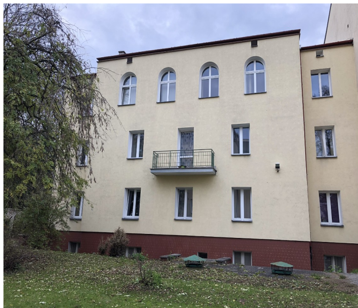
Widok nr 1. Elewacja od strony balkonu
