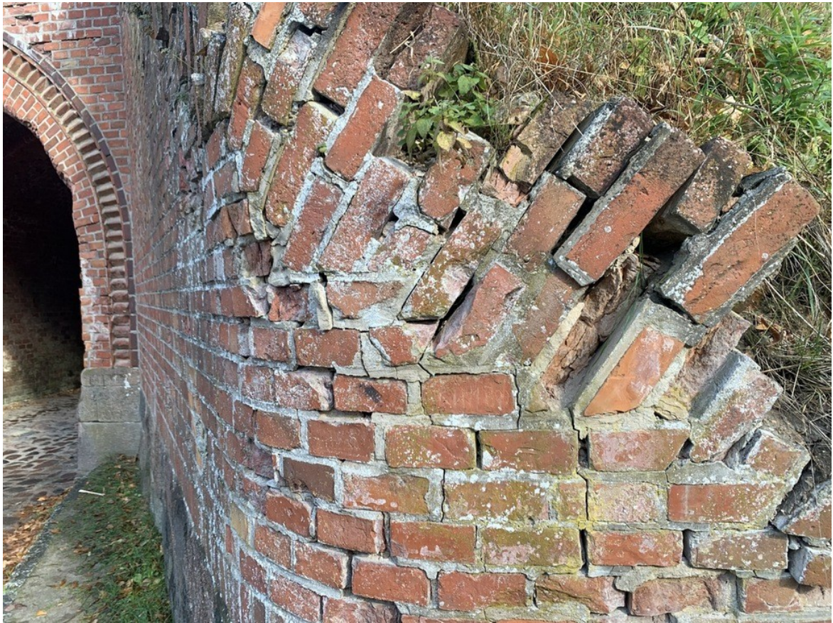
Stan zachowania murów
