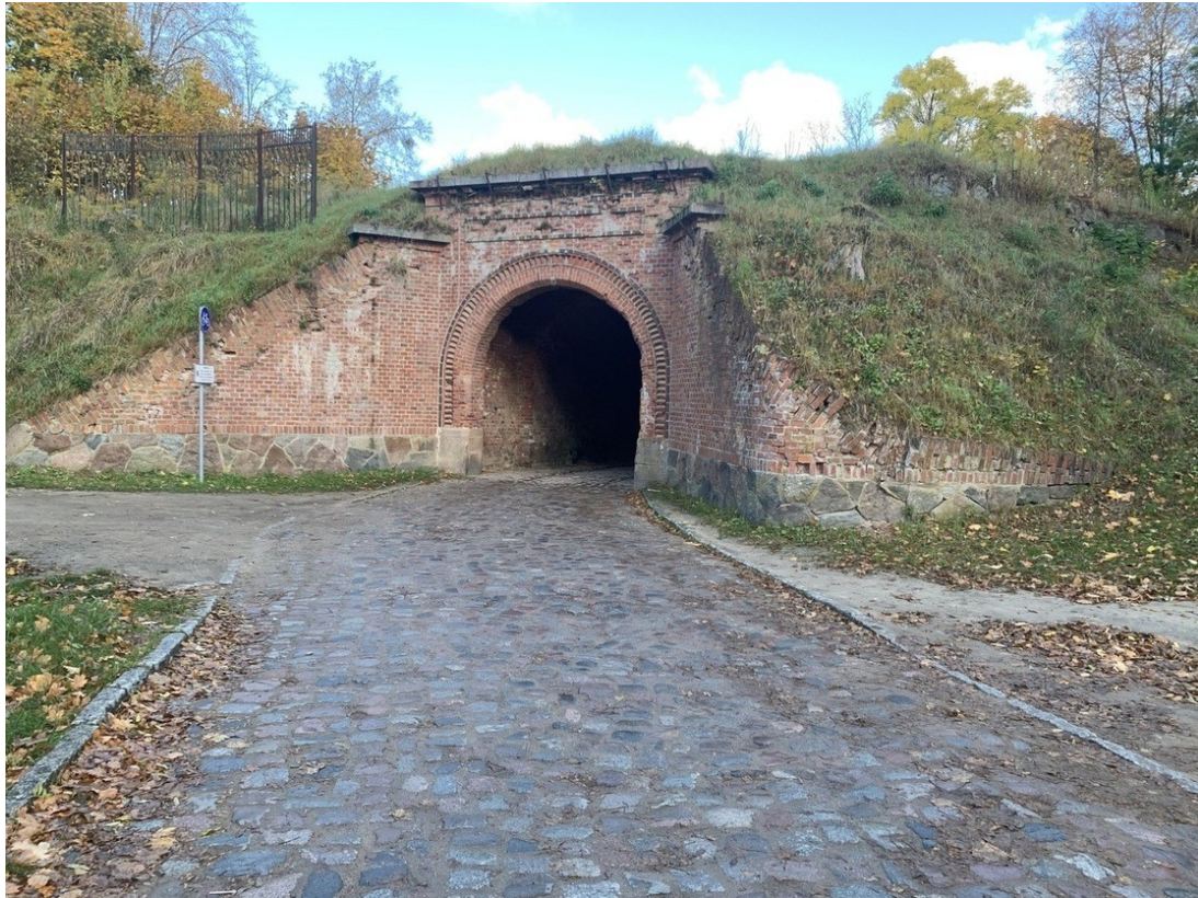
Widok ogólny od strony Bramy Giżyckiej
