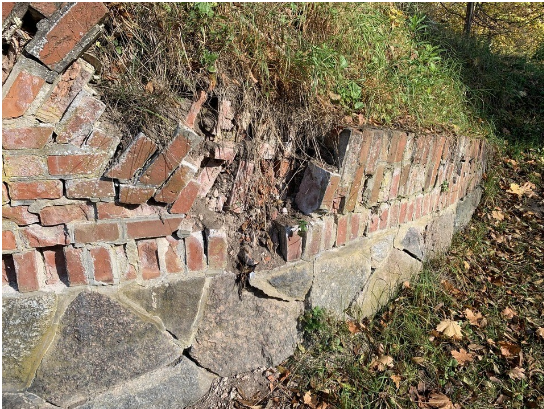
Stan zachowania murów
