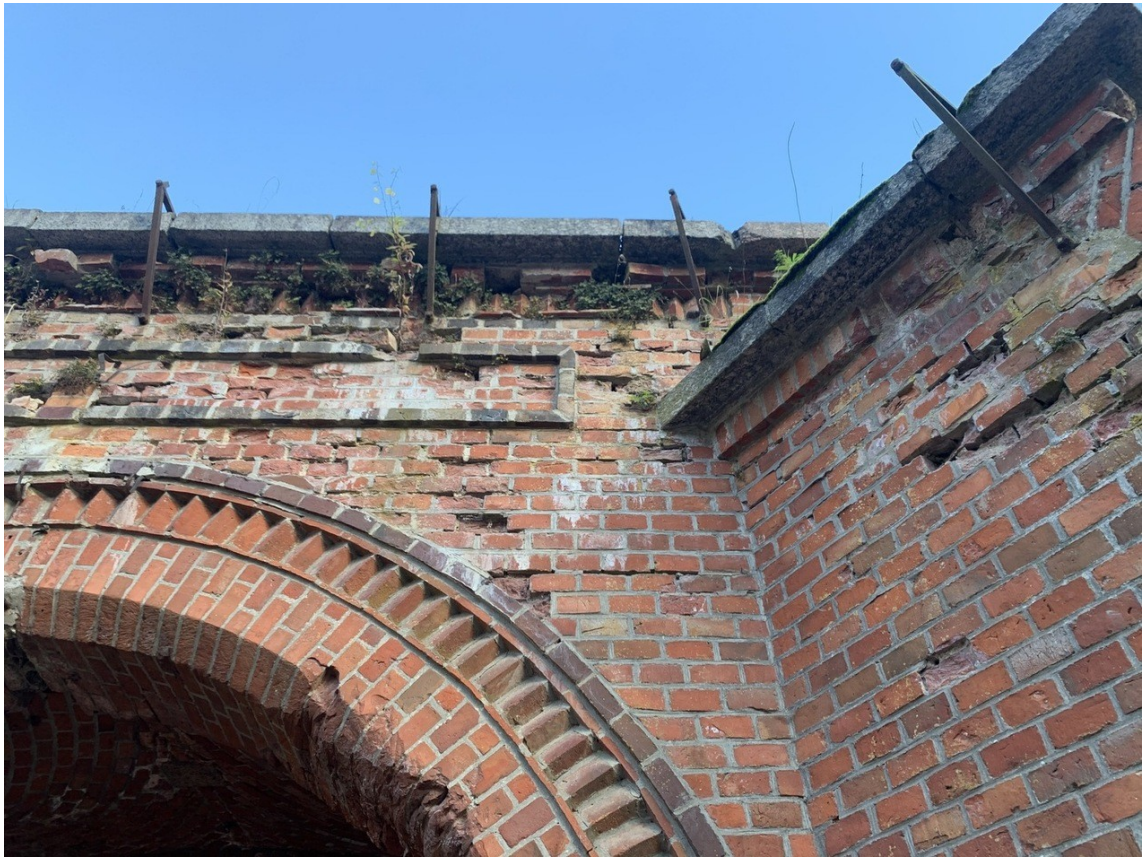
Stan zachowania murów
