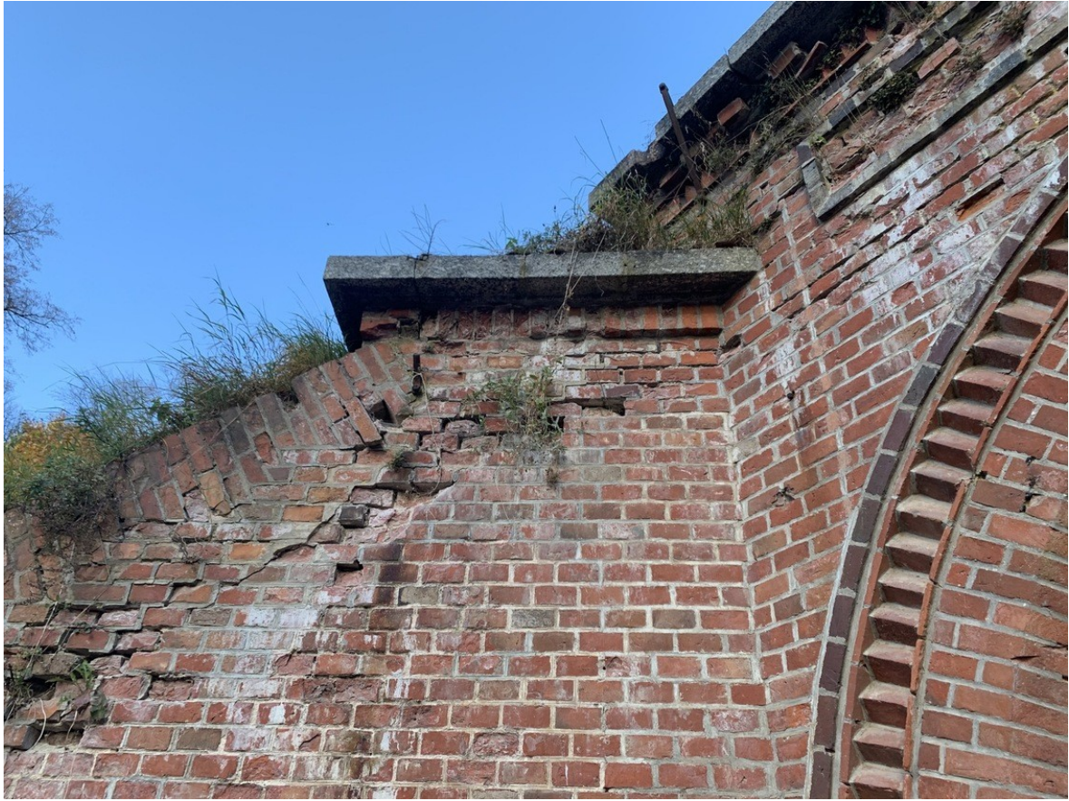
Stan zachowania murów
