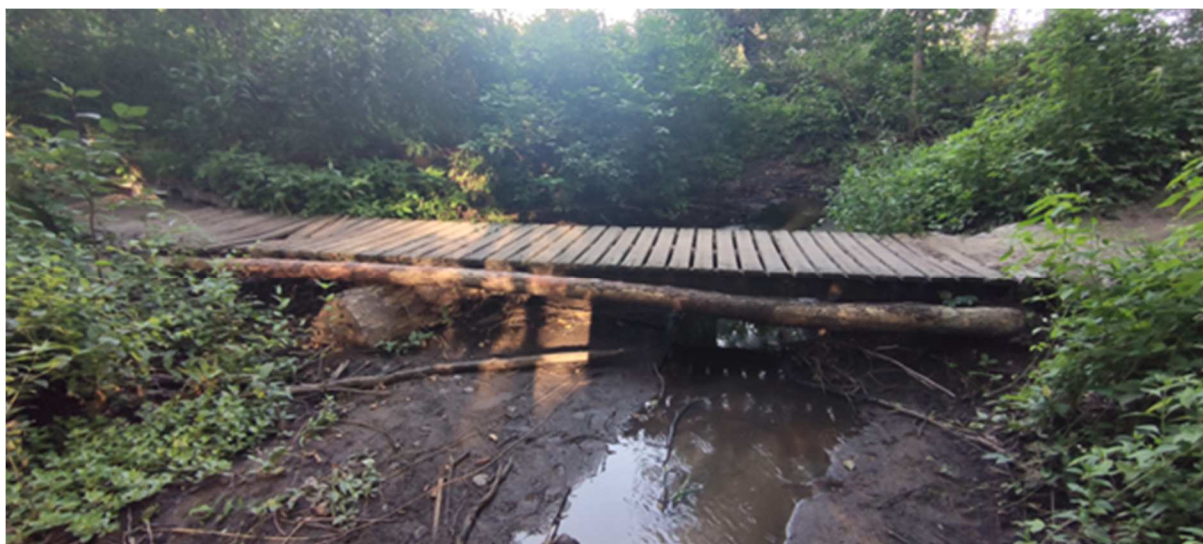
Fot. 2 – Widok na kładkę w kierunku Warty
