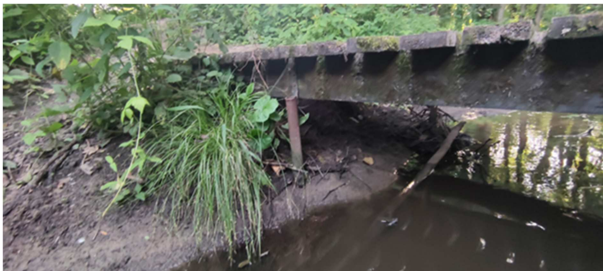
Fot. 4 – Widok na rurkę stalową, podparcie kładki
