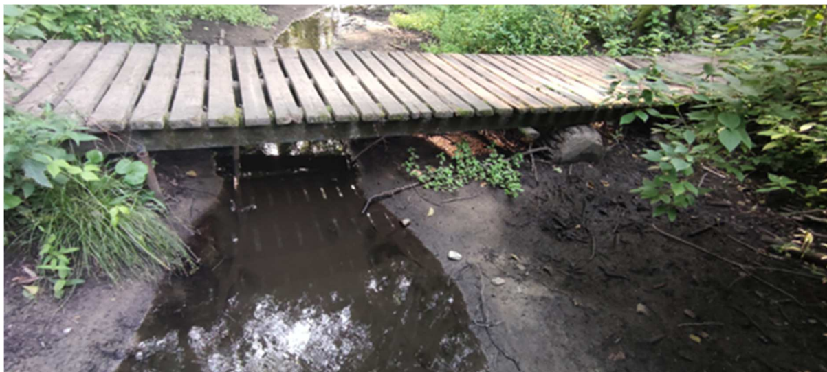
Fot. 1 – Widok na kładkę od strony Warty
