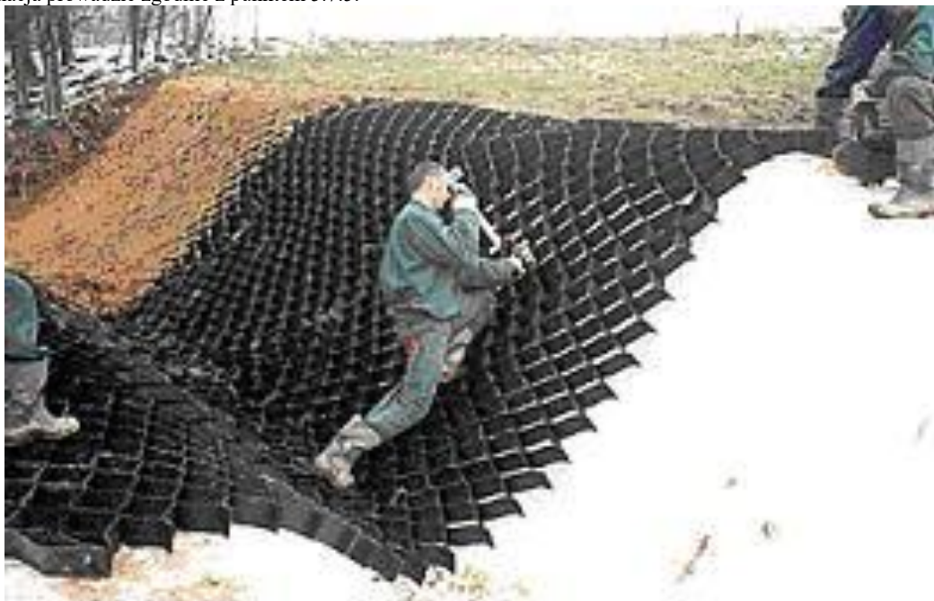
Rys. nr 2 Układanie geokomórek.
