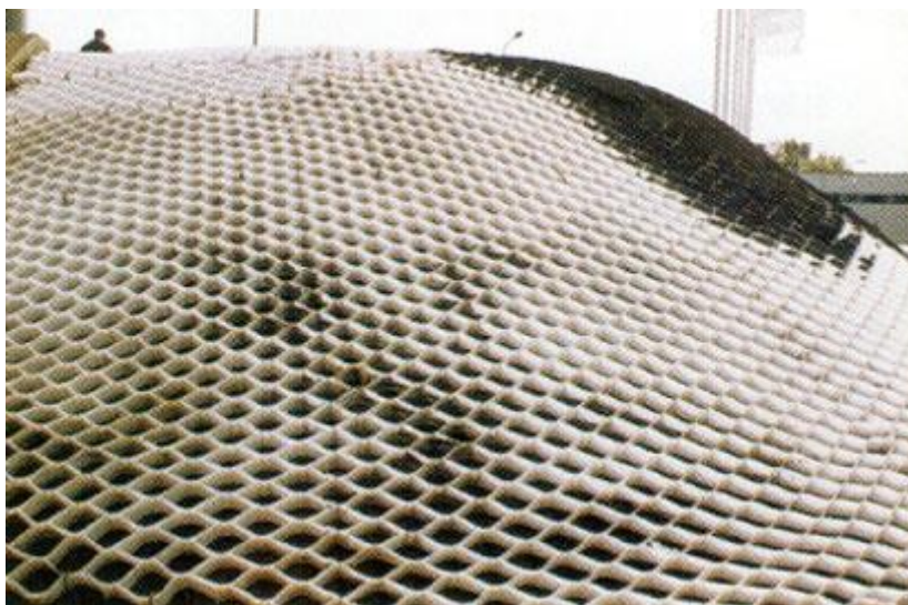
Rys. nr 4 Zasypywanie humusem.
