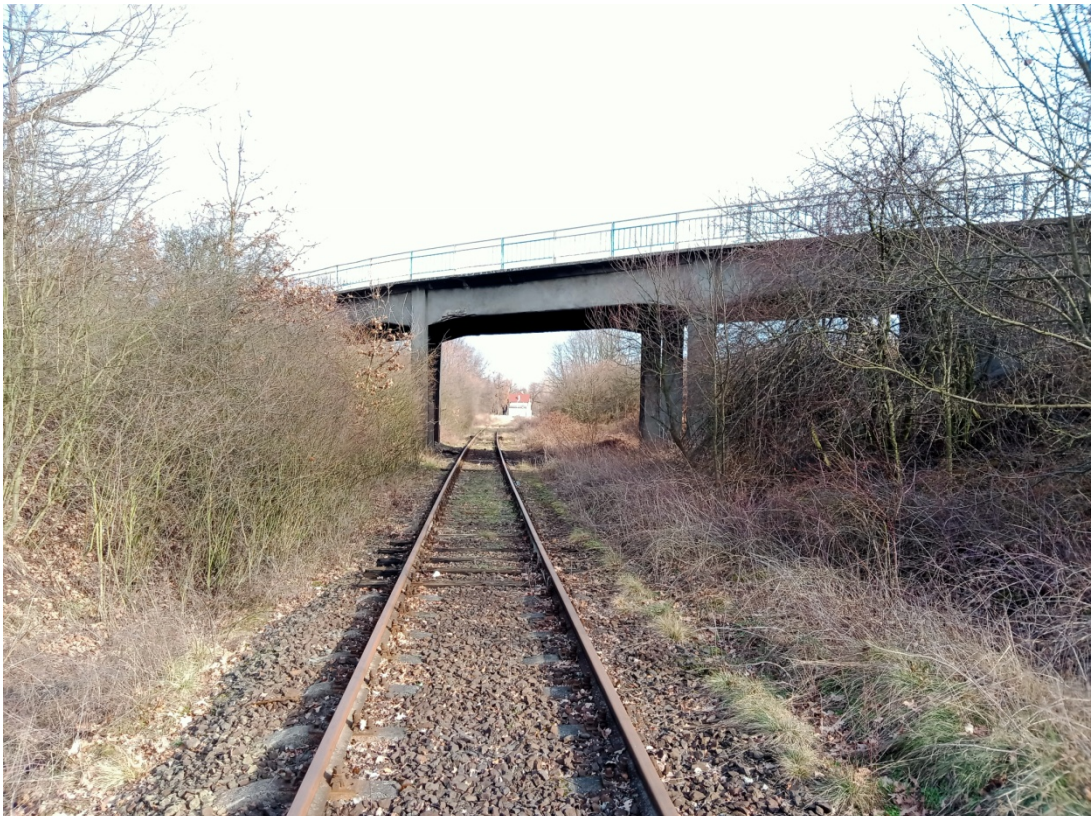
Foto nr 3 – Widok na obiekt z poziomu toru kolejowego (widok od strony zachodniej) .
