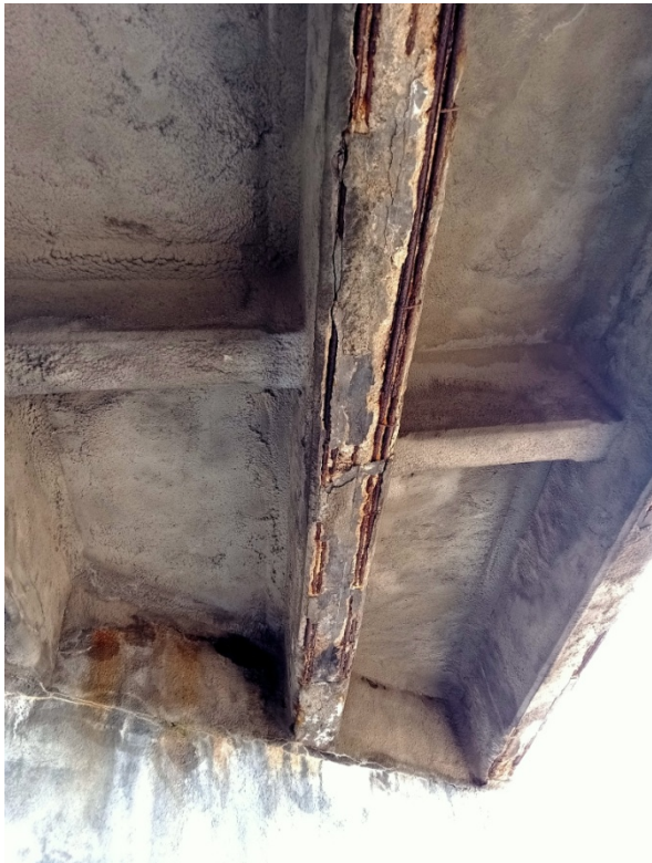
Foto nr 8 i 9 – Spód ustroju niosącego – typowe uszkodzenia / przewód podwieszony do konstrukcji obiektu;
