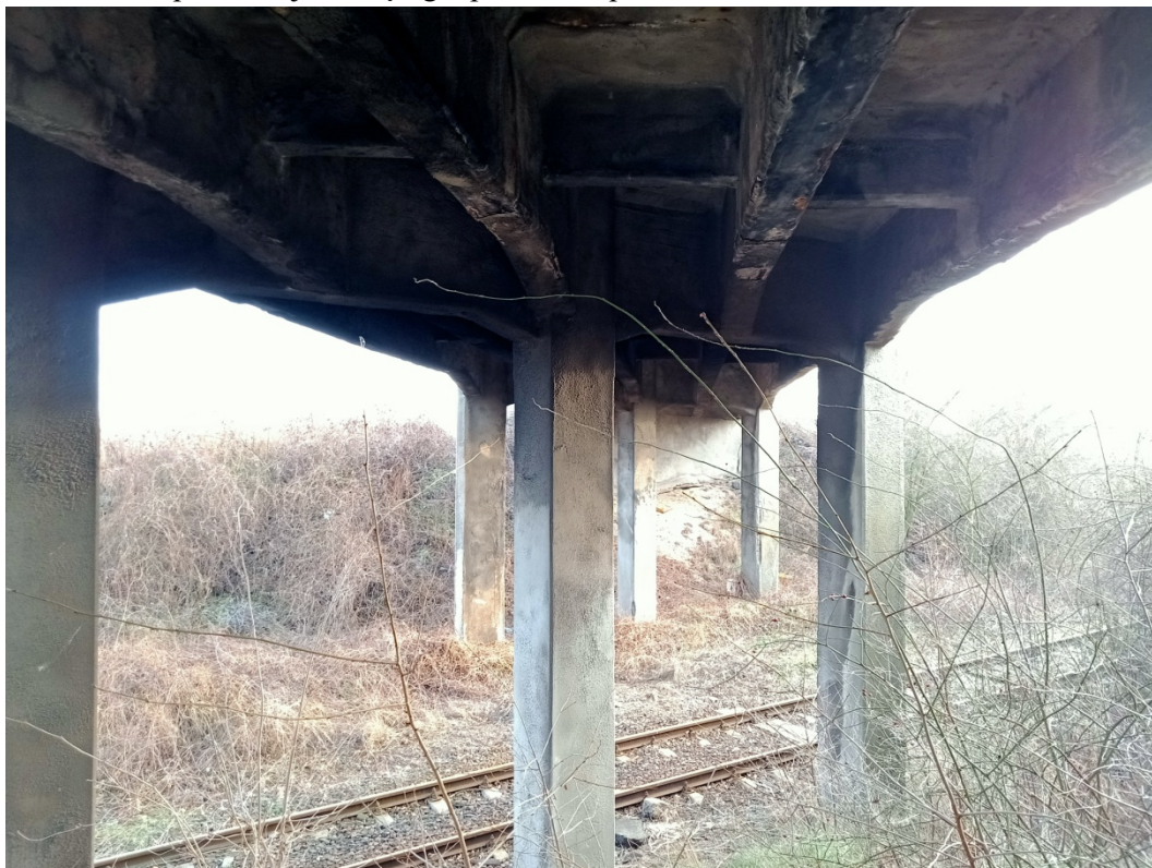
Foto nr 4 – Spód ustroju niosącego, przestrzeń pod obiektowa;
