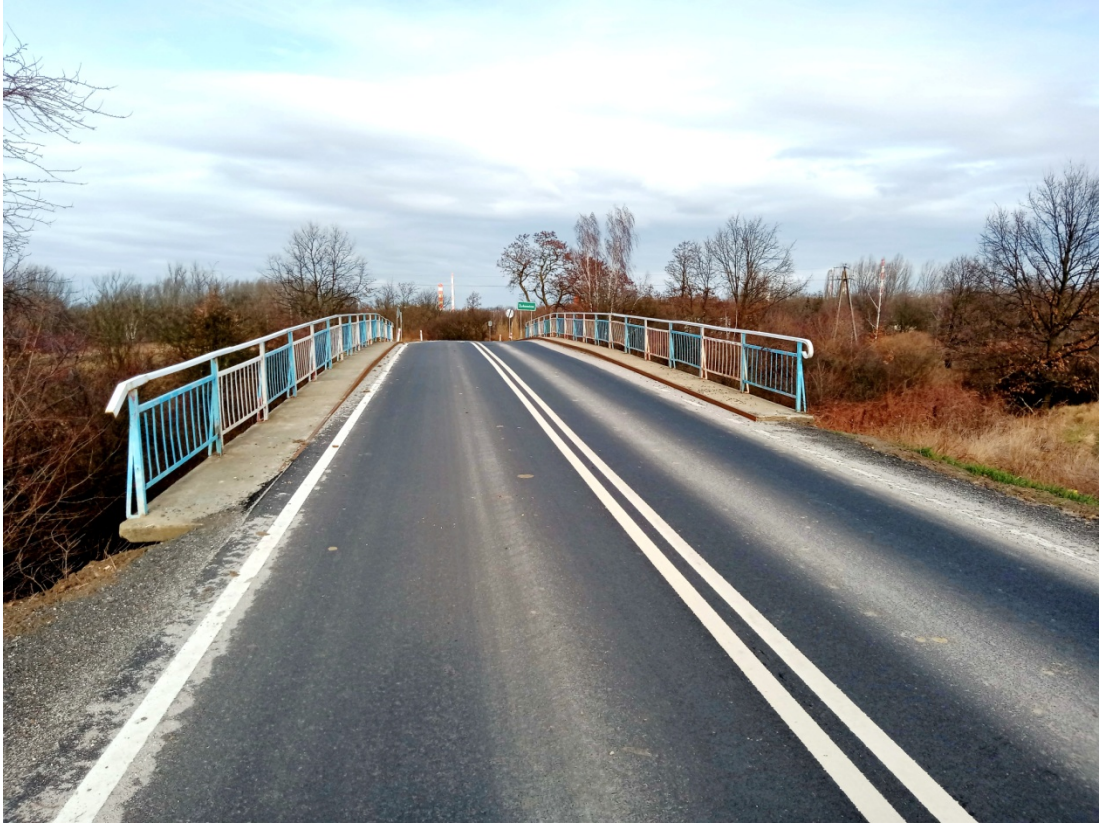
Foto nr 2 – Widok na obiekt z poziomu jezdni drogowej (widok od strony m. Nielubia) .
