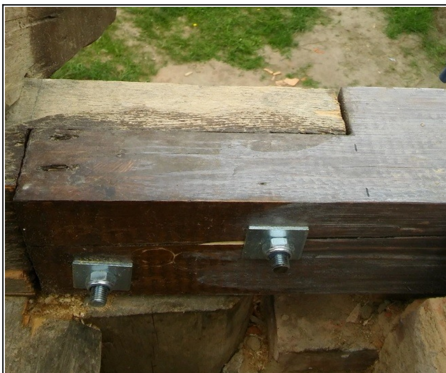
Fot. nr 3 – Sposób łączenia wymienianego fragmentu belki stropowej z istniejącą częścią belki
