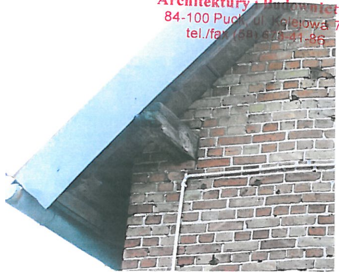
Fot. 7 Frag. ściany północnej przy narożniku wsch. z uszkodzoną płatwią i ubytkami cegieł i zapraw
