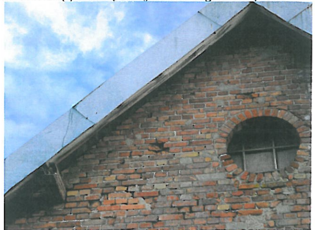
Fot. 7 Frag. ściany północnej przy narożniku wsch. z uszkodzoną płatwią i ubytkami cegieł i zapraw
