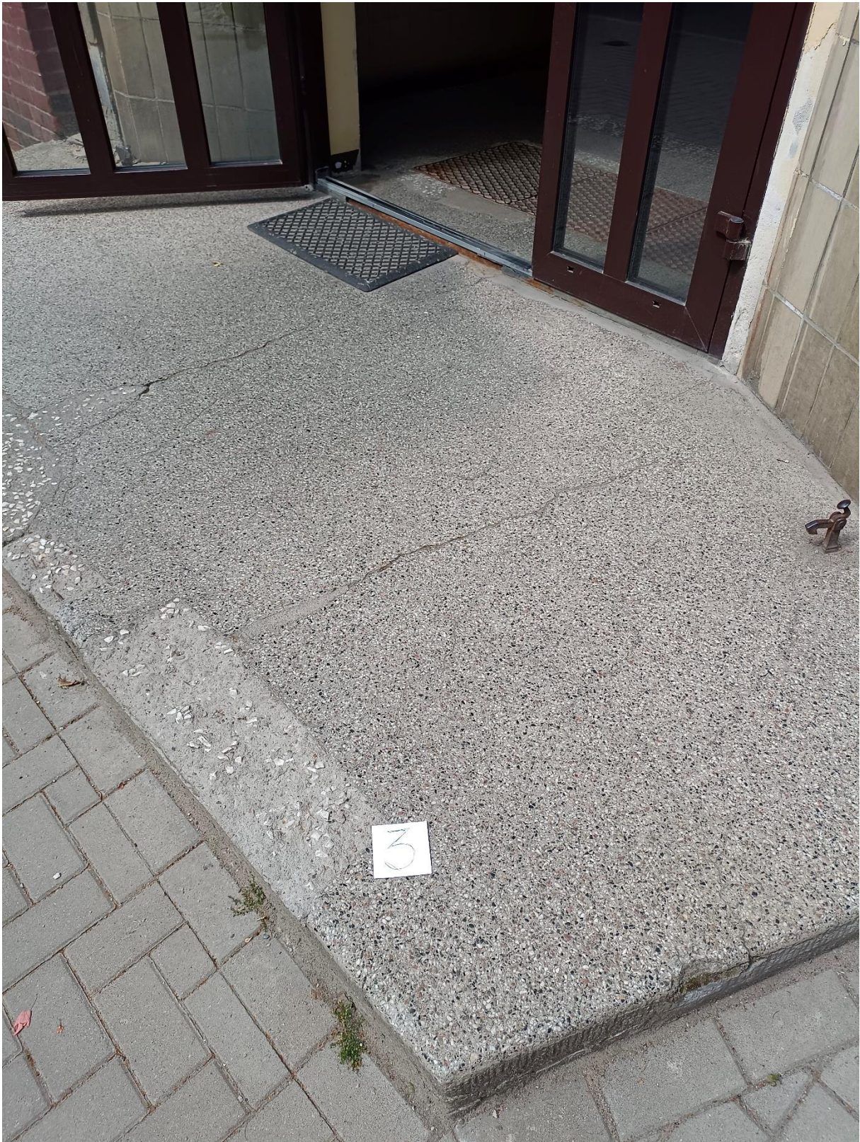
Schody wejściowe do budynku nr 3
