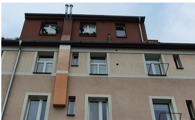
Fot. nr 1 i nr 2 Elewacja tylna (południowo-wschodnia)
