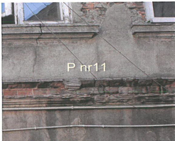
Zd.11. Miejsce pęknięcia nr 11 konstrukcyjne ściany pasa międzyokiennego pomiędzy drugą a trzecią kondygnacją przybudówki do oficyny.
