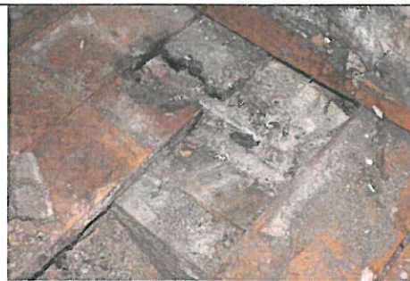
Zd.33. Przykładowe badanie stanu technicznego stropu w miejscu istniejącej destrukcji.
