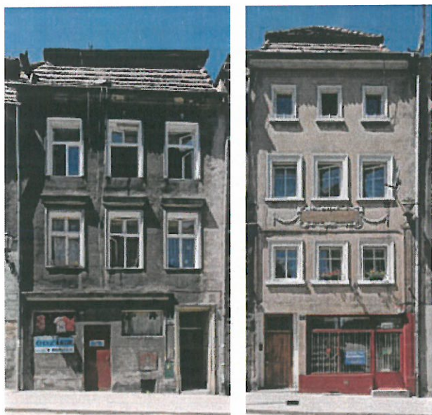
Rys. 2. Widoki na fasady budynków przy ul. Kościelnej 1 i 3
