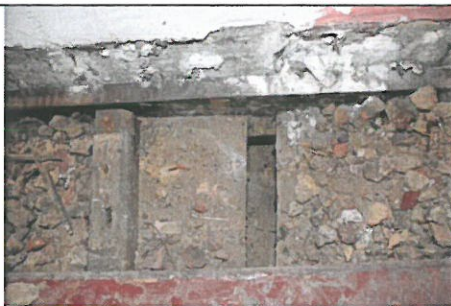
Zd.32. Przykładowe badanie stanu technicznego stropu w miejscu istniejącej destrukcji.
