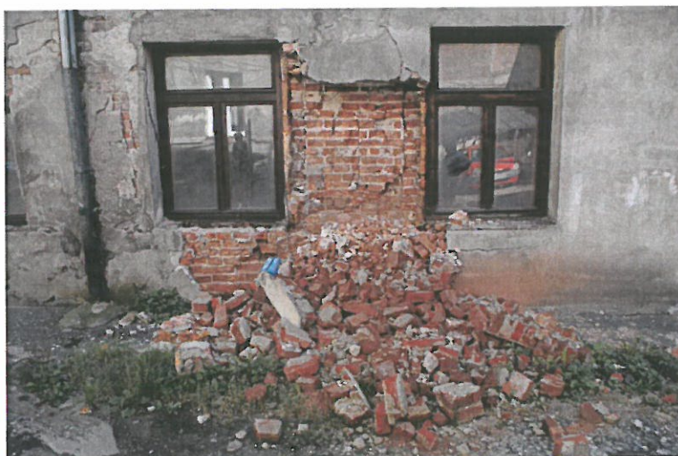
Zd.11. Miejsce pęknięcia nr 11 konstrukcyjne ściany pasa międzyokiennego pomiędzy drugą a trzecią kondygnacją przybudówki do oficyny.
