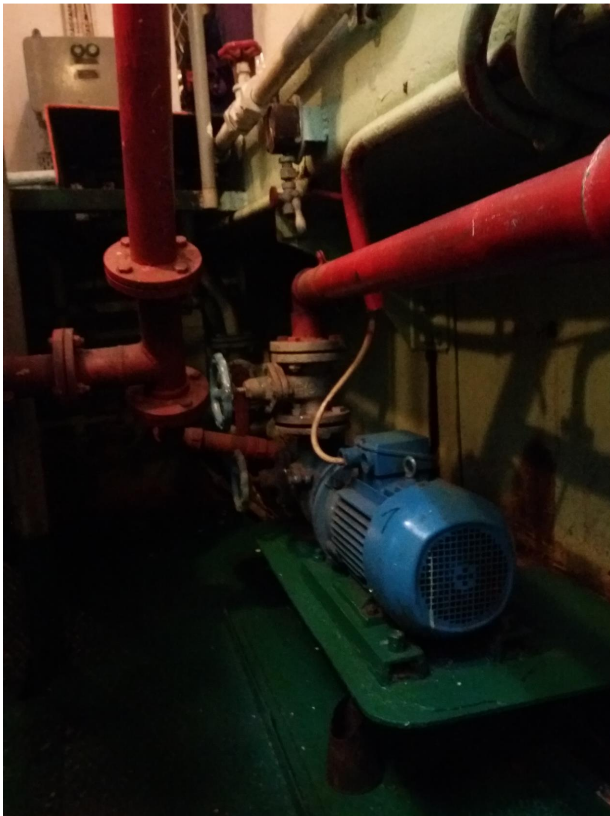
Zdjęcie 15 pompa fekalii z silnikiem
