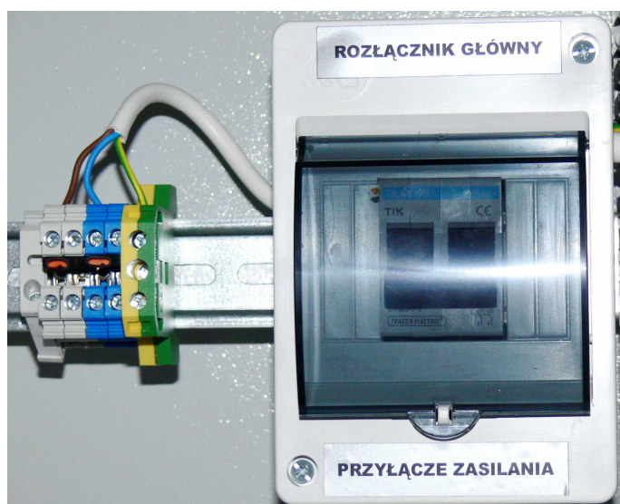
rys. 6. Rozłącznik główny i złącze zasilania peryferiów
