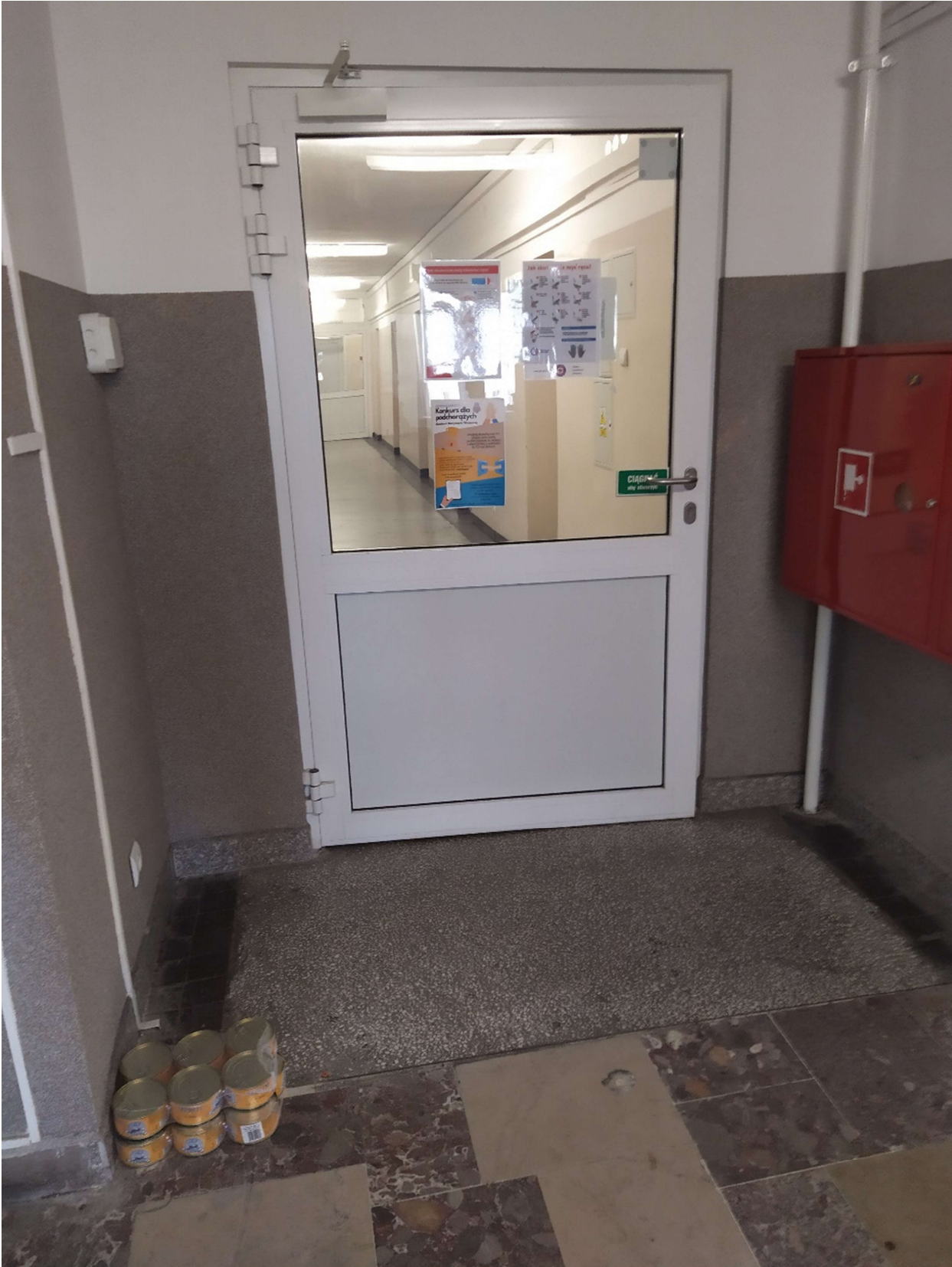
Drzwi aluminiowe przeszklone jednoskrzydłowe EI 30 o wymiarach 125 cm x 210cm( naprawa)
