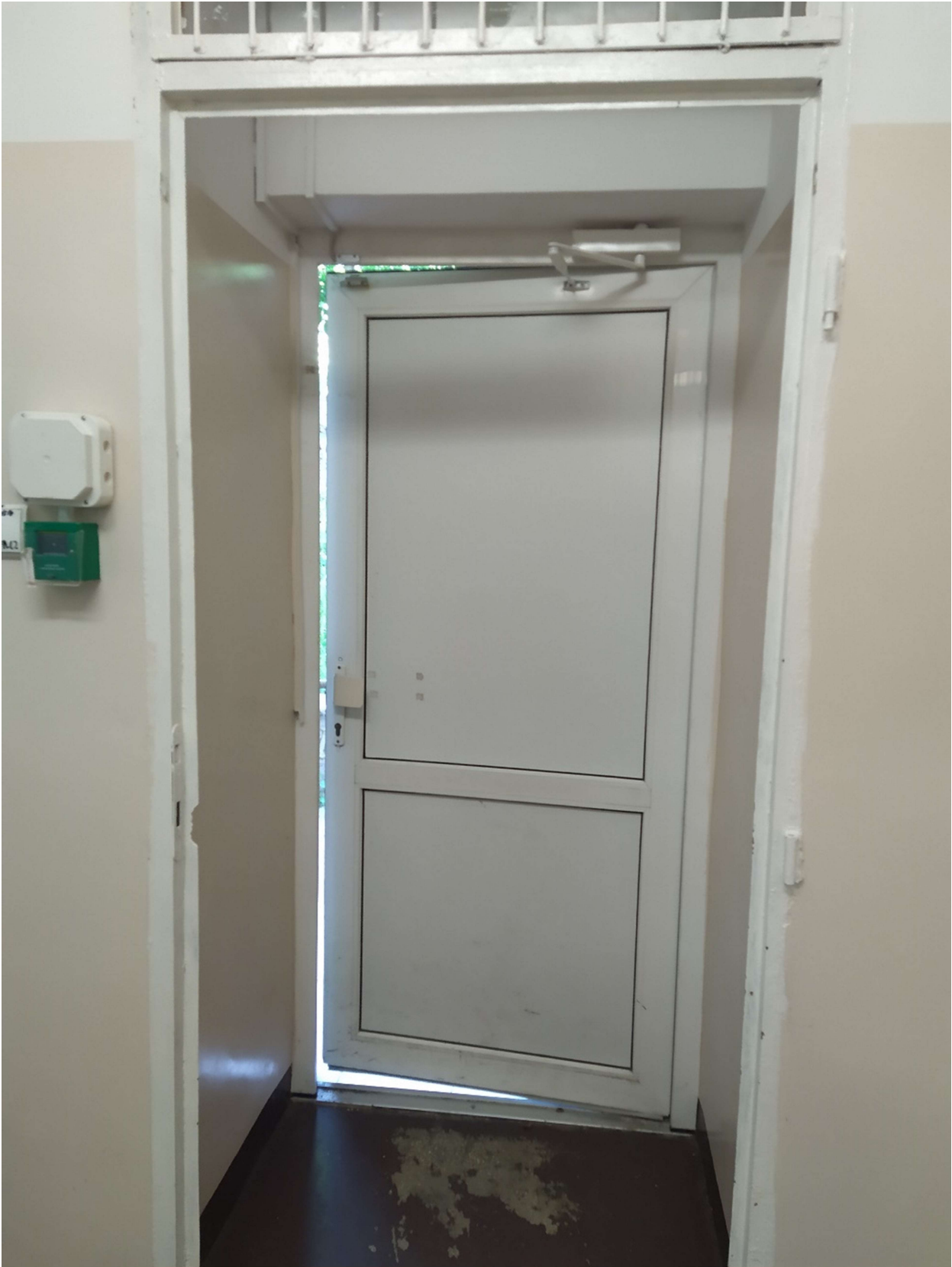
Drzwi stalowe lub aluminiowe jednoskrzydłowe ewakuacyjne o wymiarach 98cmx 206cm(naprawa)
