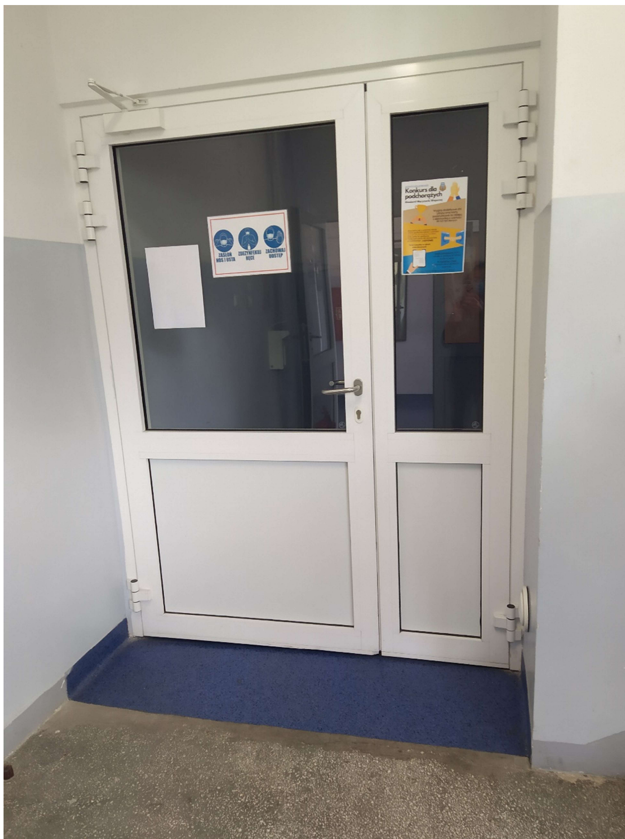
Drzwi aluminiowe przeszklone dwuskrzydłowe EI 30 o wymarach 160cm x 206cm (naprawa)
