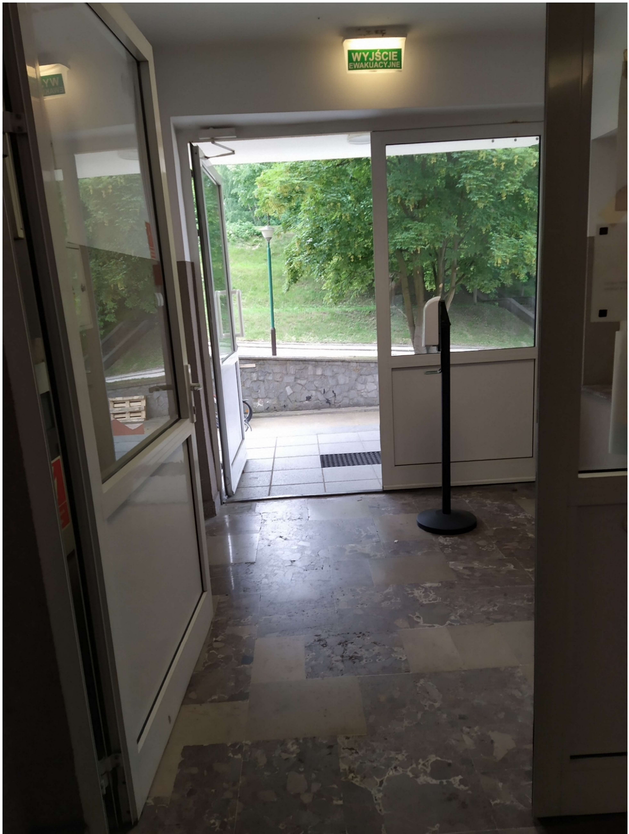
Drzwi zewnętrzne ewakuacyjne dwuskrzydłowe 240cm x 240cm
