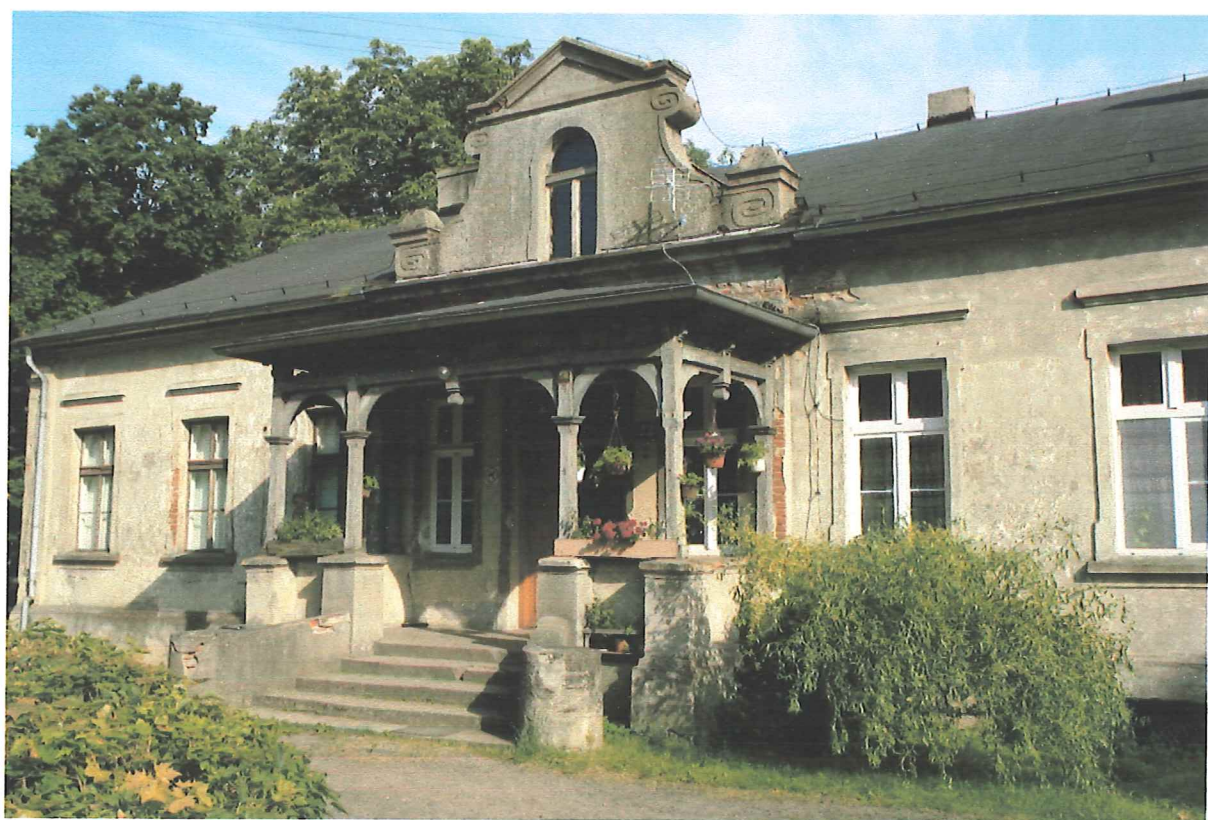
Ryc. 4. Elewacja frontowa, ganek
