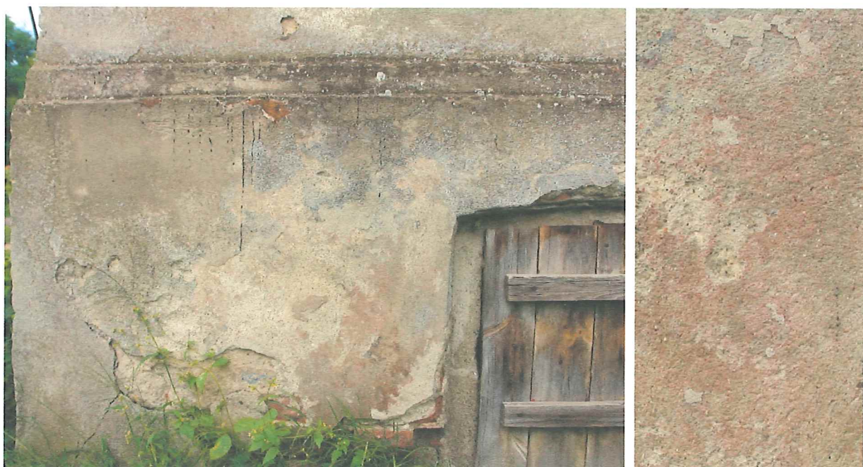
Cokół budynku , narożnik południowo zach. Jedyny zachowany fragment oryginalnego tynku z resztkami malowania w kolorze sieni palonej. Odcień w RAL 8004
