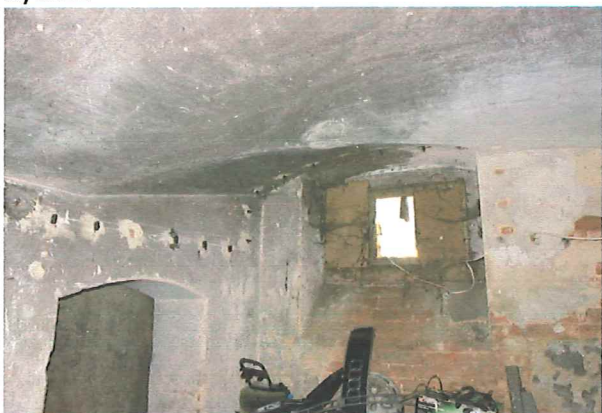
Ryc. 24 -27 Otwory okienne piwnicy
