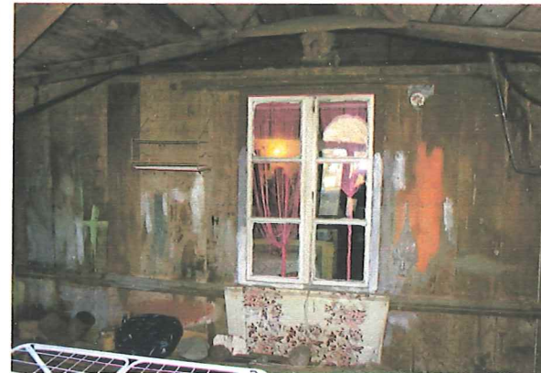
Ryc. 16 Okno doświetlające wnętrze korytarza części mieszkalnej poddasza.
