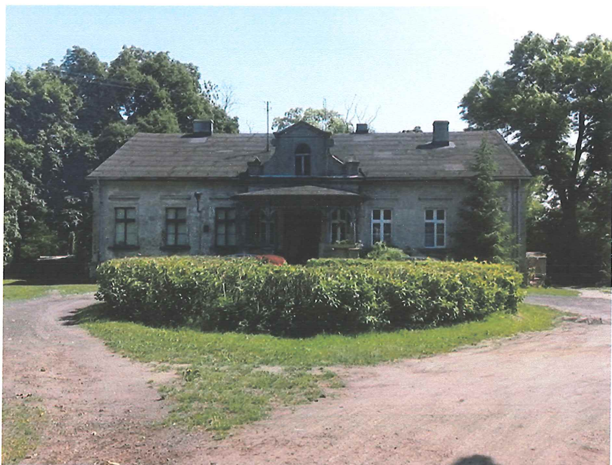
Ryc. 3. Elewacja frontowa, strona północno-zachodnia
