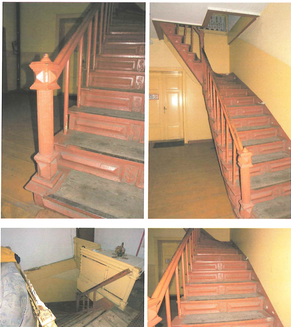
Ryc. 11,12,13,14. Schody drewniane prowadzące do pomieszczeń poddasza
