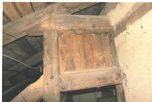
Ryc. 18 Połączenie konstrukcyjne przy ścianie stolcowej
