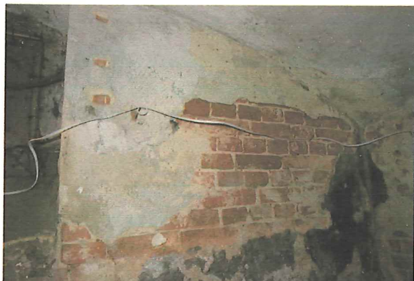
Ryc. 30 Ściana fundamentu z widocznym układem cegieł w wążku krzyżowym.
