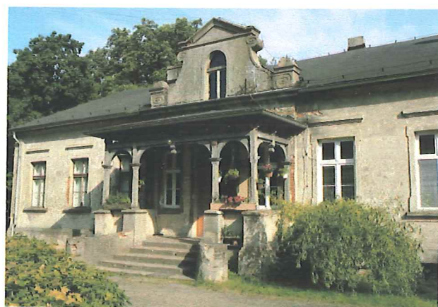
Ryc. 4. Elewacja frontowa, ganek
