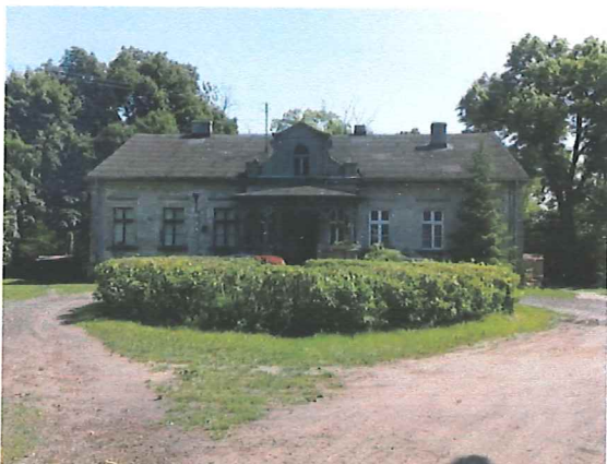
Ryc. 3. Elewacja frontowa, strona północno-zachodnia
