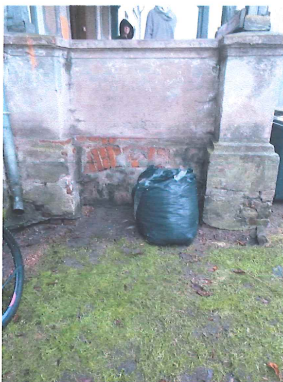
Ryc. 45 Balustrada murowana tarasu wejściowego. W części przyziemia widoczny łuk oporowy lub kolebka –strop, na którym położony jest podest tarasu
