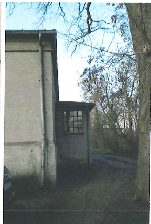
Ryc.10. Przybudówka do ściany północno wschodniej wejścia do biblioteki
