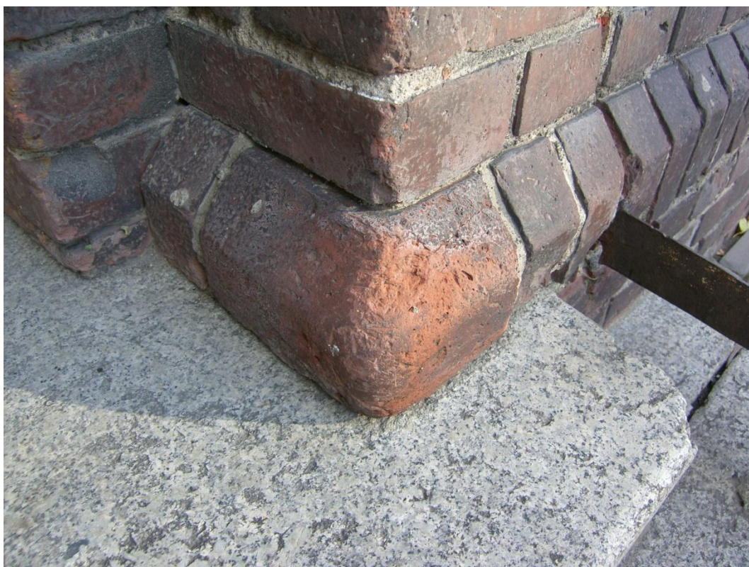
10. Oryginalny ceglany narożnik przy wejściu głównym. Widoczny granitowy stopień schodów.
