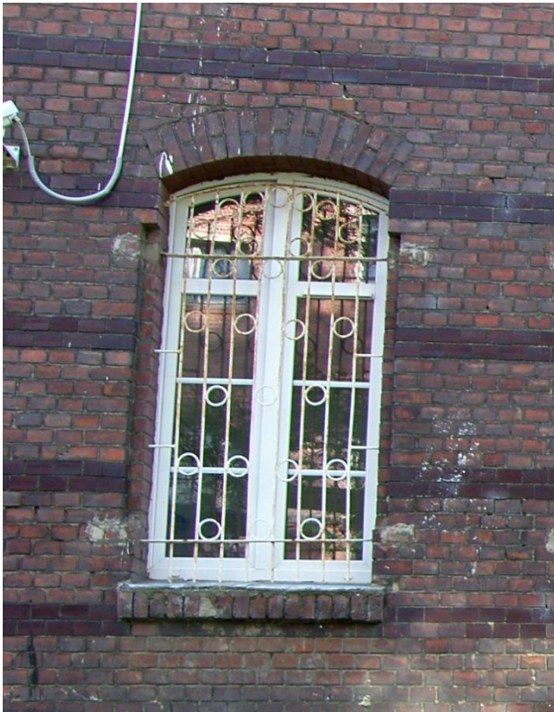
Okna z uskokiem węgarka i rolką łęku.
