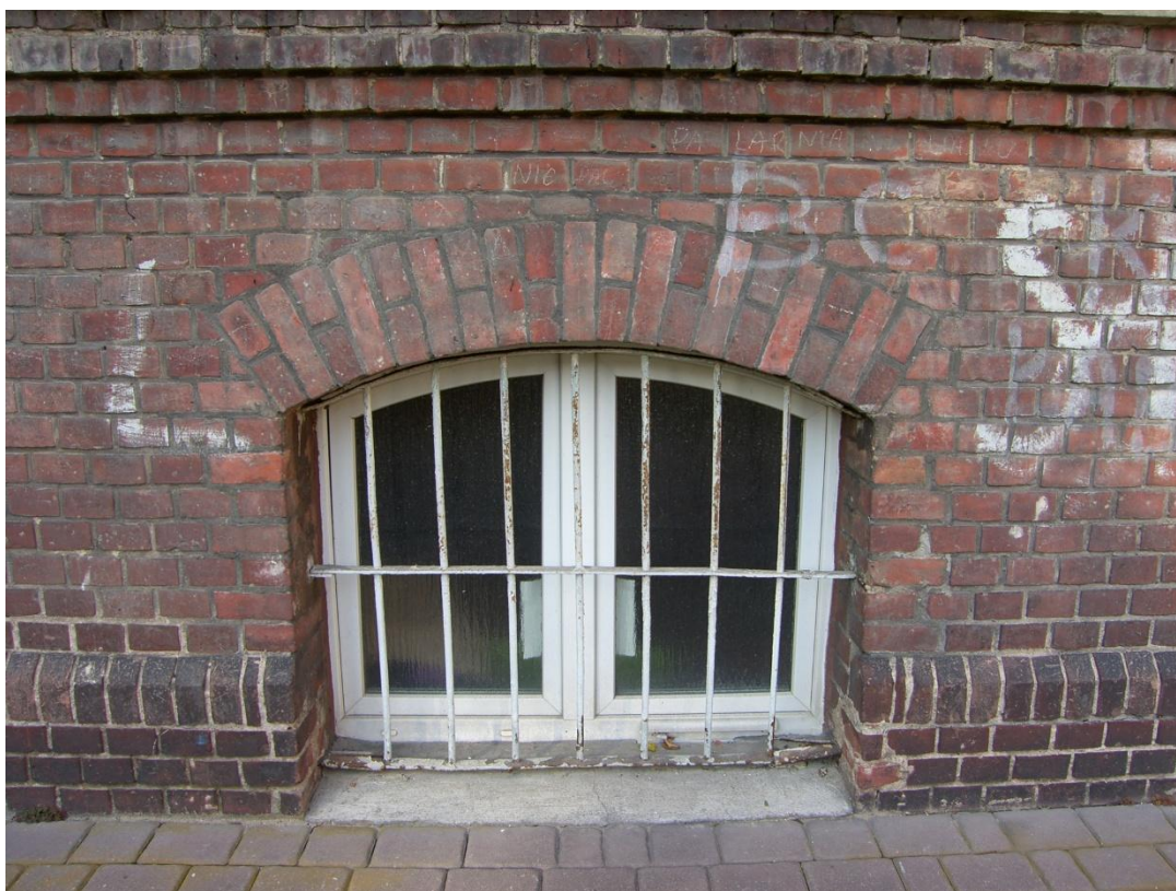
Okno przyziemia i strefa cokołowa z kształtką fazowaną.
