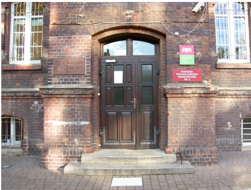
Pierwotny wykrój otworu drzwiowego wejścia południowego w uskokowym portalu.
