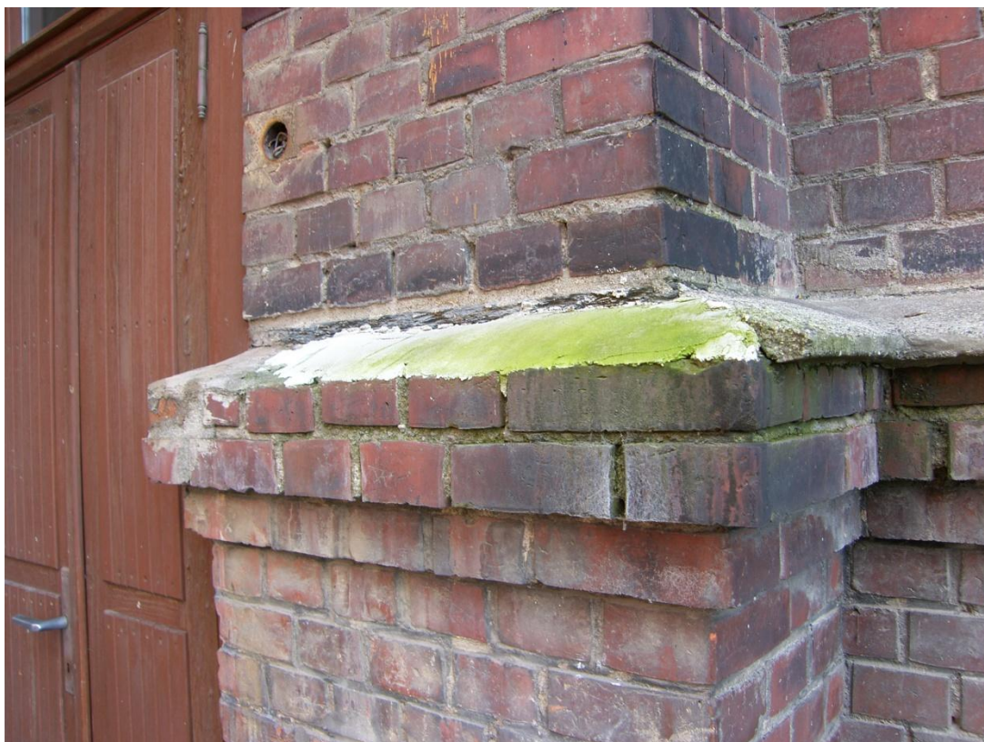
47. Wtórne uzupełnienie nakrywy gzymsu cokołowego przy wejściu wschodnim.
