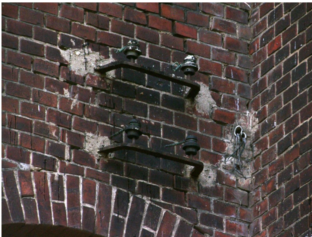
31. Pozostałości napowietrznej instalacji elektrycznej - do zachowania i konserwacji.
