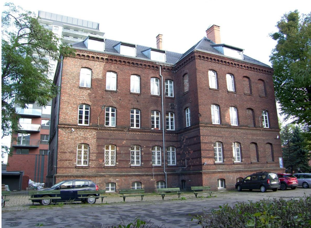
23. Widok ogólny. W narożniku północnym widoczny zakres powojennej odbudowy.
