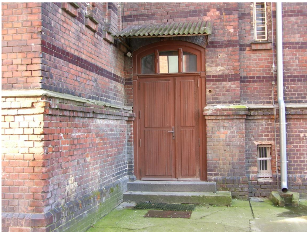
Otwór wejścia wschodniego w pierwotnym wykończeniu.
