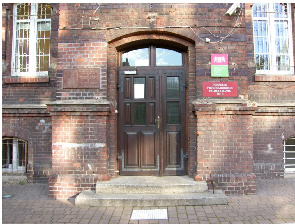
8. Wejście główne do budynku.
