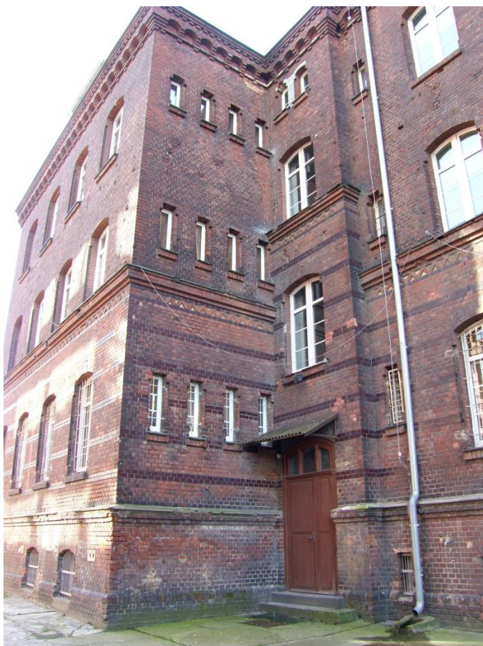
Naroże północno-wschodnie elewacji wschodniej. Widoczne wąskie okna szczelinowe.
