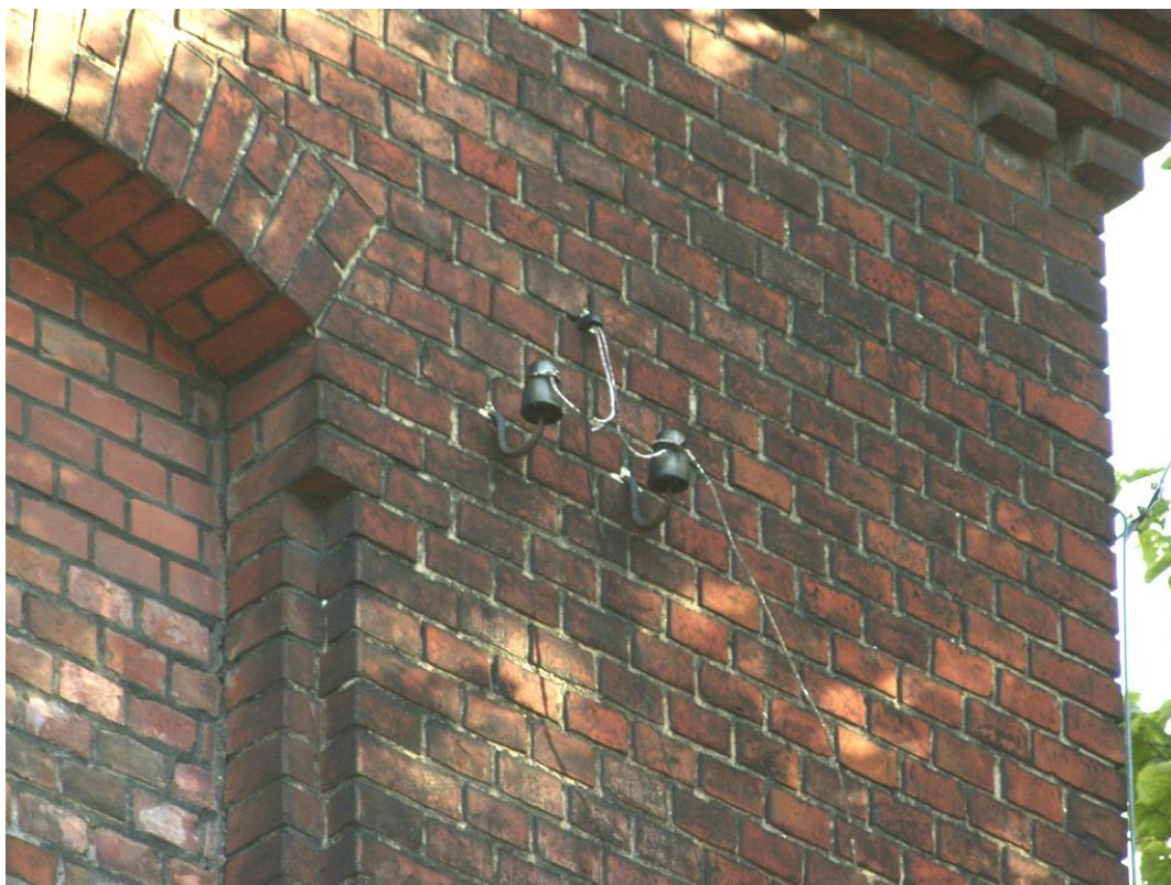
37. Pozostałości instalacji elektrycznej napowietrznej - do pozostawienia i konserwacji.
