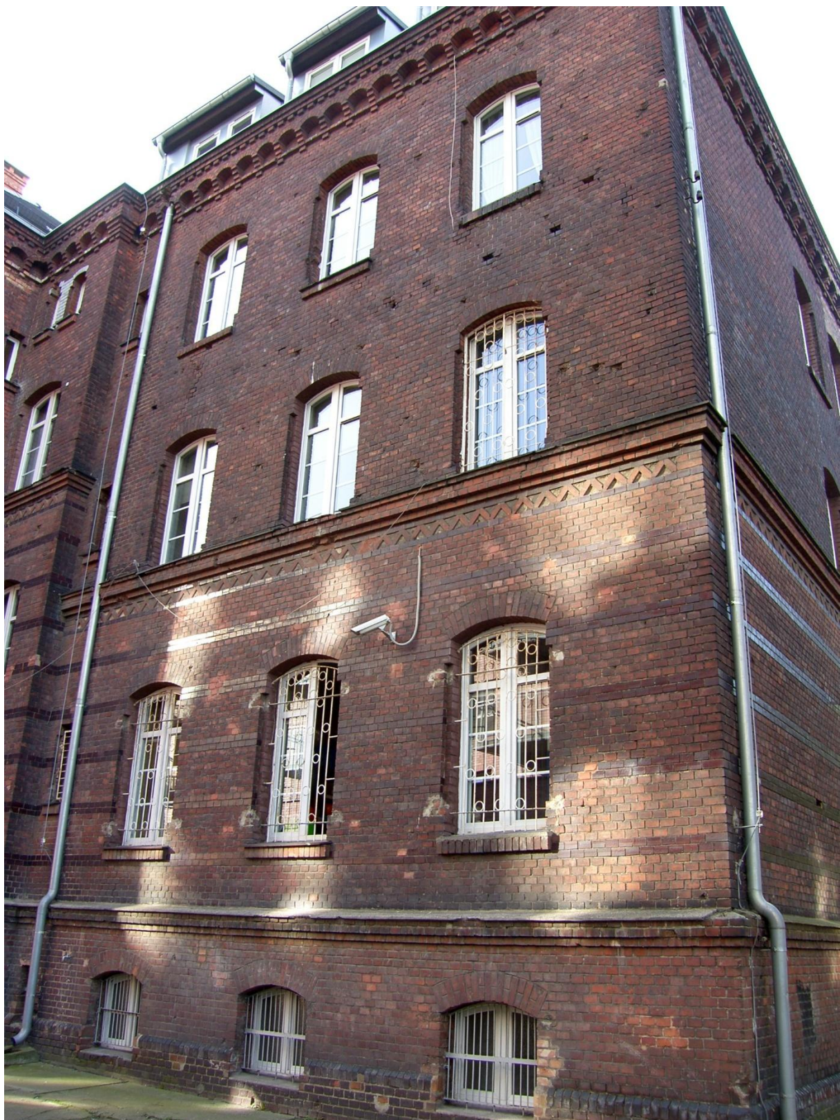
40. Widok ogólny części północnej.
