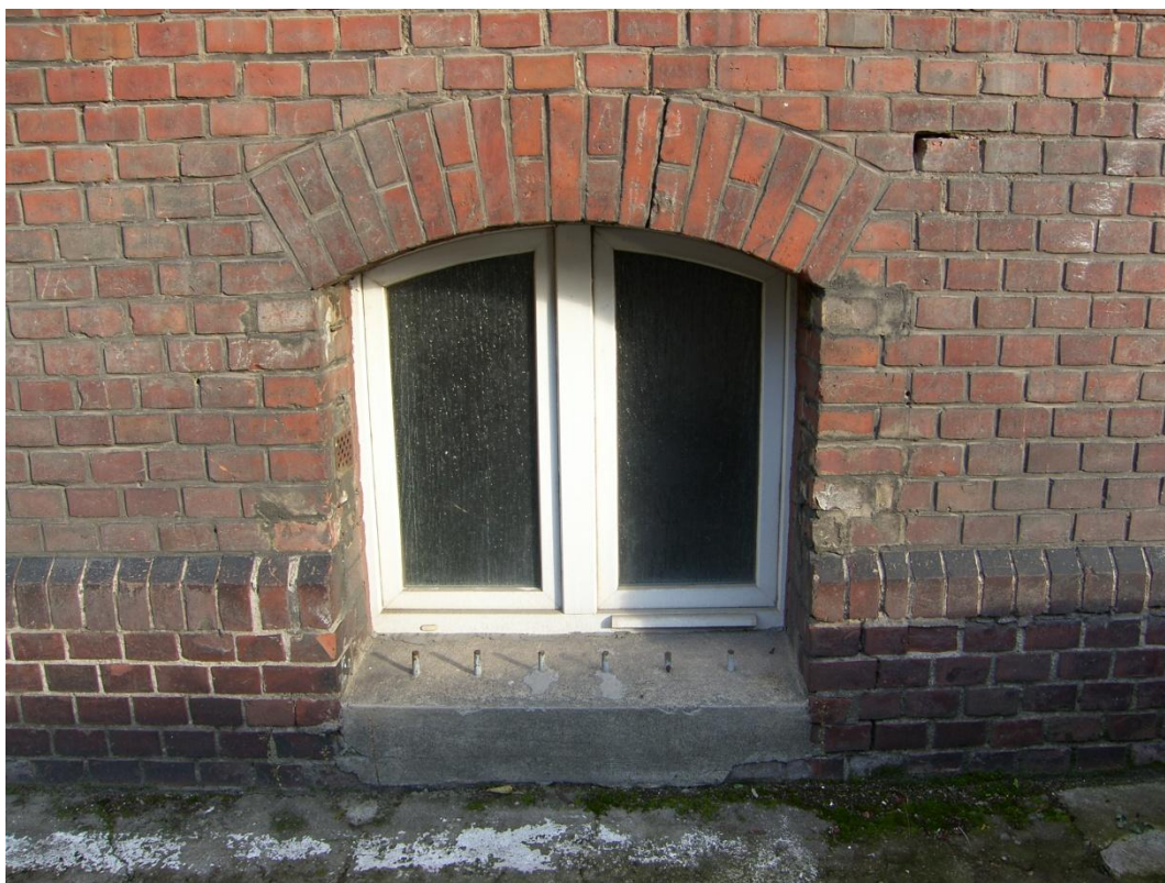
25. Okno przyziemia. Widoczne usunięcie kraty.
