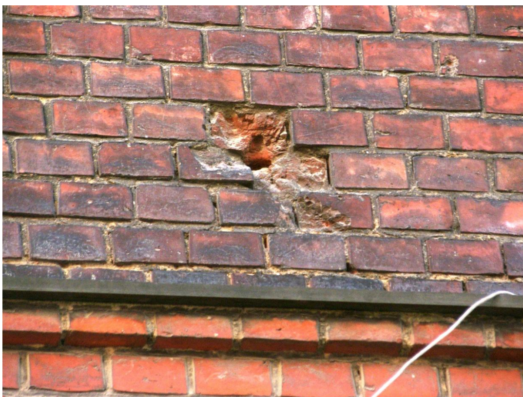
52. Postrzelina karabinowa. Proponowane zamknięcie otworu bez całkowitego usuwania postrzeliny.
