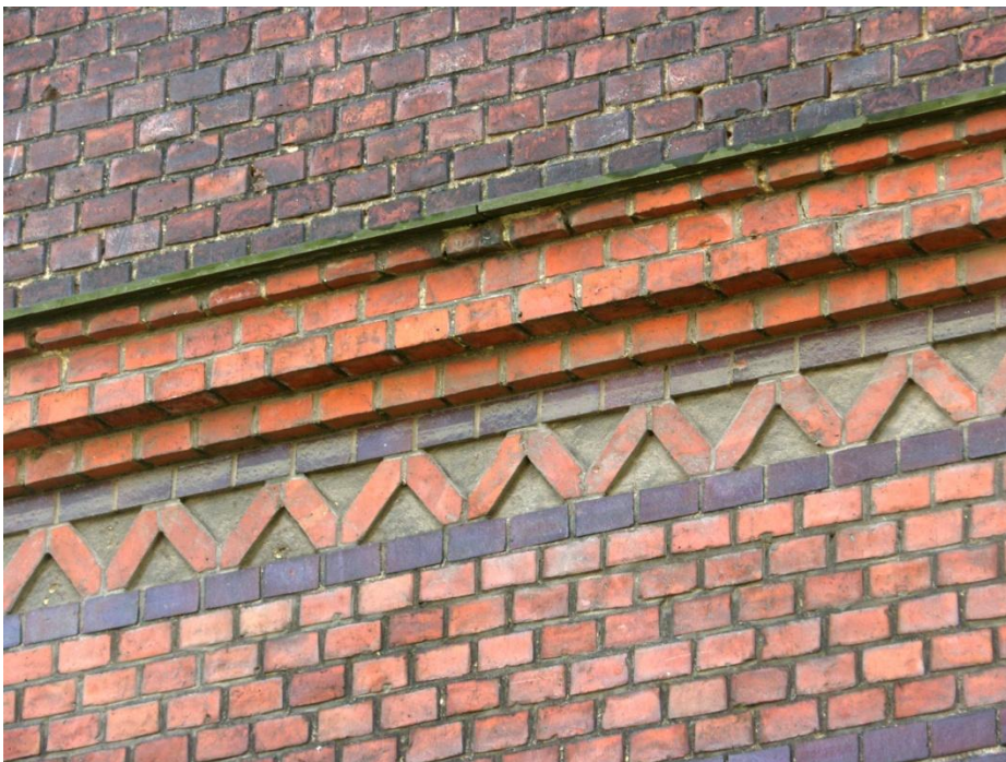
Gzyms międzykondygnacyjny z fryzem wypełnionym ukośnie ułożonymi wozówkami cegieł i pasami cegły glazurowanej. Nakrywy kamienne.
