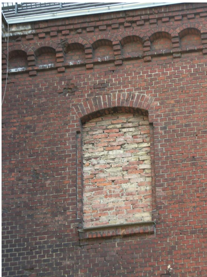
Wtórnie zamurowane okno w zachodniej części elewacji północnej.
