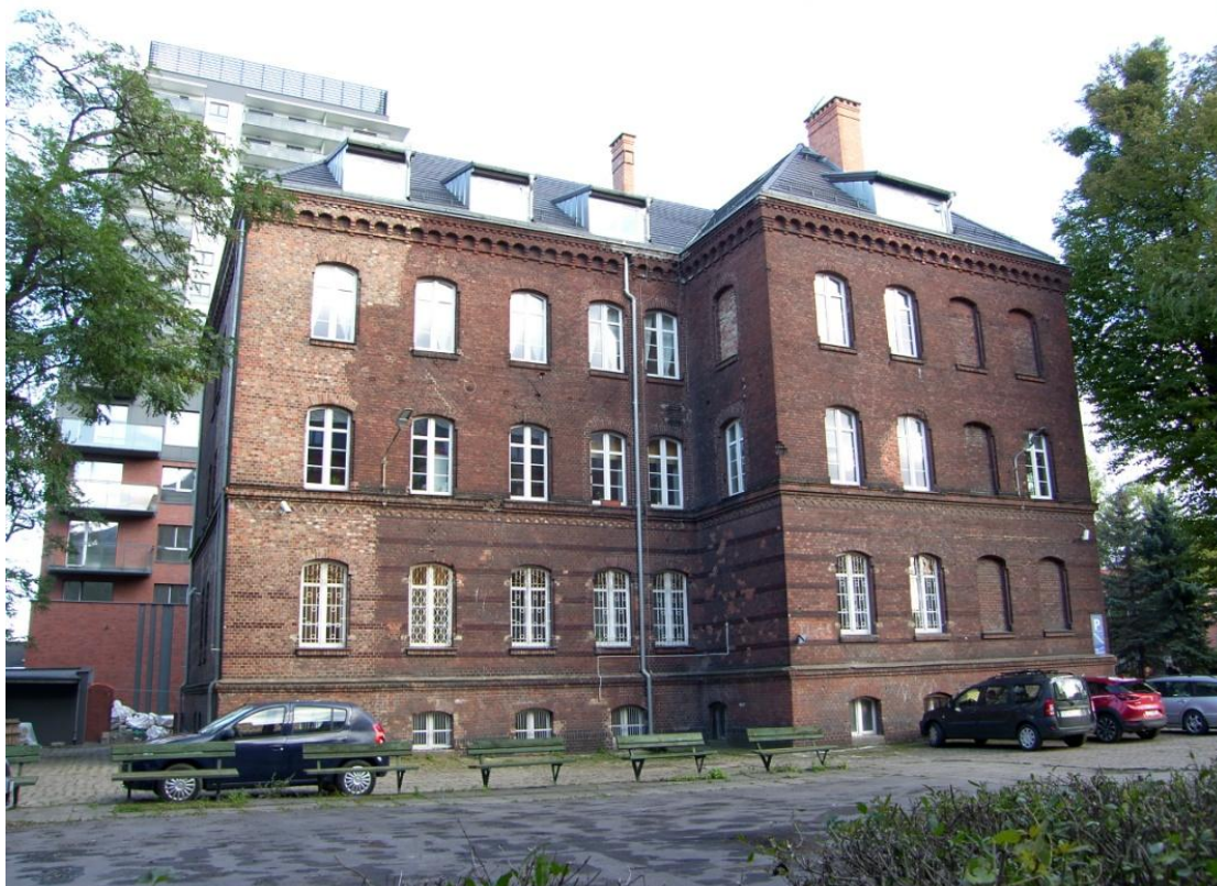
Widok budynku od północnego-zachodu. Widoczny ślad po powojennej odbudowie.
