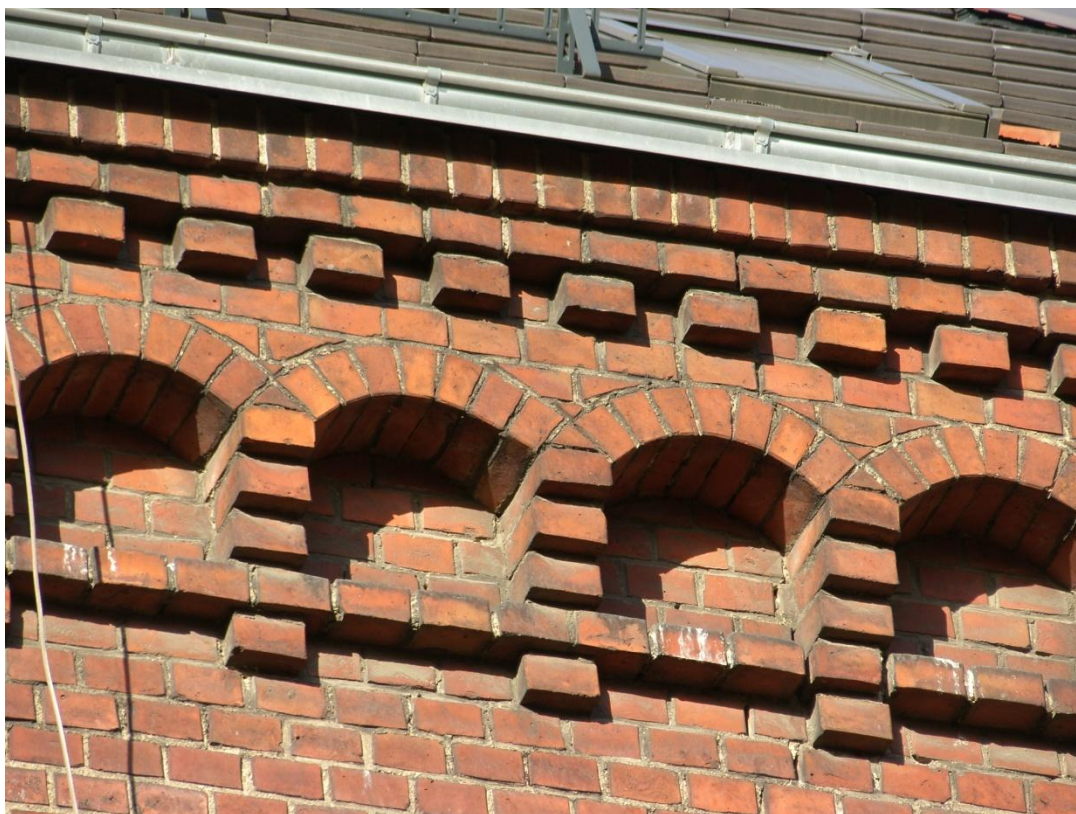
Gzyms podokapowy z arkadkowym fryzmem i kostkami.
