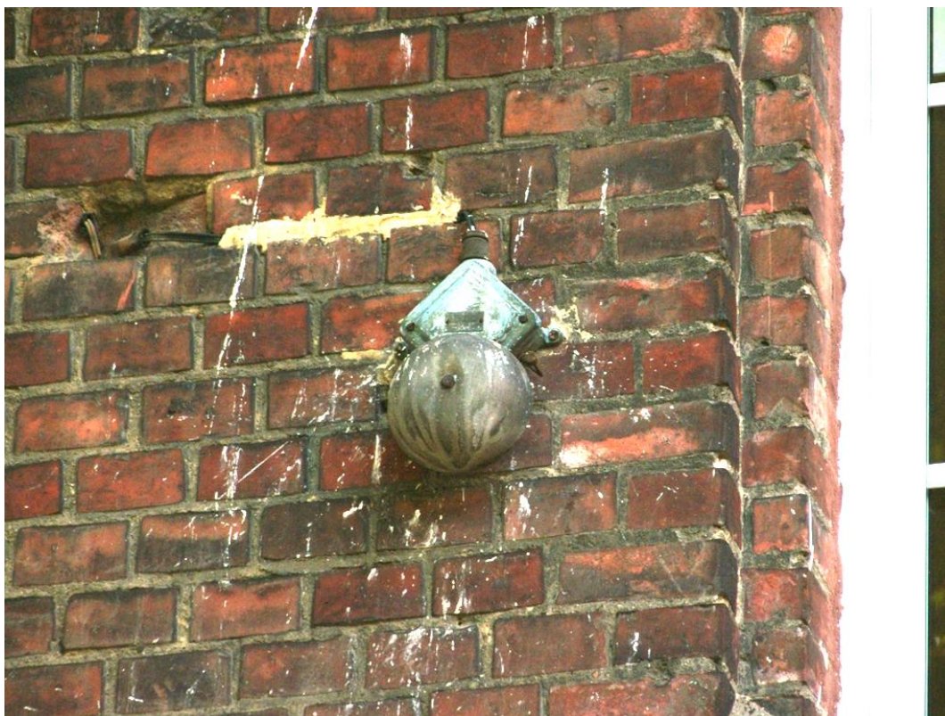
17. Stary dzwonek. Proponowane pozostawienie oraz ukrycie instalacji.
