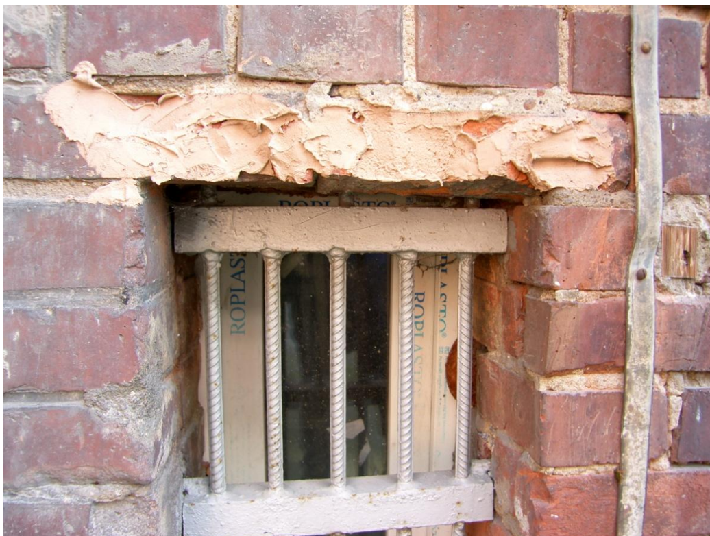
46. Naprawa nadproża okna po wymianie stolarki - do przemurowania.
