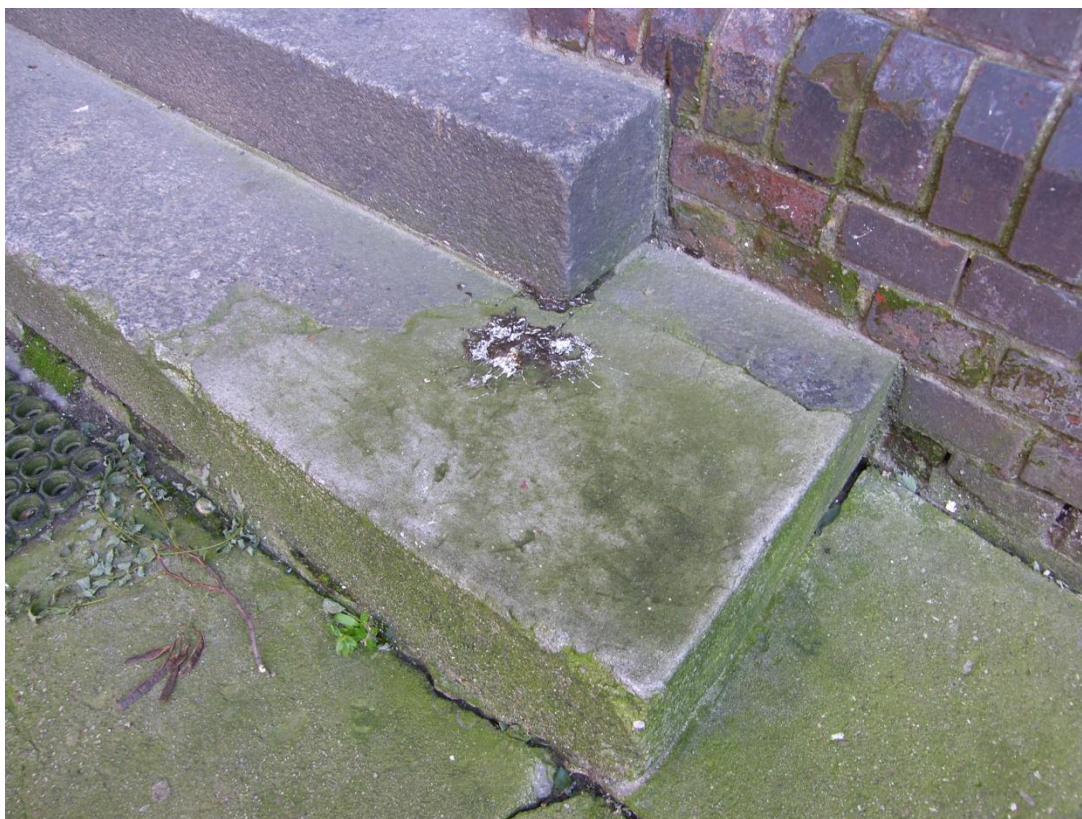
48. Betonowe uzupełnienie kamiennych stopni do wejścia wschodniego.
