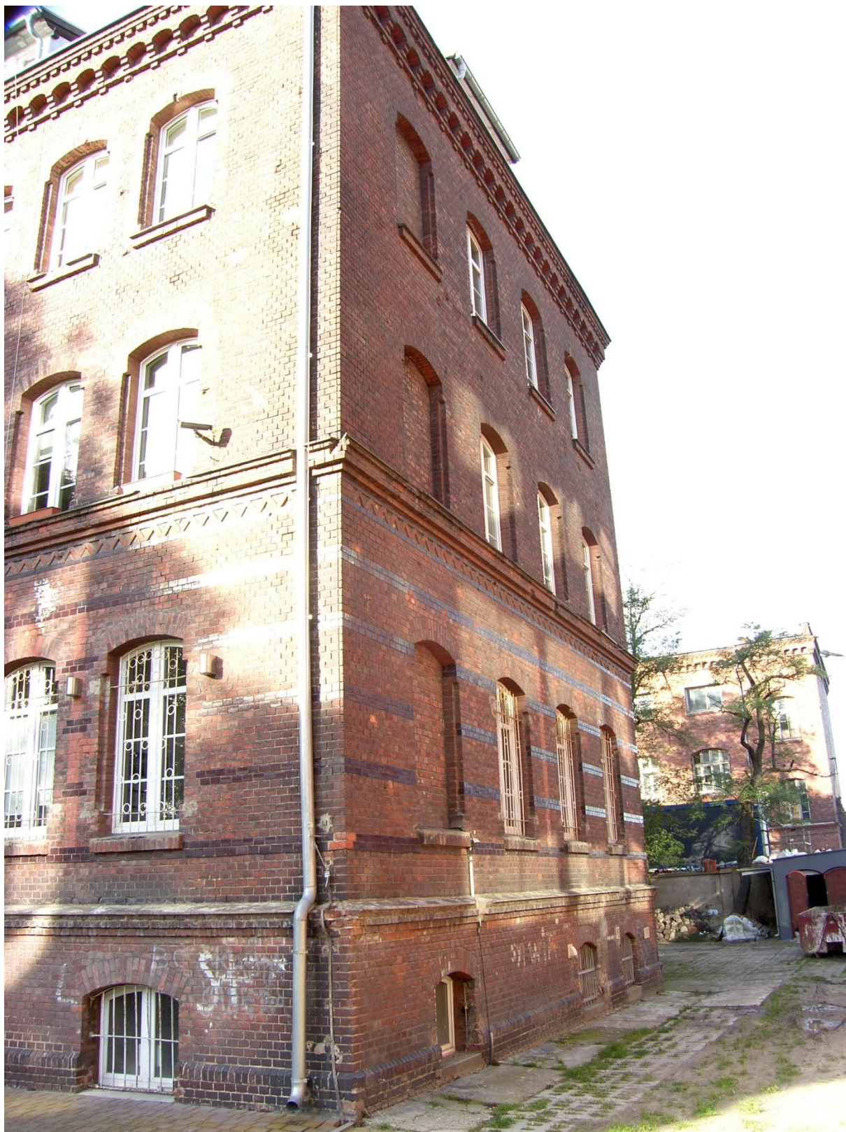
42. Widok ogólny części południowej od południa.
