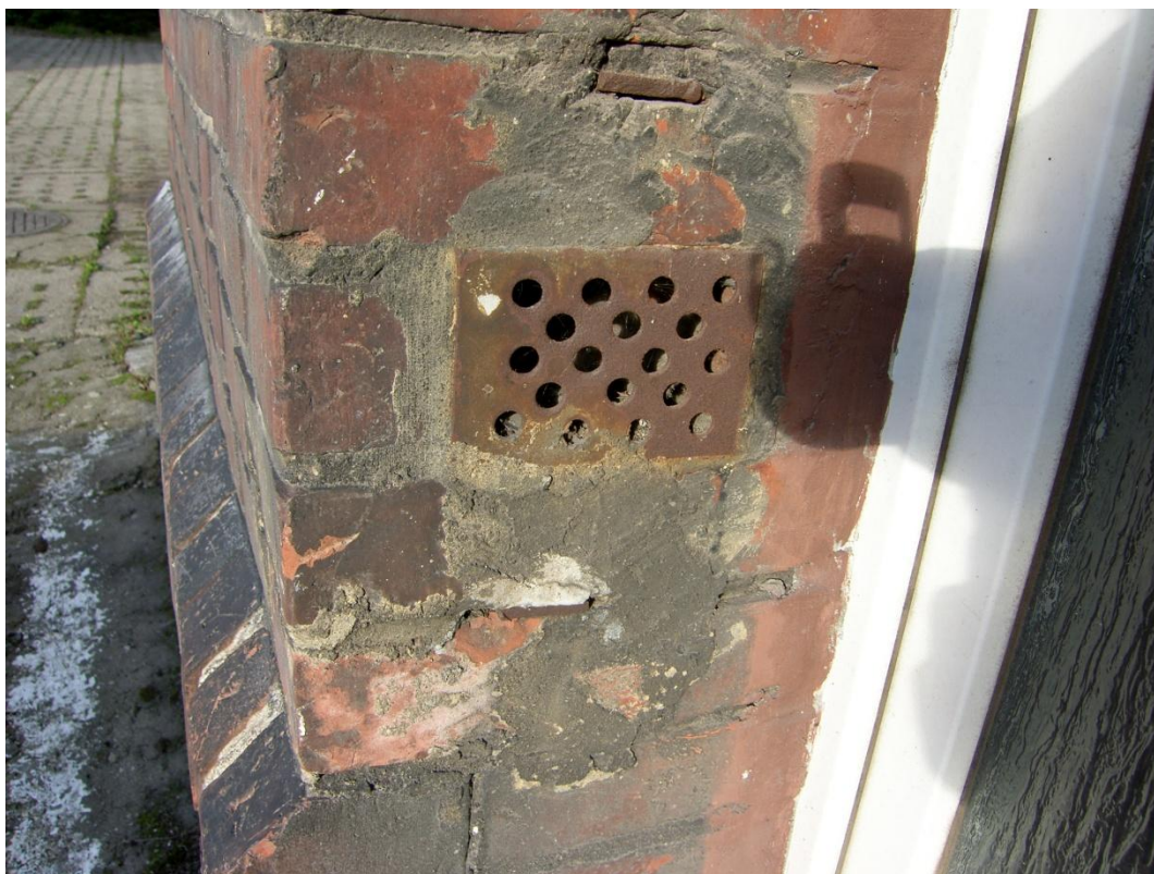
26. Wtórna kratka wentylacyjna w ościeżu okiennym - do likwidacji.
