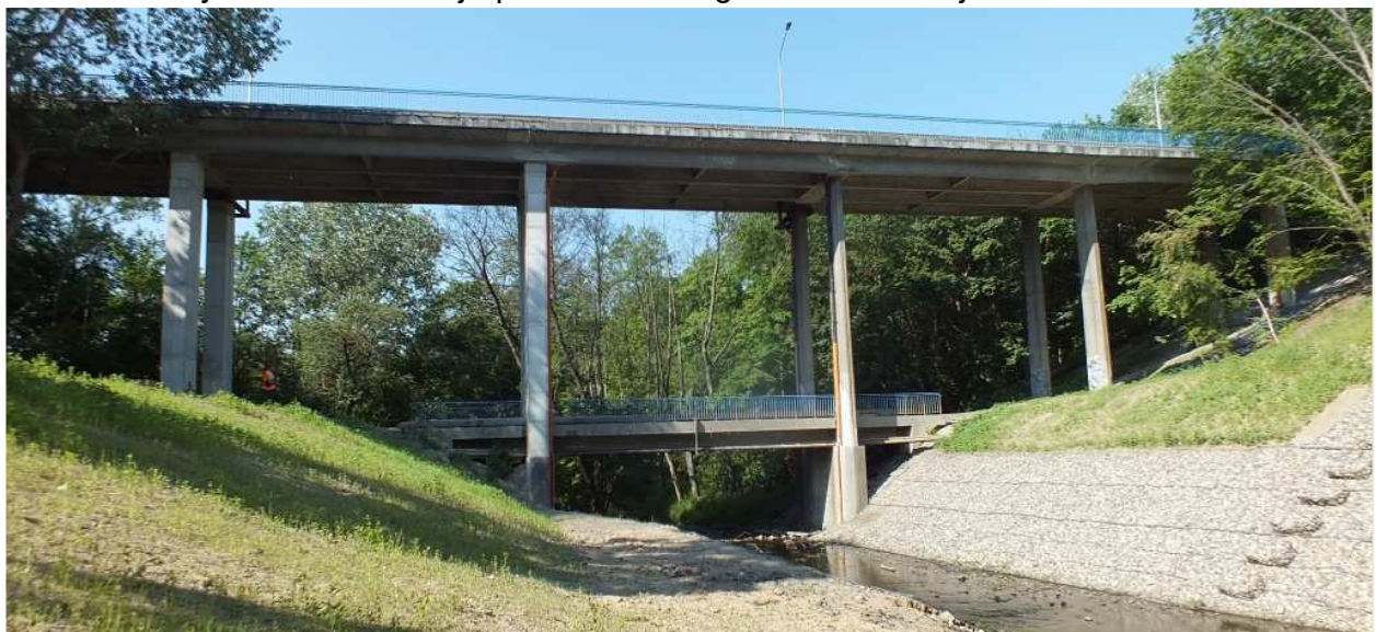
Rys. 1.2 Widok na obiekt od strony wody górnej
