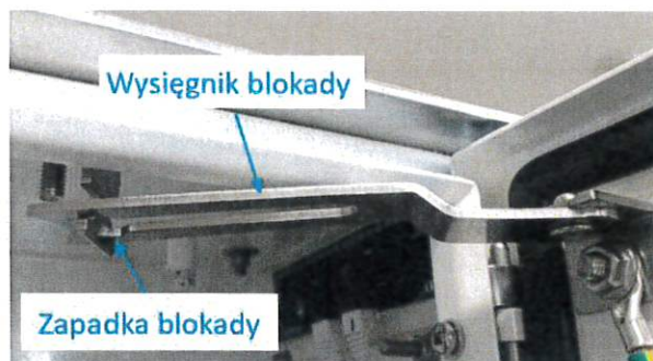
Rys. 23. Blokada mechaniczna drzwi komory serwisowej
