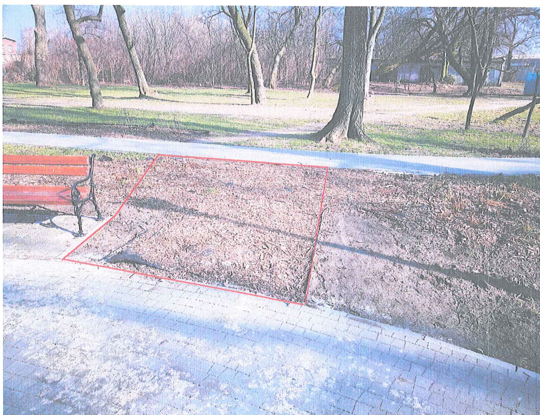
. Zdj. nr .3. Miejsce projektowanego połączenia dwóch ścieżek spacerowych, nawierzchnią z kostki betonowej
