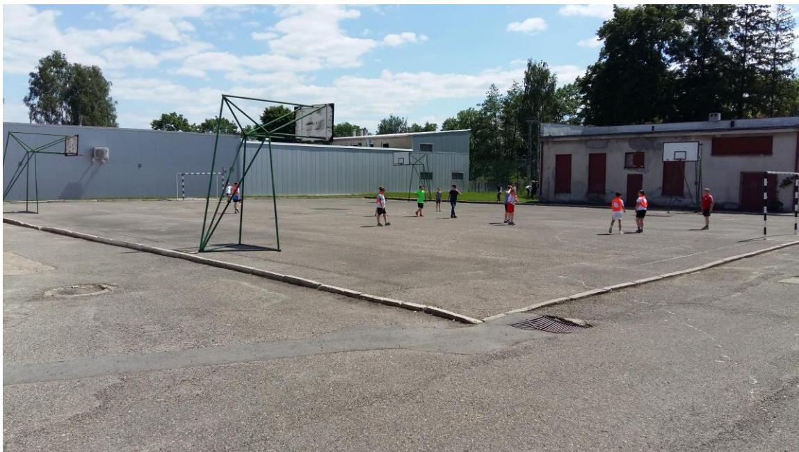
Fot.1 Boisko wielofunkcyjne przy SP nr 2 w Praszce – stan istniejący
