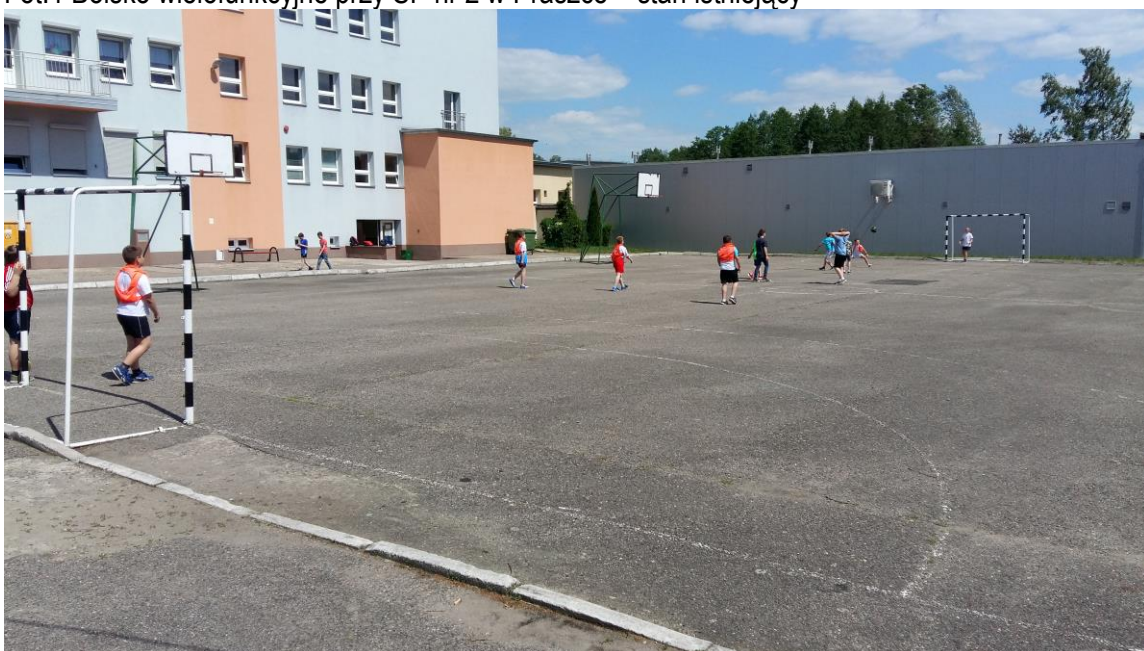
Fot.2 Boisko wielofunkcyjne przy SP nr 2 w Praszce – stan istniejący
