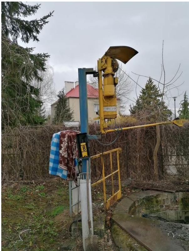
Żuraw do demontażu.
