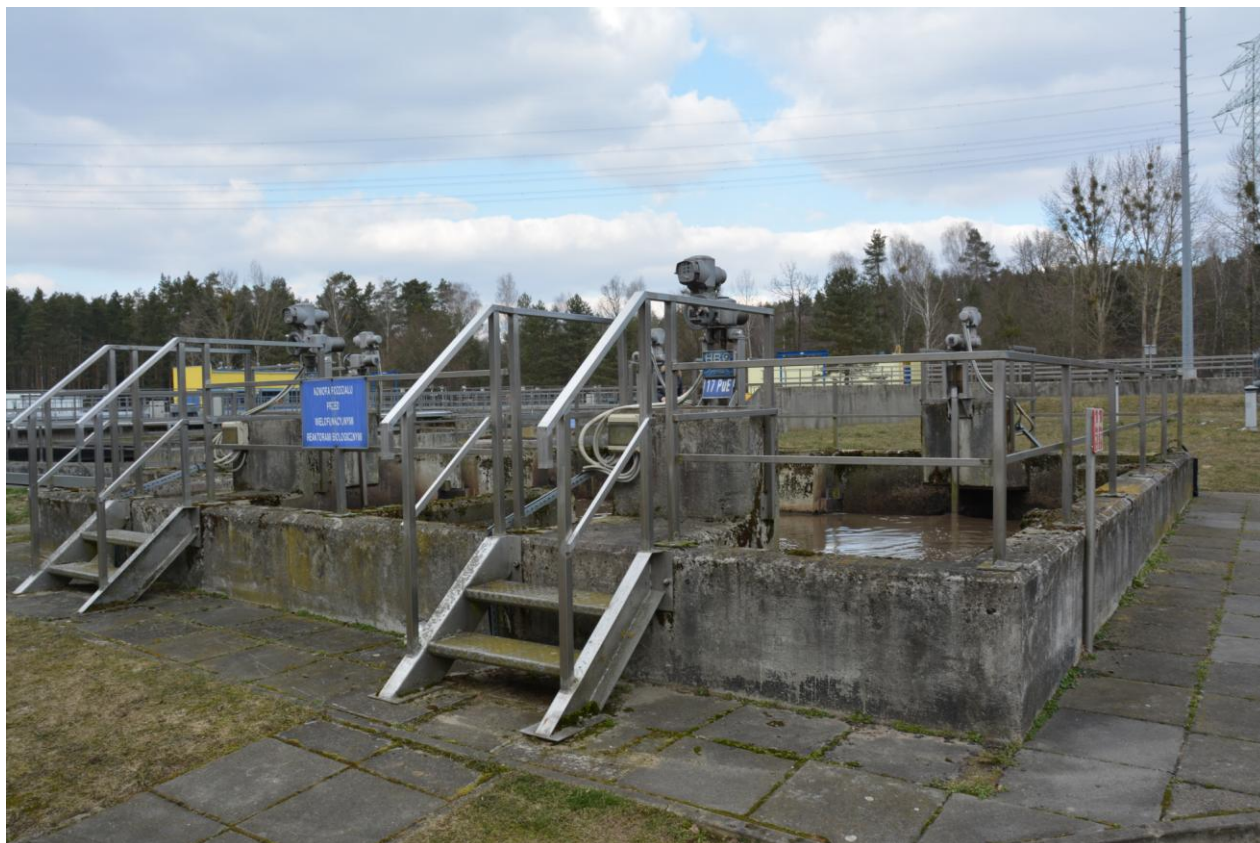
Fotografia nr 1 - Widok ogólny na komorę
