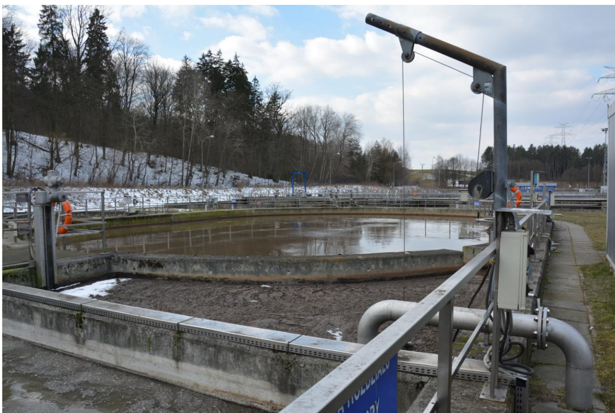
Fotografia nr 3 - Widok ogólny na komorę
