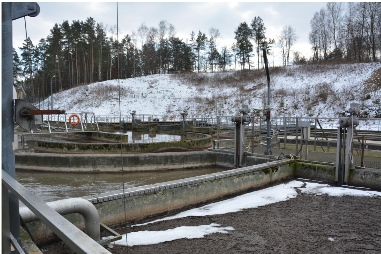
Fotografia nr 2 - Widok ogólny na komorę
