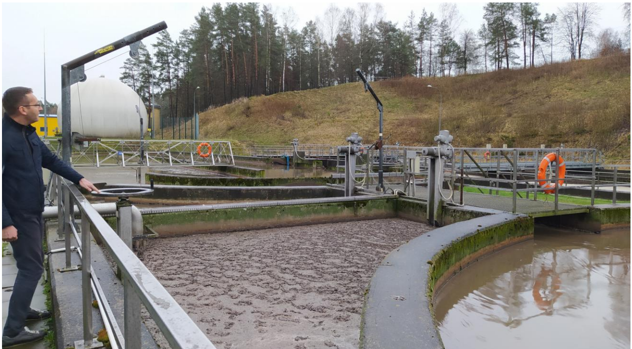
Fotografia nr 1 - Widok ogólny na komorę
