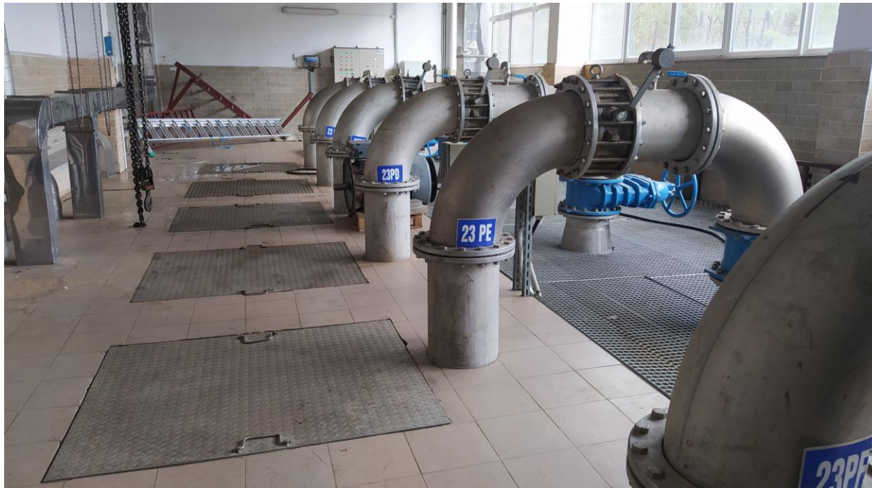
Fotografia nr 2 - Pompownia - parter
