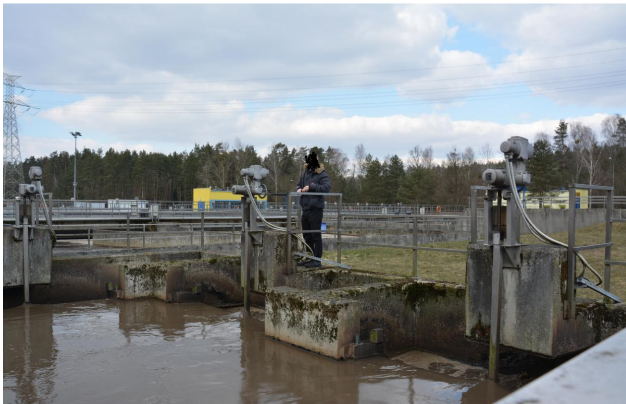
Fotografia nr 4 - Widok od wewnątrz na komorę
