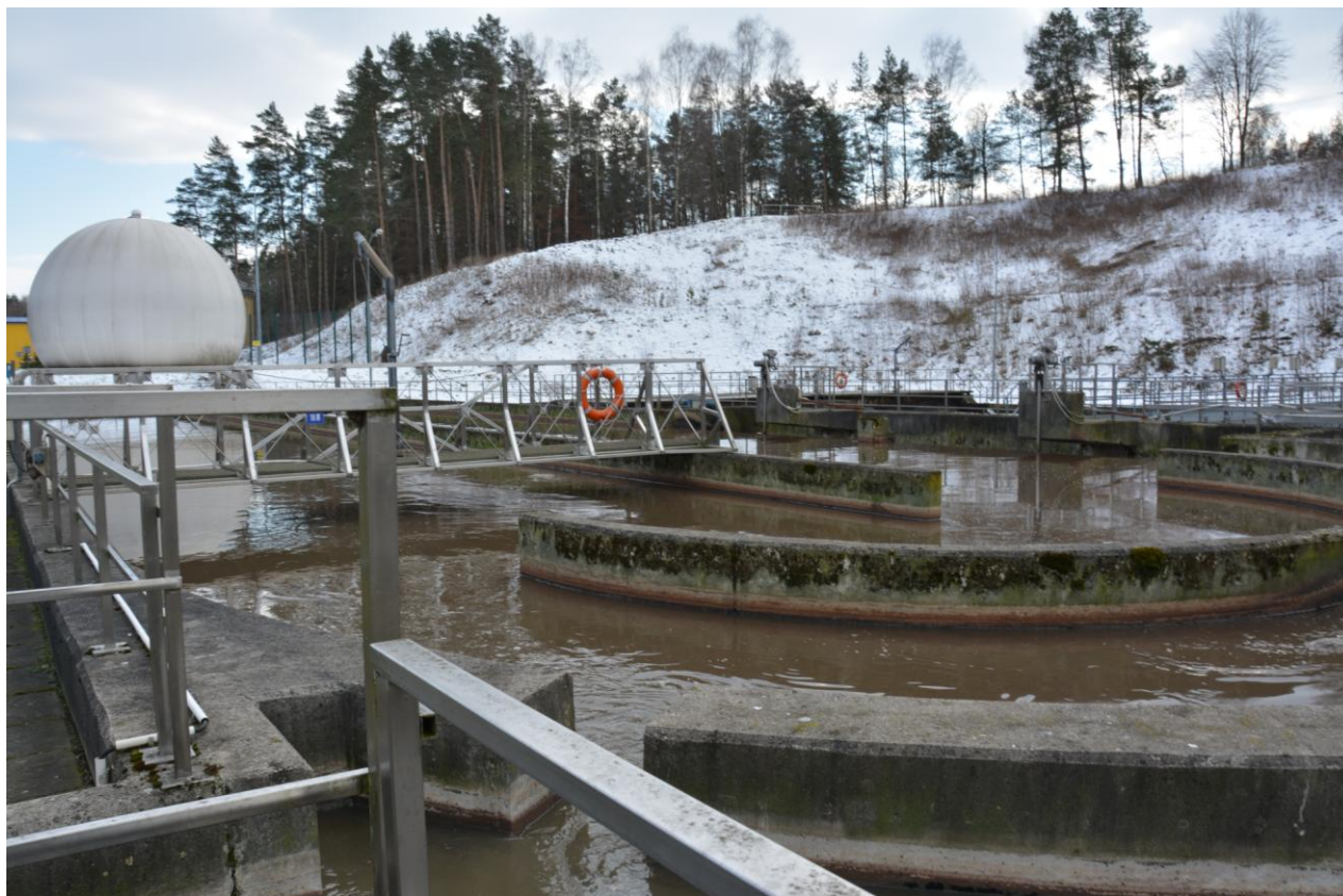
Fotografia nr 4 - Widoczna izolacja wew. komory w poziomie ścieków
