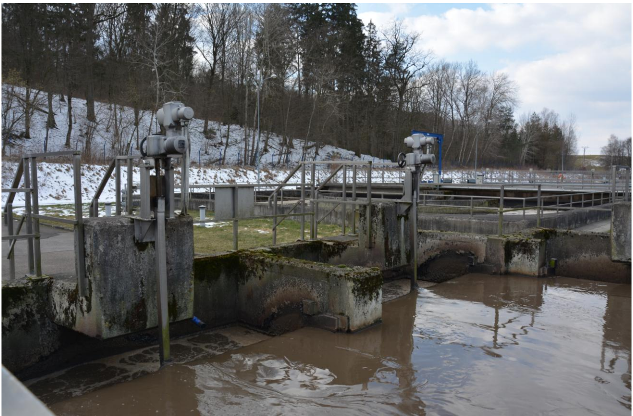
Fotografia nr 3 - Widok od wewnątrz na komorę
