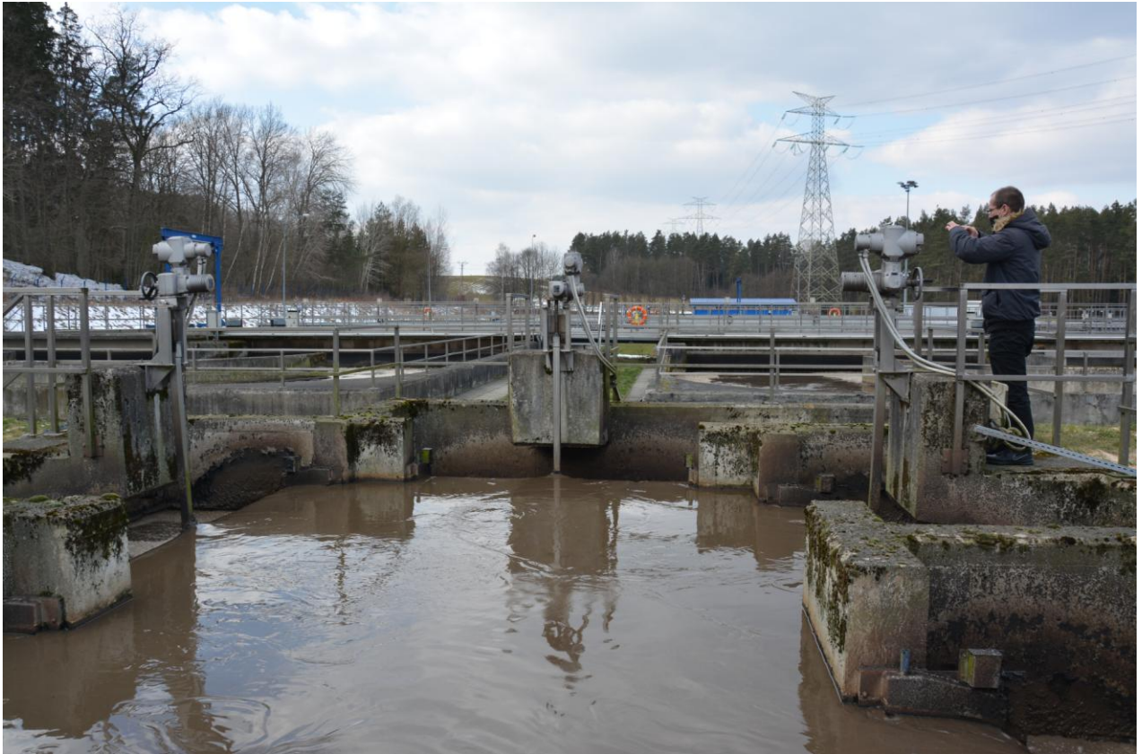
Fotografia nr 2 - Widok ogólny na komorę
