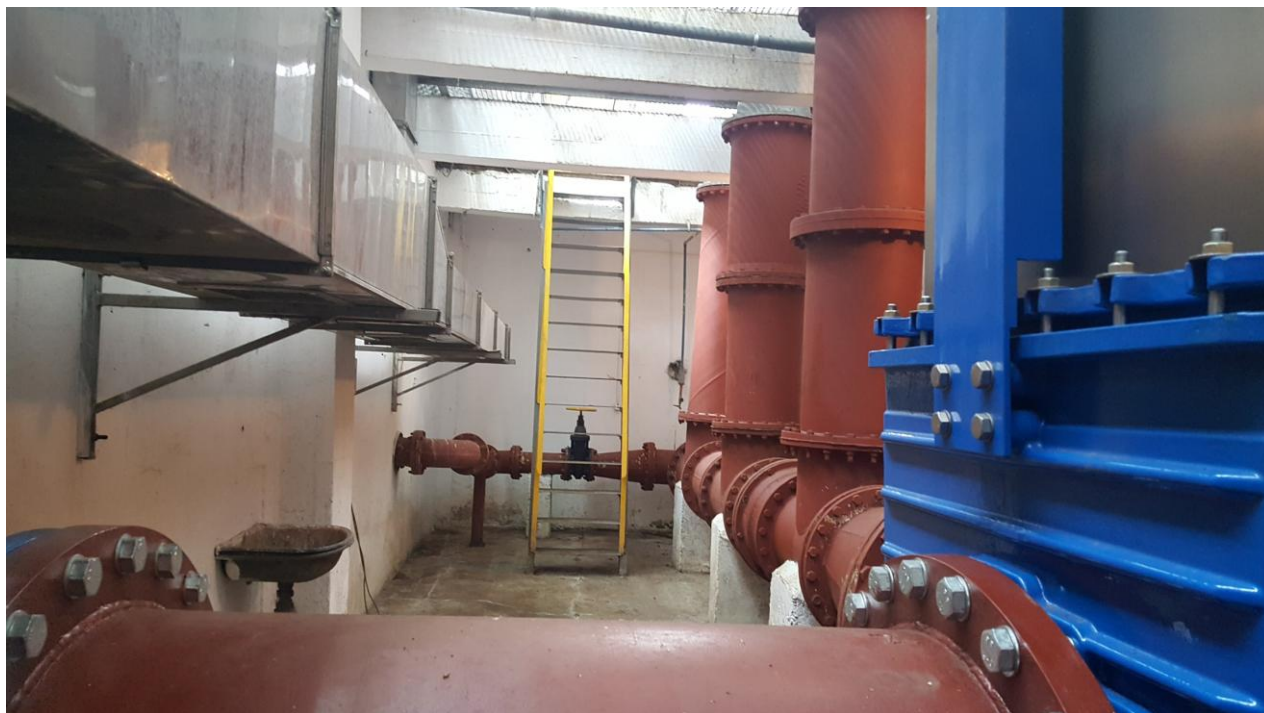
Fotografia nr 2 - Pompownia - część podziemna
