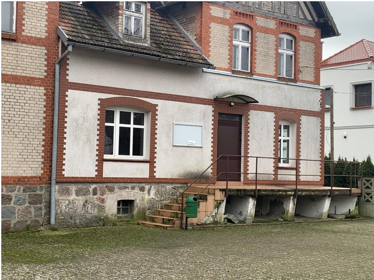
Świetlica Żółte (świetlica jest w części środkowej ze schodami)
