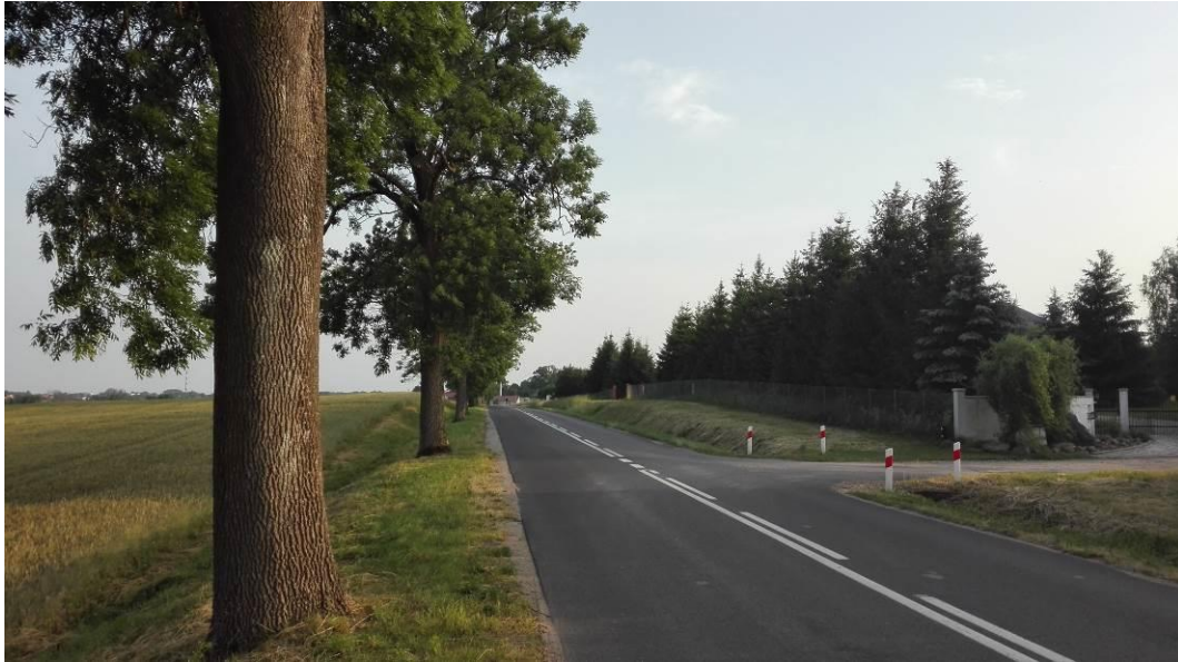
Fotografia 5. Droga nr 1329 N, wjazd do Iławy (Fot. P. Kołodziej).
