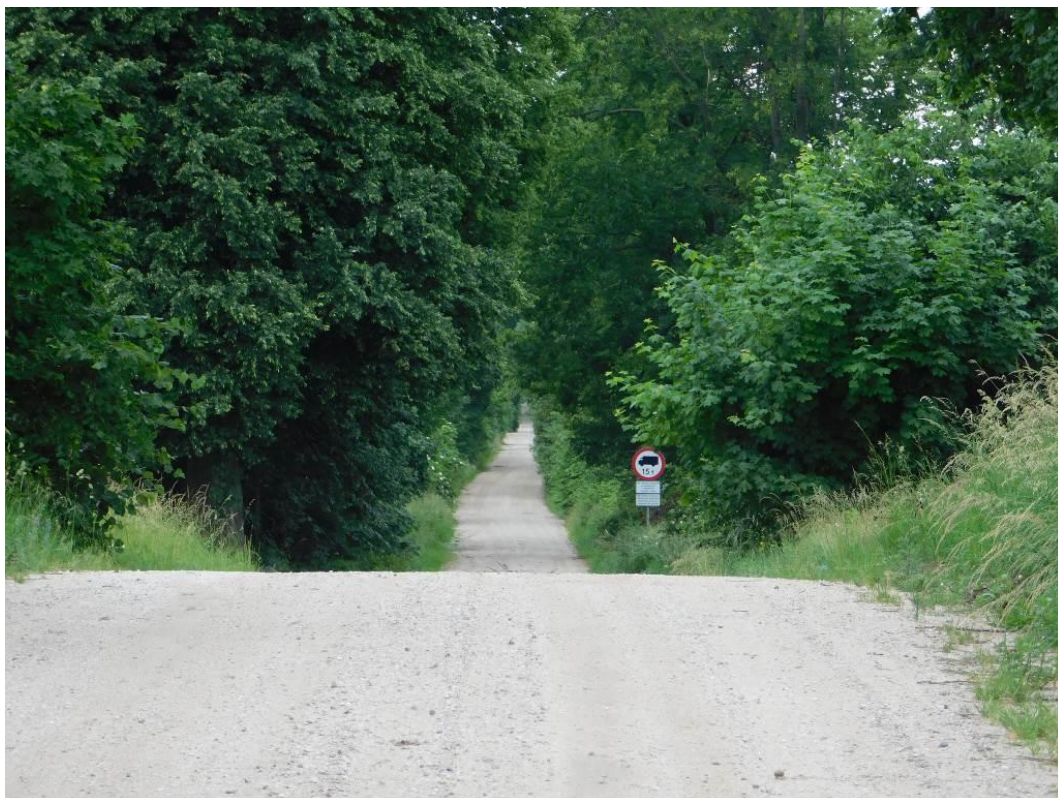
Fotografia 19. Droga nr 1295 N, silne zakrzewienie pobocza (Fot. A. Fenyk).
