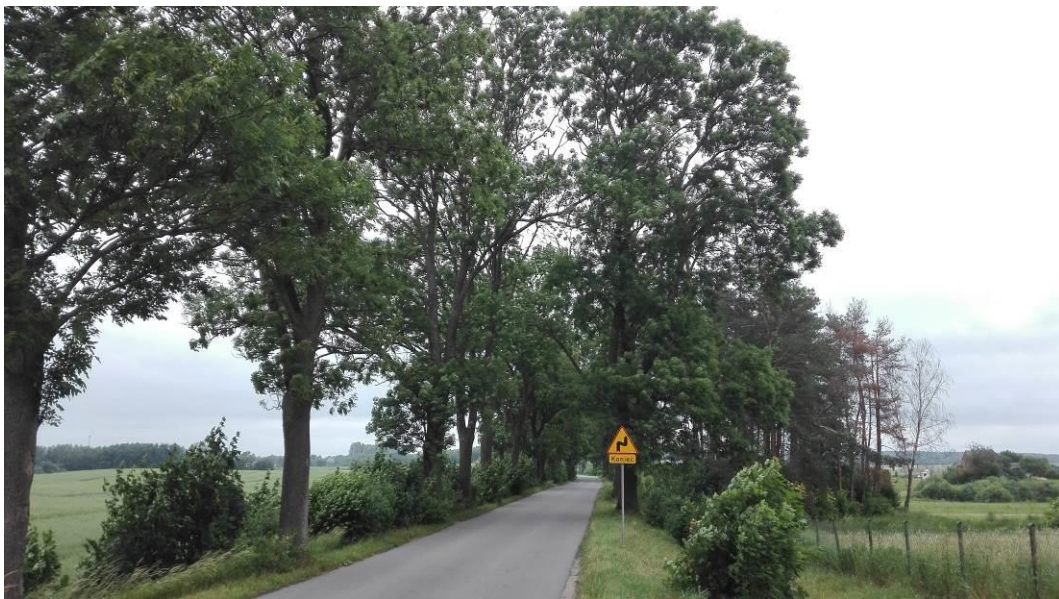
Fotografia 6. Droga nr 1329 N, fragment Tynwałd – Wola Kamińska (Fot. P. Kołodziej).
