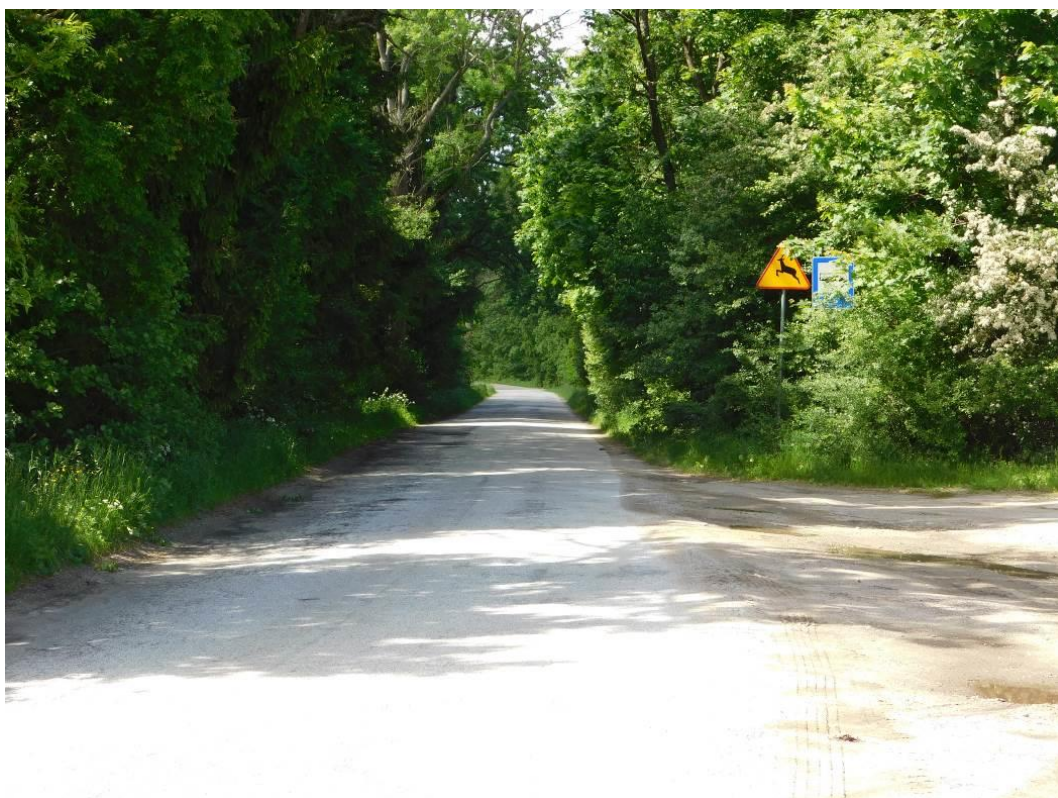
Fotografia 2. Droga nr 1311 N, silne zakrzewienie pasa drogowego (Fot. A. Fenyk).
