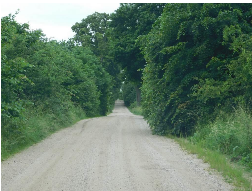
Fotografia 20. Droga nr 1295 N, silne zakrzewienie pobocza (Fot. A. Fenyk).
