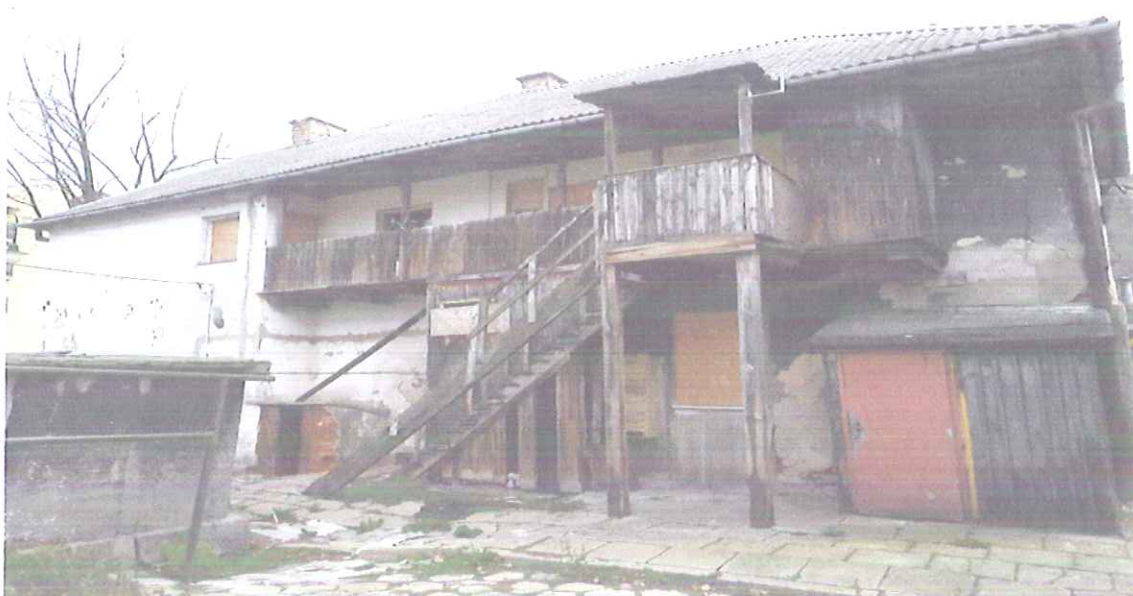
Budynek mieszkalny nr III (oficyna)
