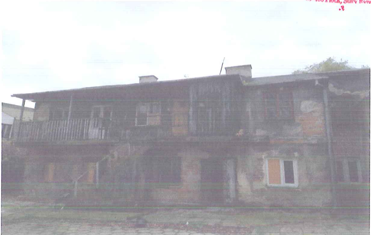
Budynek mieszkalny nr IV (oficyna)
