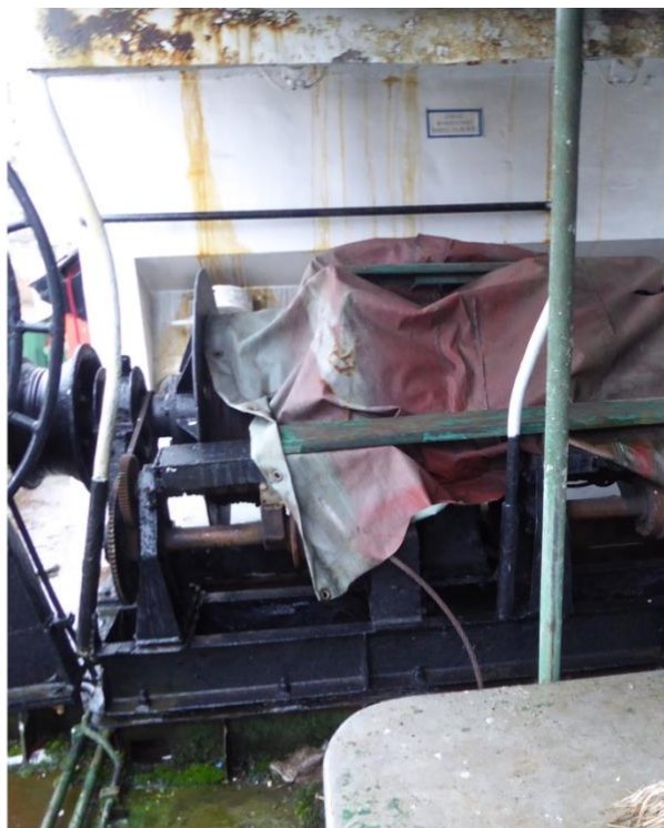
II.07. Wciągarka do demontażu.
