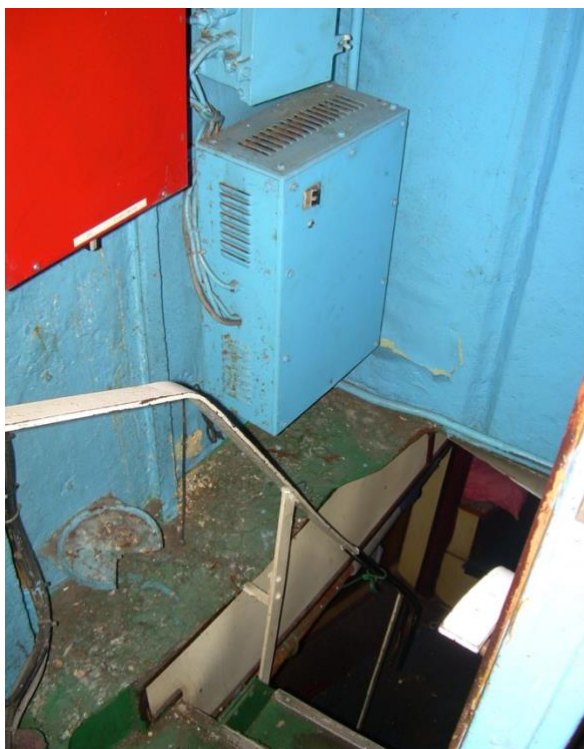
Il.04. Zejście do maszynowni.
