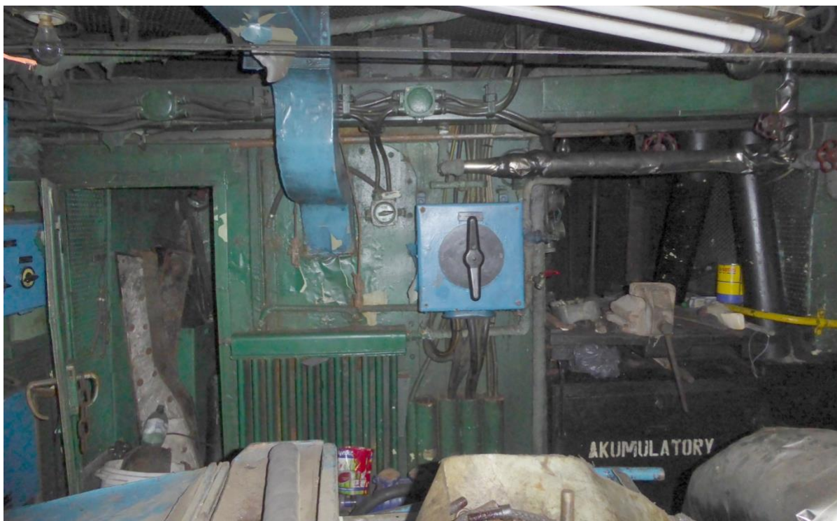
Il.16. Maszynownia– elementy wnętr siłowni do usunięcia (pomieszczenie C.O.).
