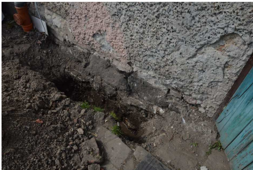
Fot. 1 – Widok fundamentów kamiennych na elewacji południowej w strefie uszkodzonych sklepień
