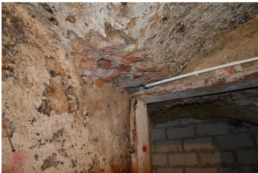
Fot. 6 – Usunięte podparcie sklepień w strefie korytarzowej
