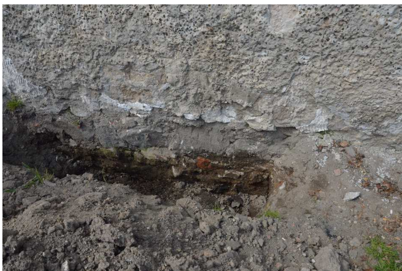
Fot. 2 – Widok fundamentów kamiennych na elewacji południowej w strefie uszkodzonych sklepień
