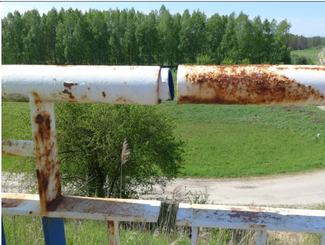
Fot. 25 Balustrada w miejscu szczeliny dylatacyjnej nad podporą – brak ciągłości w elemencie poziomym, w pochwyce wymagana naprawa.
