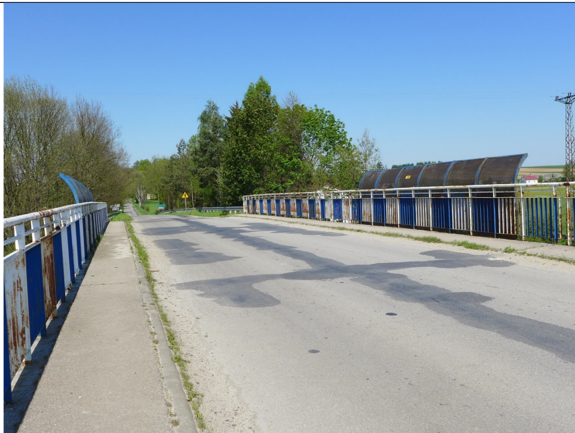
Fot. 1 Widok ogólny z góry na obiekt
