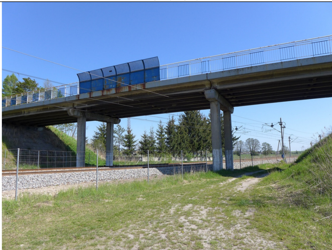
Fot. 2 Widok ogólny z boku na obiekt
