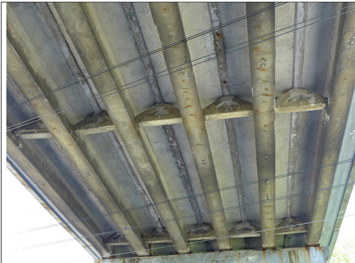
Fot. 13 Przęsło 2-3 – widoczne osady przy zamkach monolitycznych
