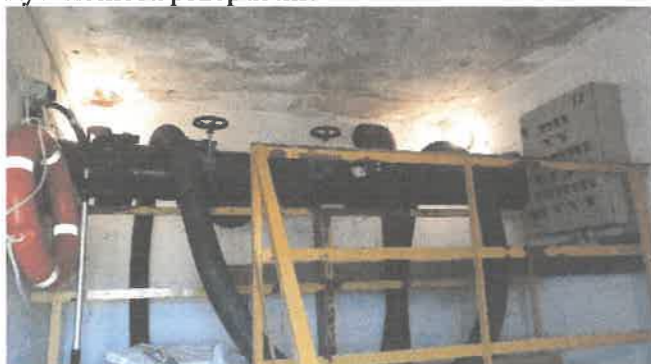
Rys. Komora przepustnic
