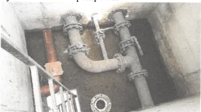
Rys. Komora sucha pompowni
