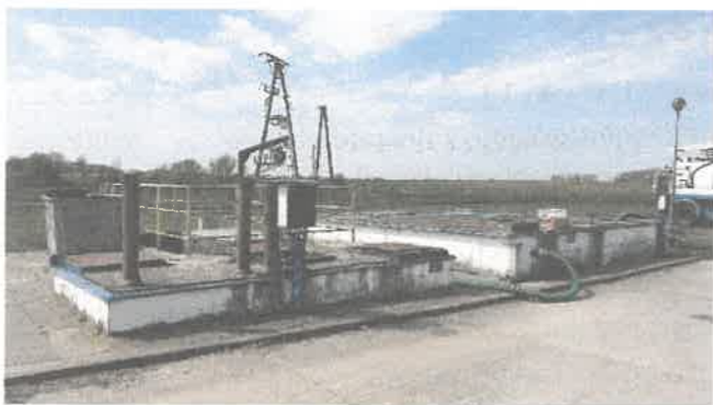
Rys. Komora sucha pompowni
