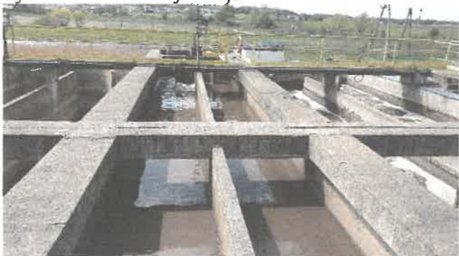
Rys. Komora denitryfikacji
