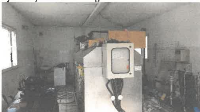
Rys. Stacja mechanicznego odwadniania osadu
