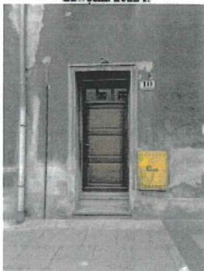
3. Fragment fasady, otwór wejściowy, fot. B. Gawęcka 2022 r.
