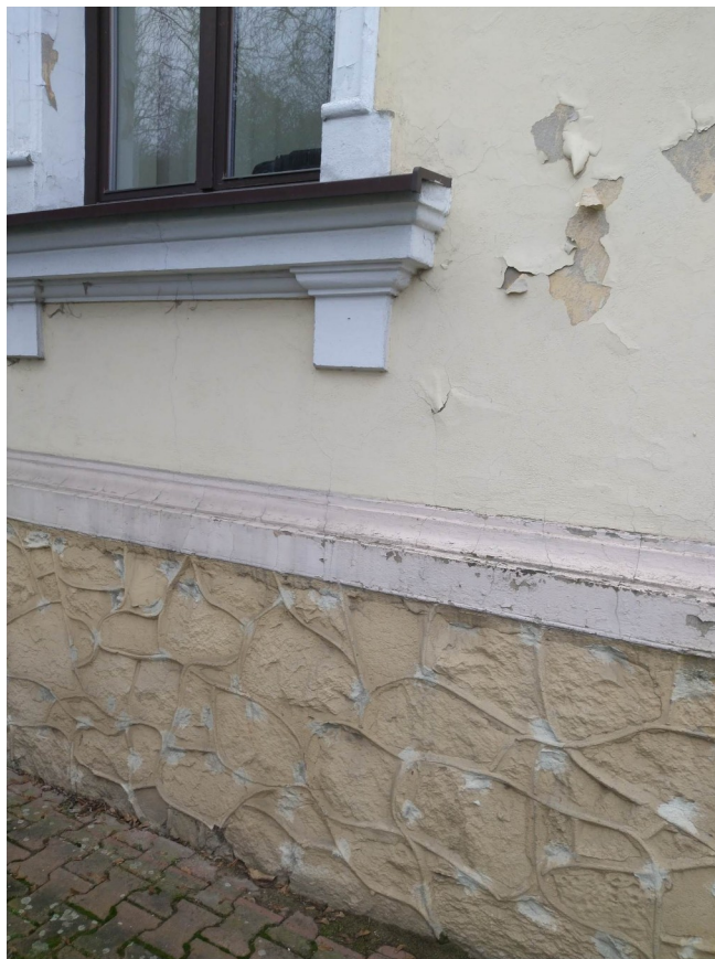
Fot. 7 – uszkodzenia elewacji
