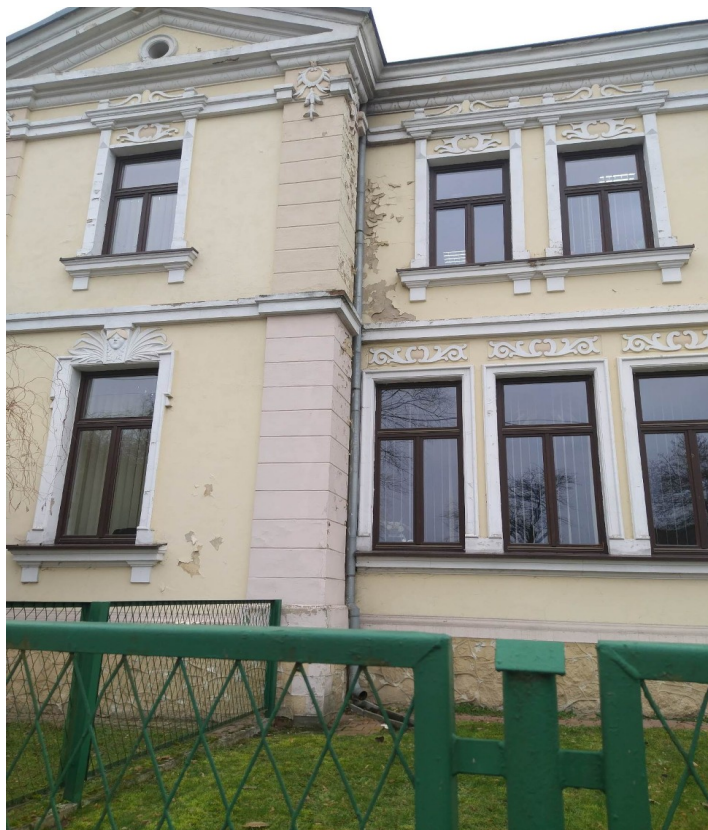
Fot. 7 – uszkodzenia elewacji
