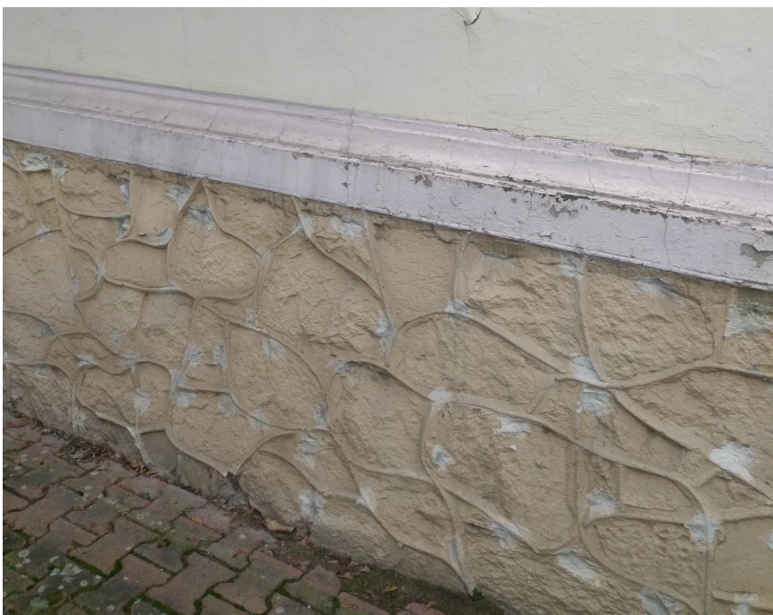
Fot. 9 – Cokół do oczyszczenia, istniejąca opaska do naprawy
