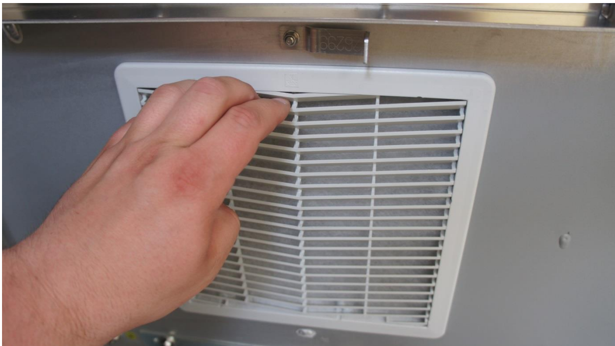
Rys. Nacisnąć kratkę obudowy filtra. Kratka jest zamocowana na stałe w dolnej części.
