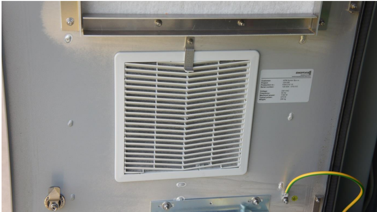
Rys. Umieszczenie filtra wentylacji na dole drzwi
