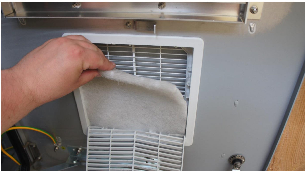
Rys. Pociągnąć do siebie kratkę obudowy filtra.
