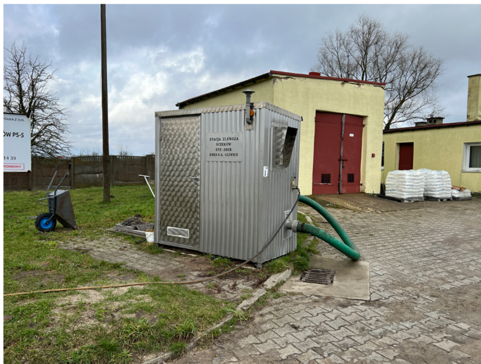
Fot.23. Punkt zlewny ścieków dowożonych – iSTZ
