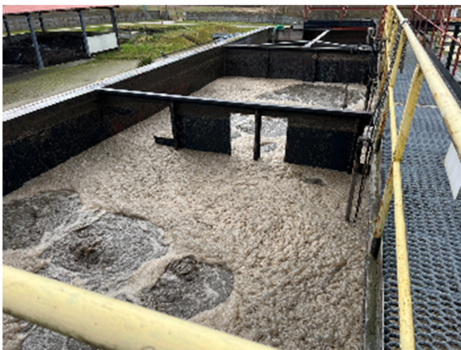
Fot.10. Reaktor sekwencyjny nr 1 – ZRD
