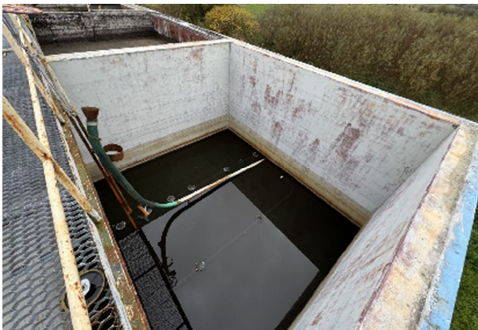
Fot.12. Komora stabilizacji osadu – KTSO3
