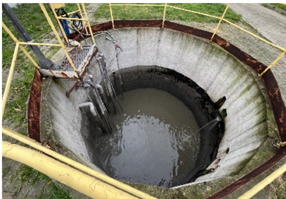
Fot.6. Komora retencyjno-uśredniająca – PW2
