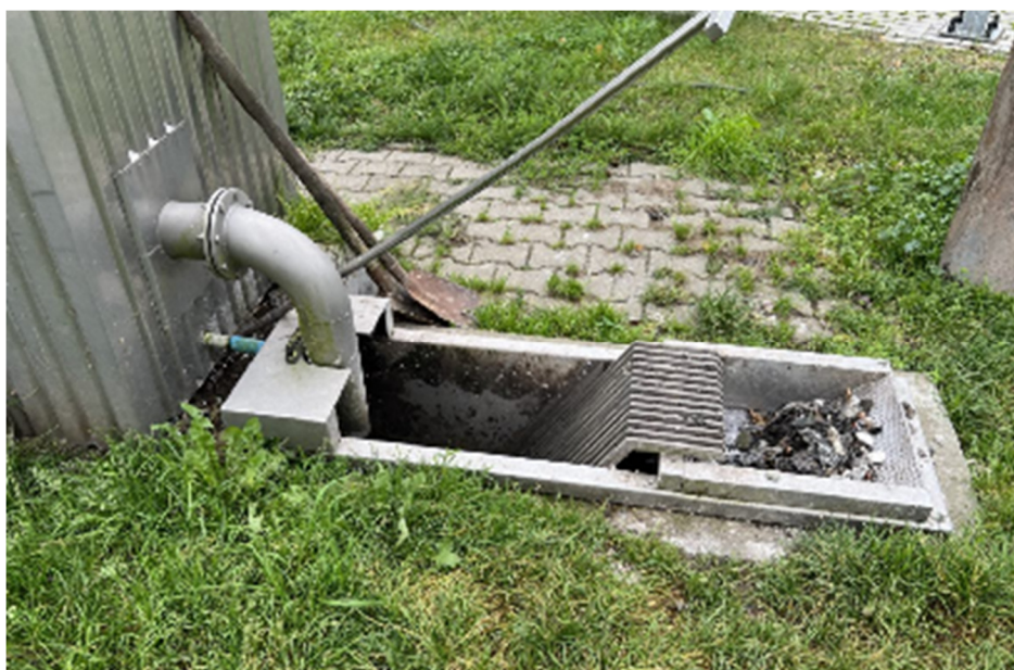
Fot.24. Krata punktu zlewnego
