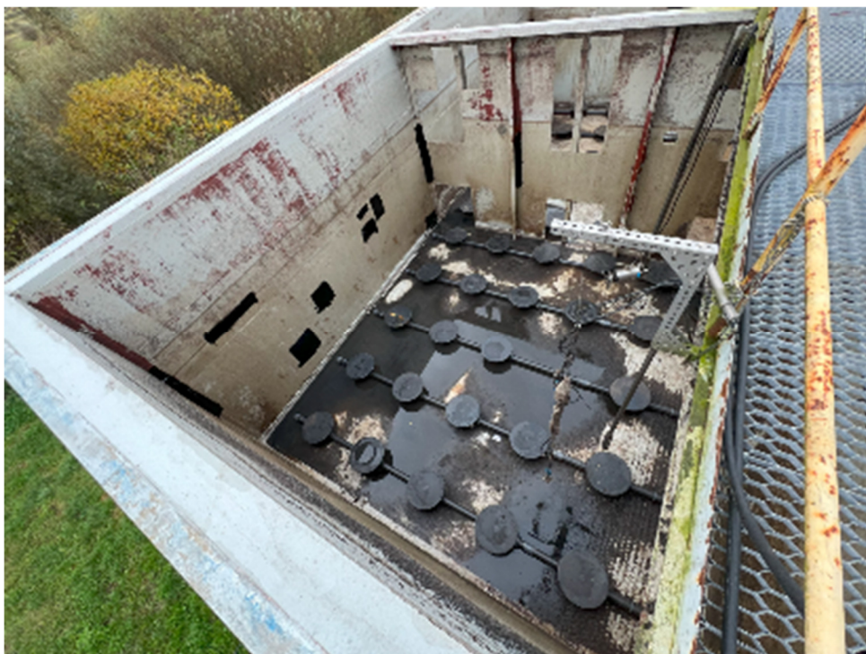
Fot.11. Reaktor sekwencyjny nr 2 – KTSO1
