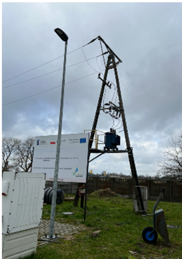
Fot.1. Stacja transformatorowa – ST
