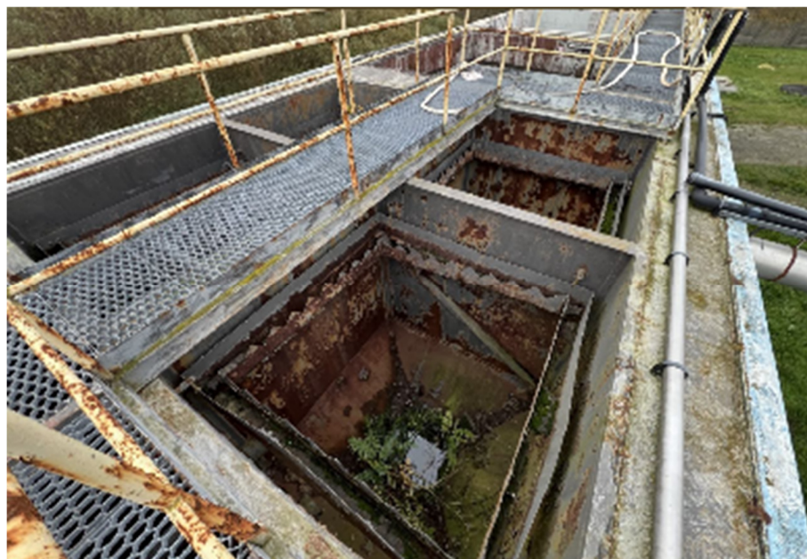
Fot.27. Osadniki wtórne – OW2
