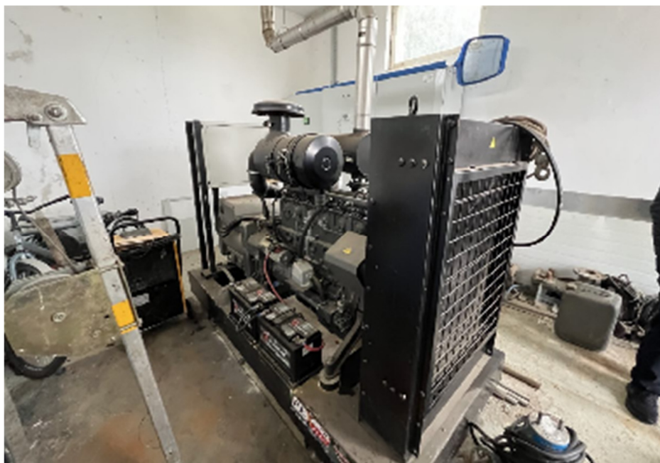
Fot.3. Agregat prądotwórczy
