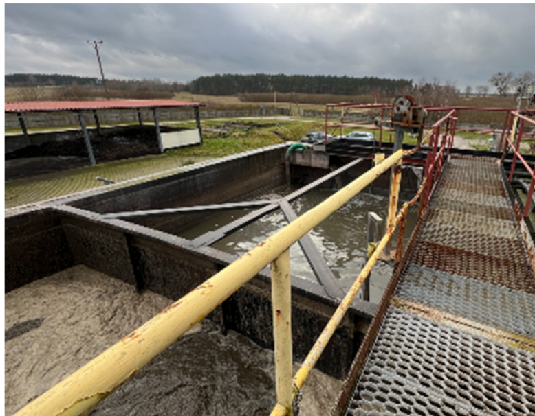
Fot.9. Zbiornik retencyjny ścieków surowych – ZRD
