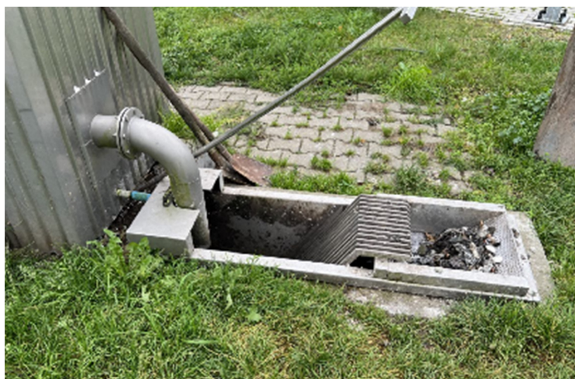
Fot.24. Krata punktu zlewnego
