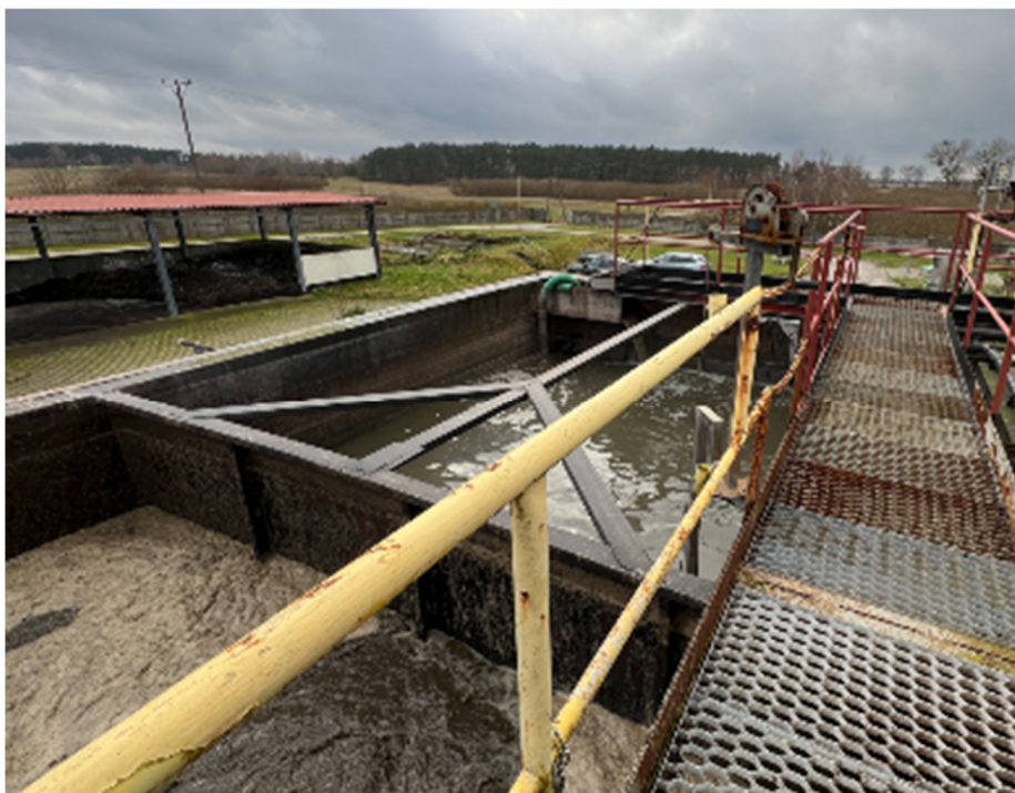
Fot.9. Zbiornik retencyjny ścieków surowych – ZRD
