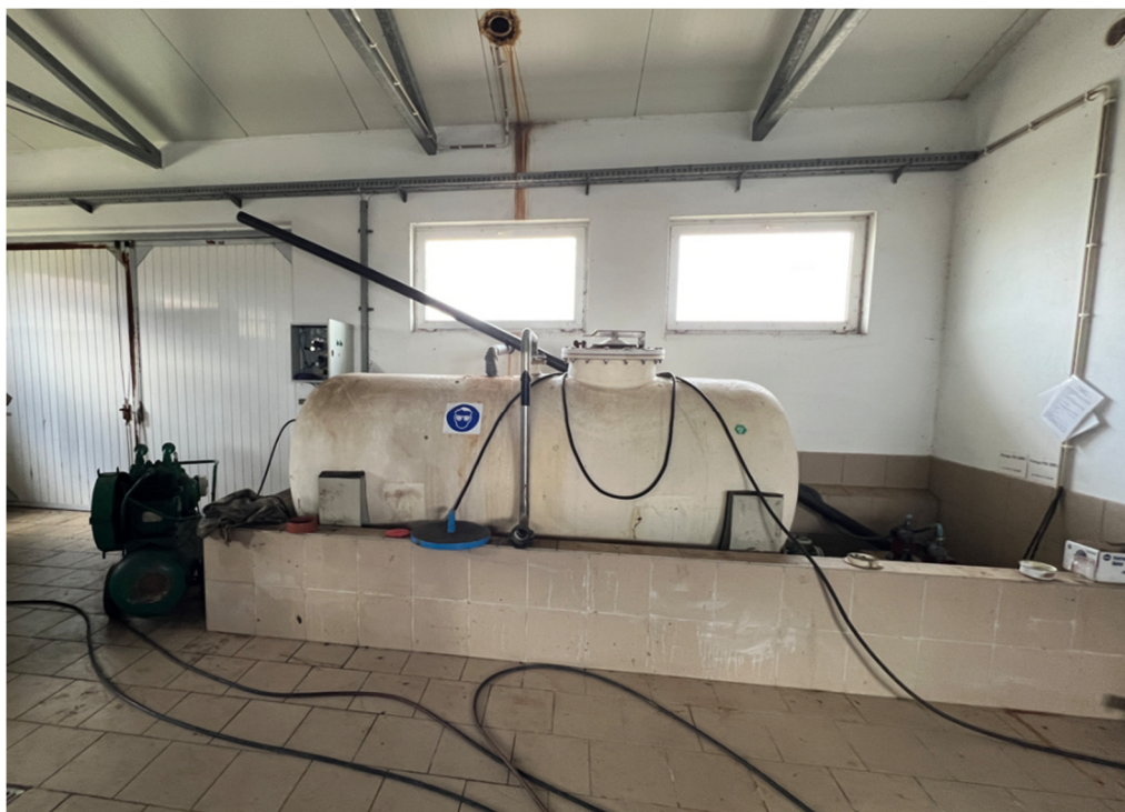
Fot.20. Instalacja dozowania PIX
