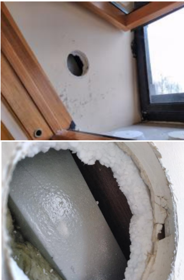
widok na odkrywkę nr 2 – zabudowa przy oknie z wykuszem
