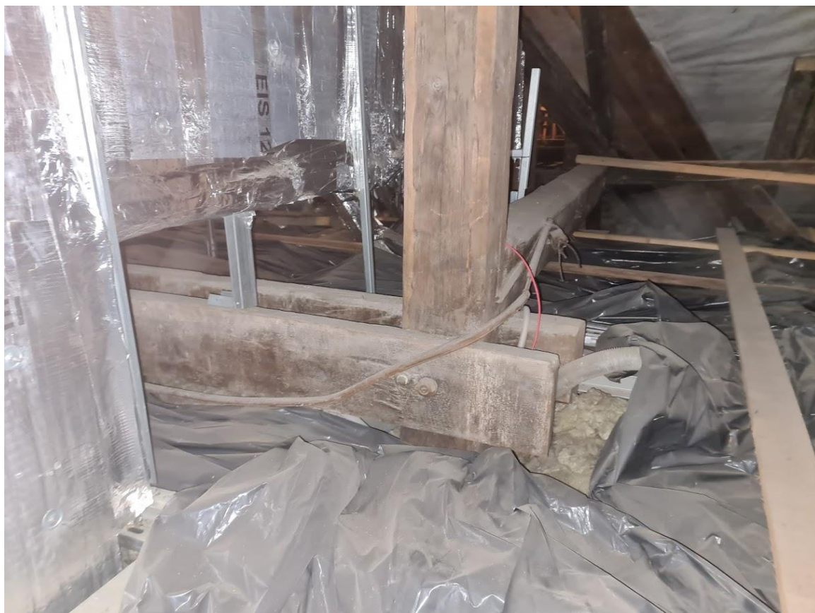
Widok na fragment poddasza z warstwą izolacji termicznej przykrytą folią
