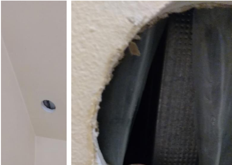
widok na odkrywkę nr 1 – korytarz obudowa istniejącej więźby dachowej
