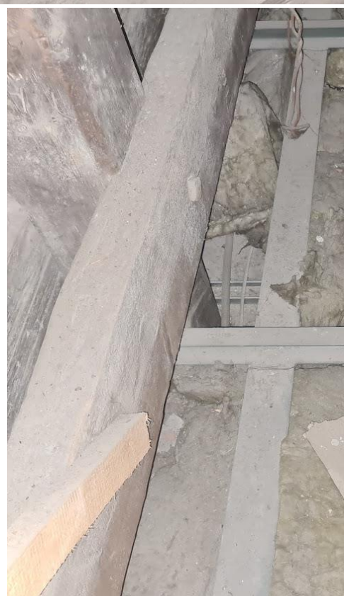
Widok na fragment sufitu podwieszanego nad pomieszczeniami użytkowymi stropu poddasza w widocznych ubytkami izolacji termicznej.
