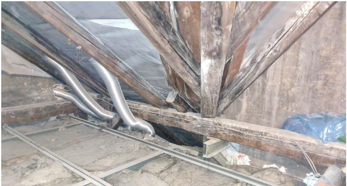
Widok na fragment poddasza z widoczną konstrukcją stalową stropu, podkonstrukcją pod podesty, luźno ułożoną wełną szklaną i oraz prześwitami przy lampach sufitowych.
