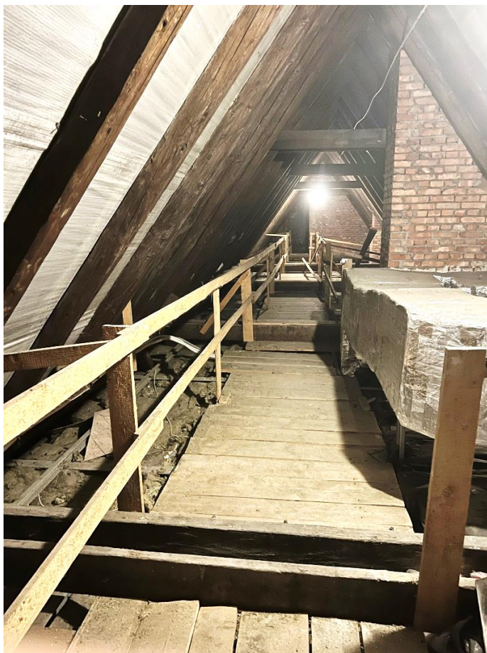
Widok pomostów technologicznych wzdłuż poddasza
