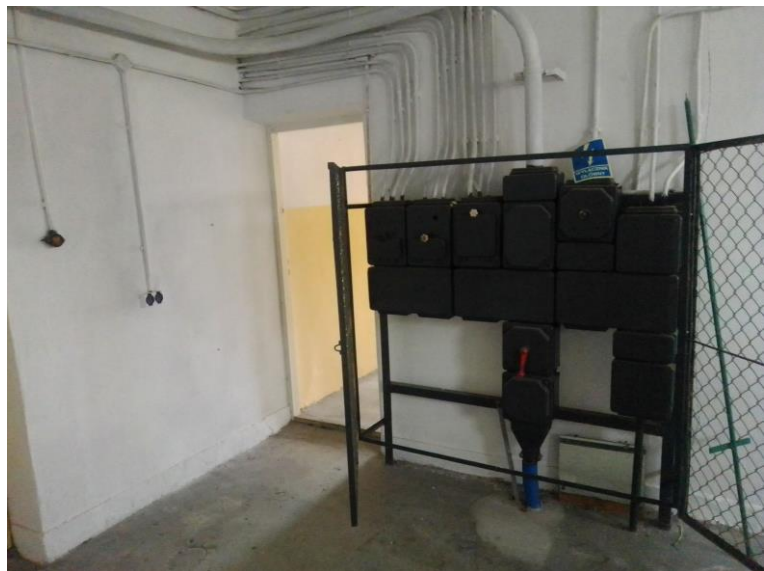
b) Rozdzielnica główna
