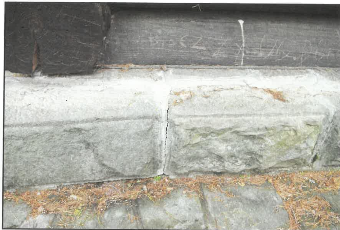
FOT. 43. CMENTARZ Z I WOJNY ŚWIATOWEJ NR 60 NA PRZEŁĘCZY MAŁASTOWSKIEJ (MAGURA). Kaplica- pomnik, zniszczone powierzchnia belek. stan przed konserwacją.
