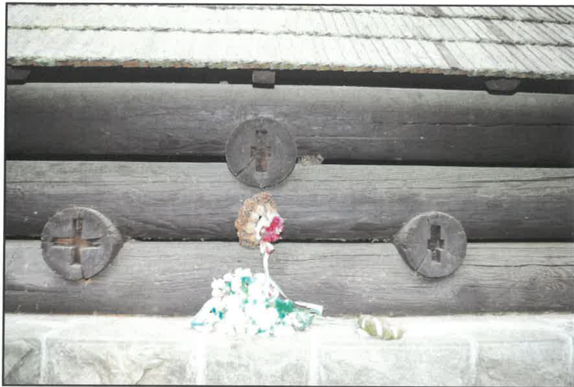
FOT. 29. CMENTARZ Z I WOJNY ŚWIATOWEJ NR 60 NA PRZEŁĘCZY MAŁASTOWSKIEJ (MAGURA). Kaplica- pomnik, str. zach., zakończenia belek z otworami montażowymi rozet, stan przed konserwacją.
