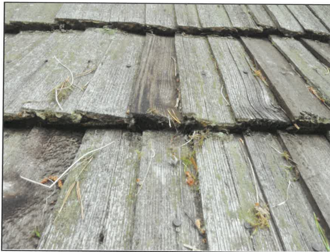
FOT. 64. CMENTARZ Z I WOJNY ŚWIATOWEJ NR 60 NA PRZEŁĘCZY MAŁASTOWSKIEJ (MAGURA). Zniszczony gont zadaszenia ogrodzenia, stan przed konserwacją.
