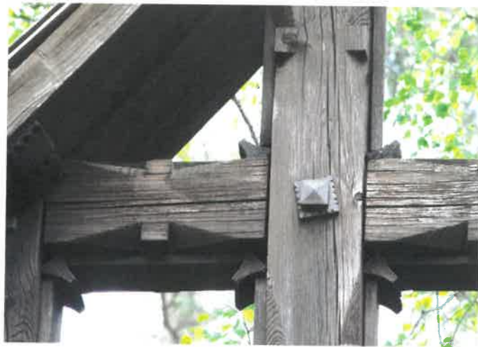
Lokalnie doszło do spękań drewna i rozszczepów złączy.
