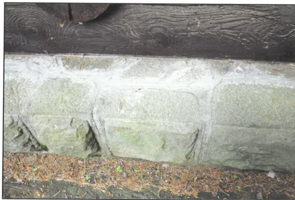
FOT. 44. CMENTARZ Z I WOJNY ŚWIATOWEJ NR 60 NA PRZEŁĘCZY MAŁASTOWSKIEJ (MAGURA). Kaplica- pomnik, zniszczone powierzchnia belek. stan przed konserwacją.
