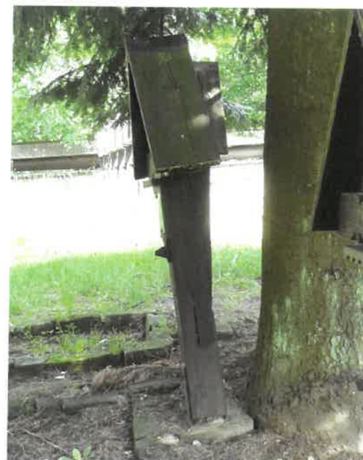
Korzenie rozrastającego się drzewa i niestabilność gruntu spowodowały przechylenie się niektórych krzyży.
