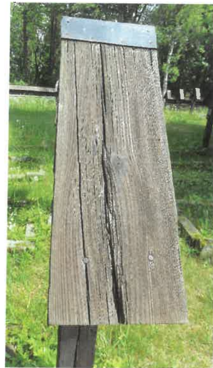
Lokalnie doszło do spękań drewna i rozszczepów złączy.
