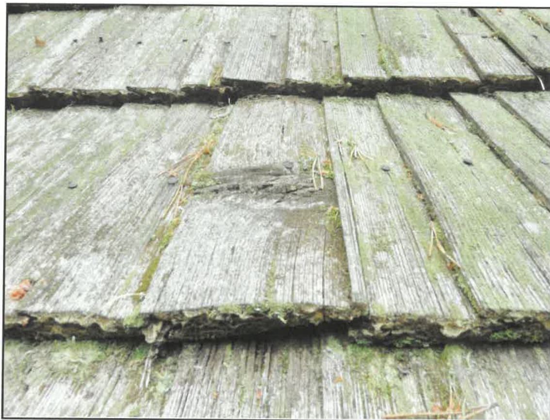
FOT. 63. CMENTARZ Z I WOJNY ŚWIATOWEJ NR 60 NA PRZEŁĘCZY MAŁASTOWSKIEJ (MAGURA). Zniszczony gont zadaszenia ogrodzenia, stan przed konserwacją.
