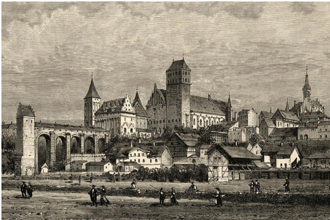
Rysunek 4 Widok Zamku od strony gdańska, XIX w., źródło: https://www.zamkipolskie.com/kwidz/kwidz.html , dostęp z 19.07.2023 r.
