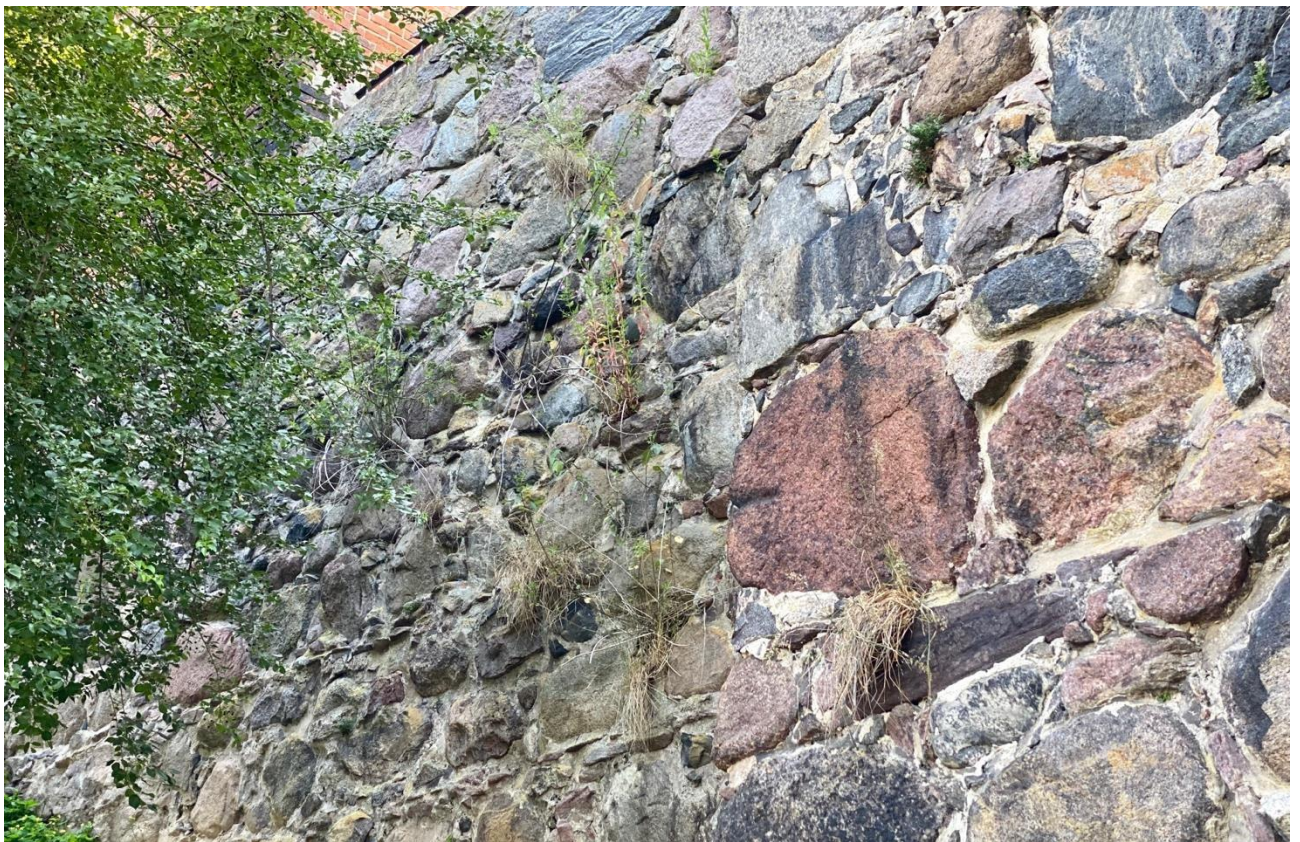
Ilustracja 13 Roślinność wyższa porastająca mur kamienny od strony północno-zachodniej. Widoczne liczne zabrudzenia powierzchni.
