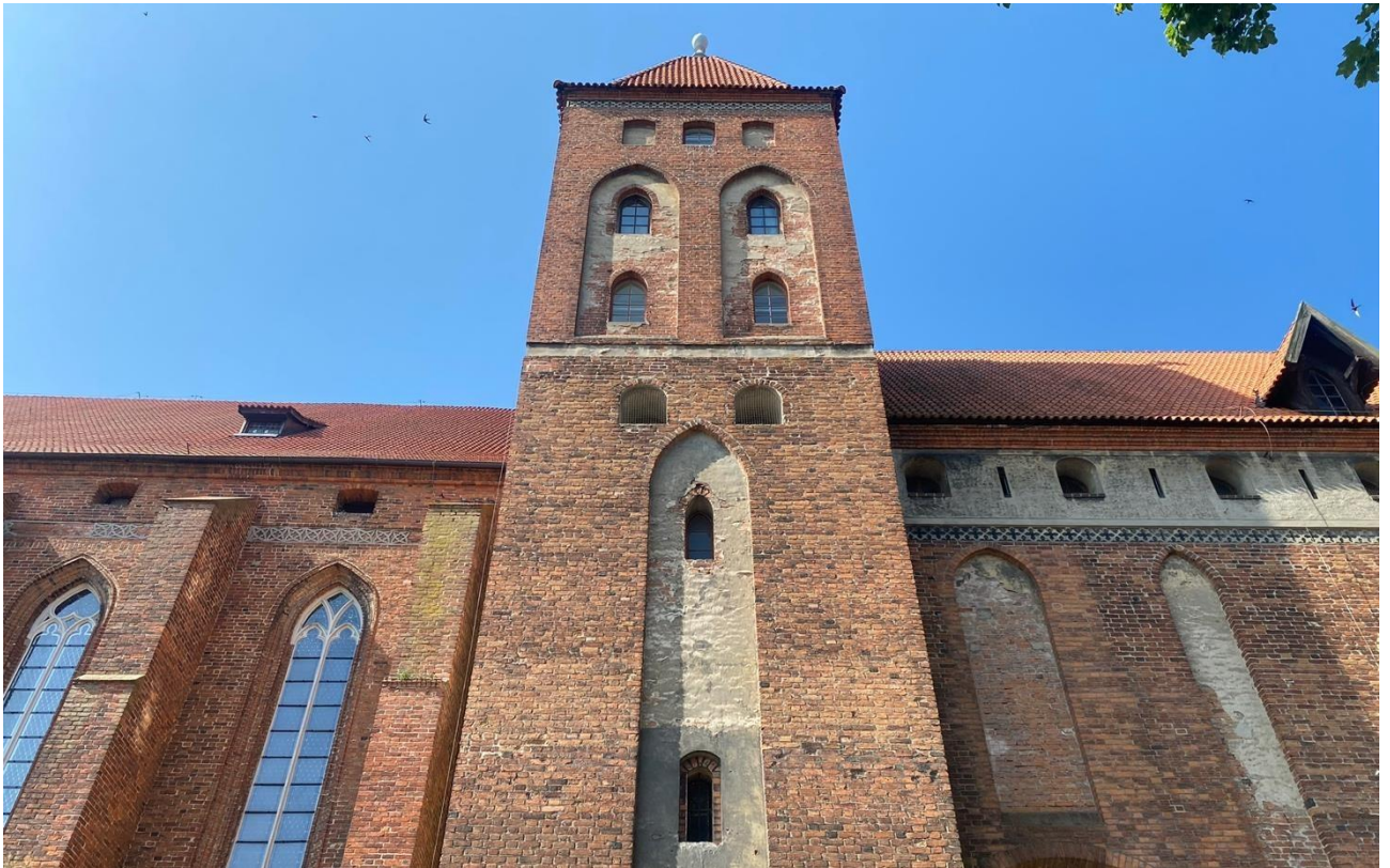
Ilustracja 6 Elewacja północna, szczyt elewacji z wieżą narożną.
