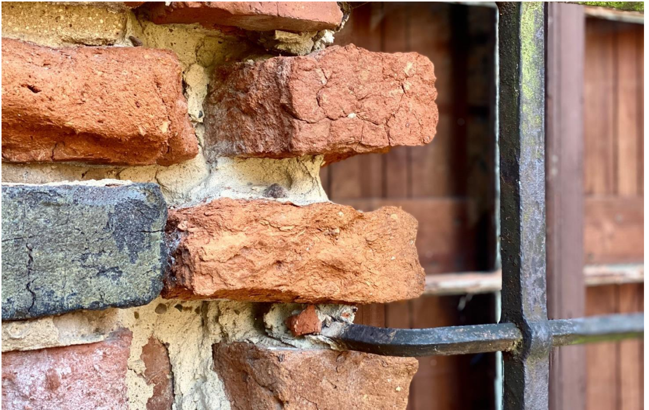
Ilustracja 16 Poważna erozja materiału ceramicznego oraz zapraw wapiennych.
