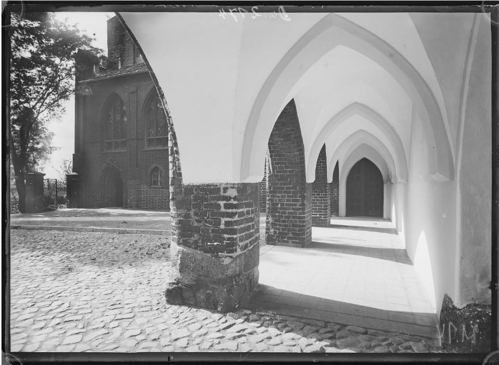
Ilustracja 3 Fotografia powojenna, widoczne historyczne okna ze szkleniem romboidalnym, źródło: Muzeum Zamkowe w Malborku
