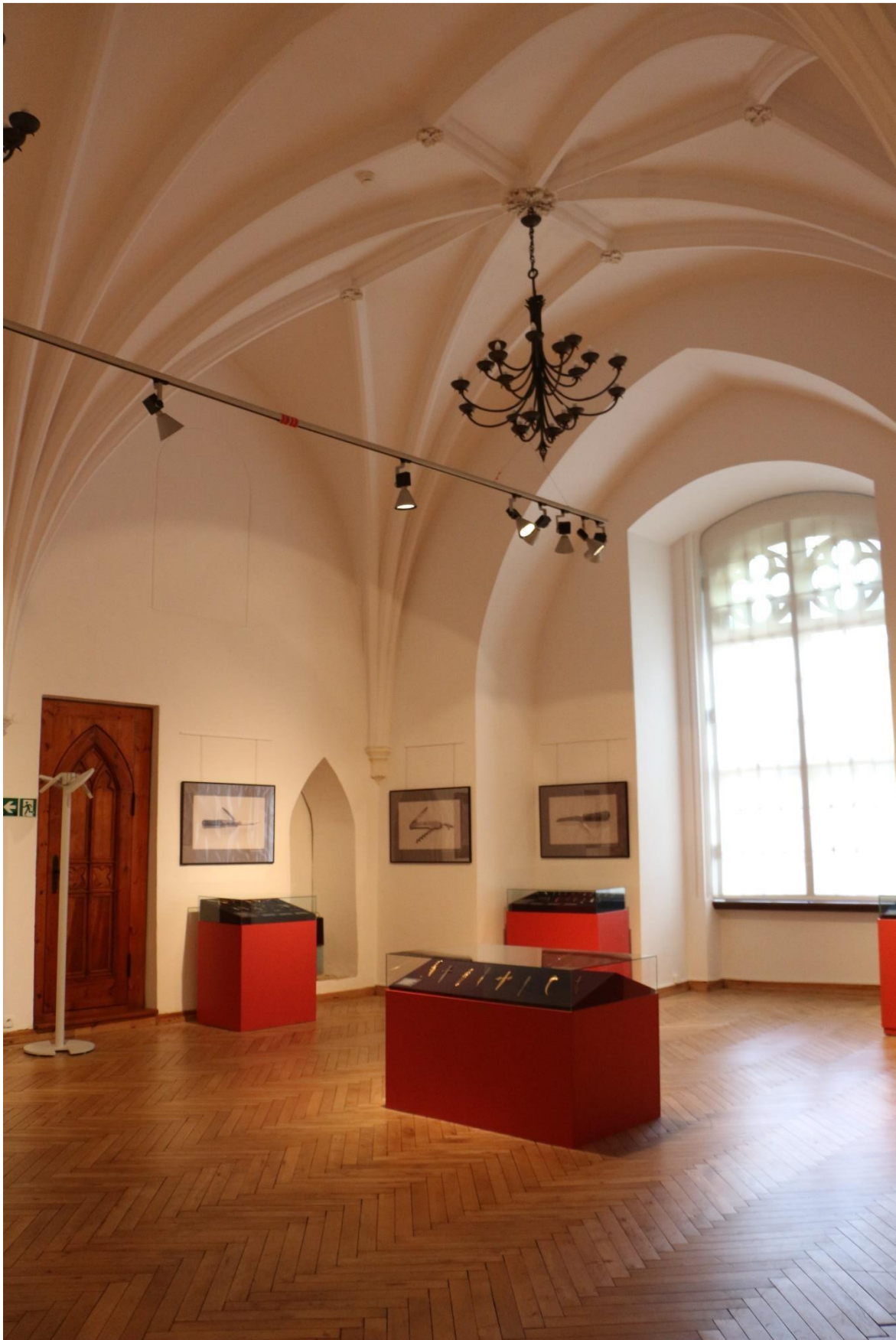
Ilustracja 28 Sala ekspozycyjna z licznymi przemalowaniami w obrębie ścian.
