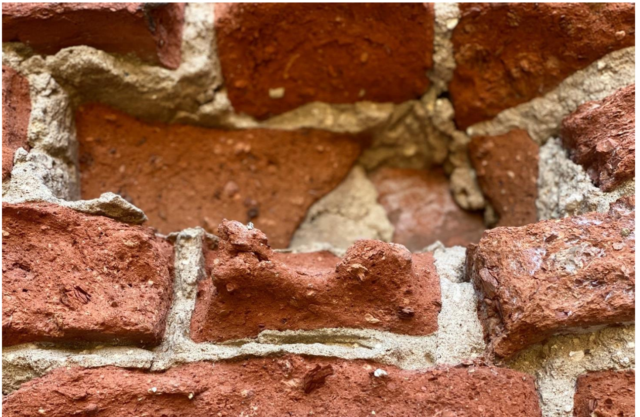
Ilustracja 17 Erozja materiału ceramicznego.
