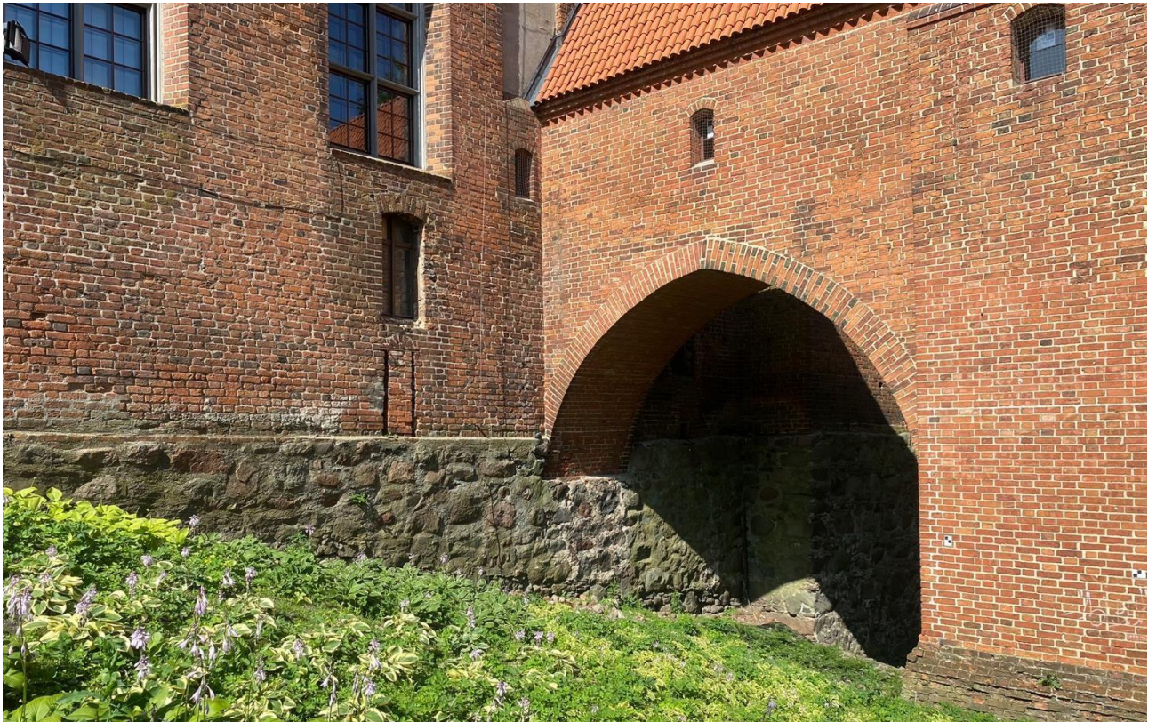
Ilustracja 8 Elewacja północna oraz łącznik z wieżą studzienną.
