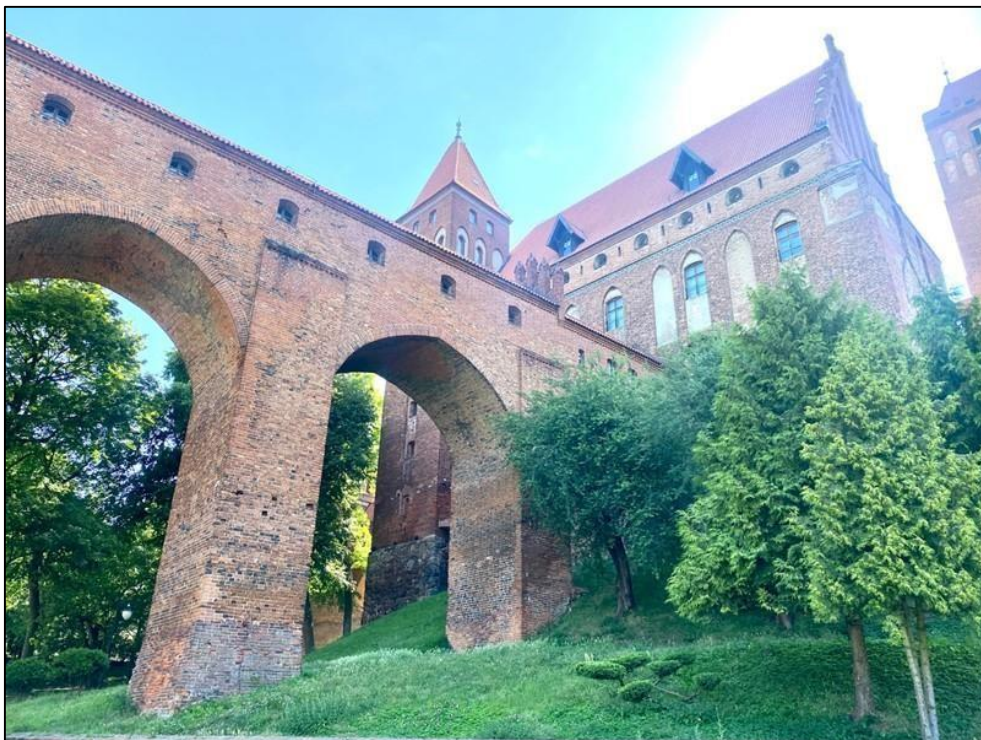
Fot. 1 Widok ogólny bryły obiektu od strony południowo- zachodniej
