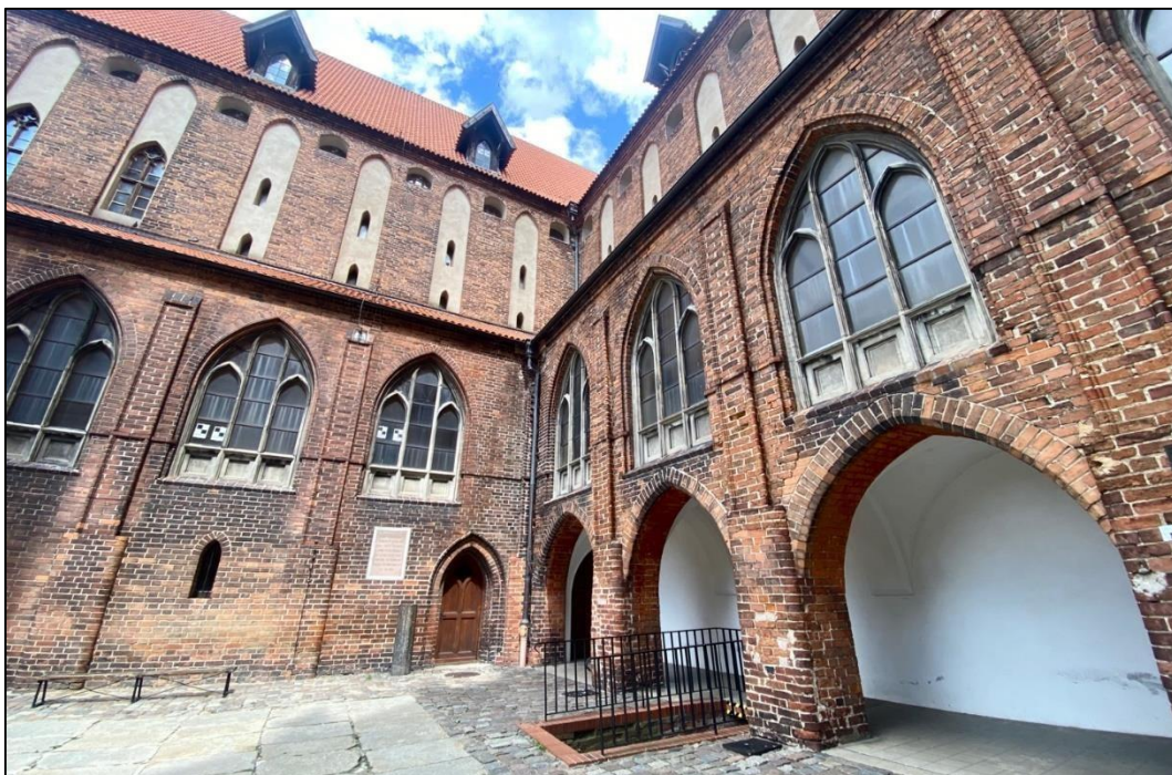
Fot. 2 Widok elewacji skrzydła zachodniego i północnego
