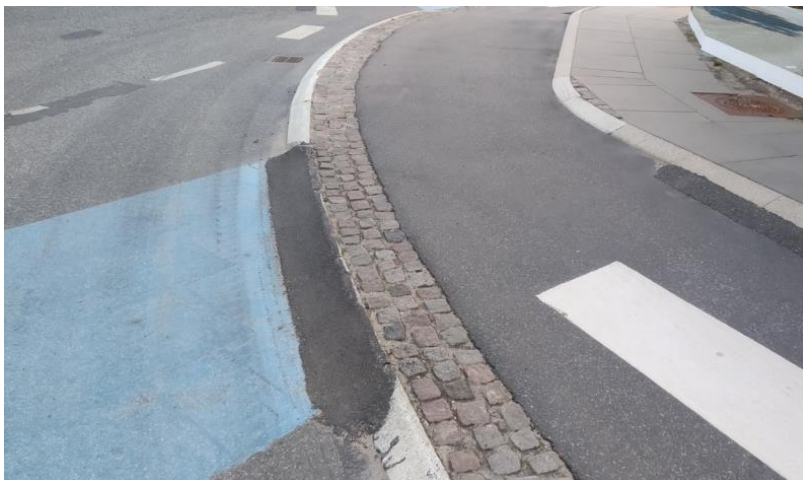
Fotografia 14. Zniwelowanie różnicy wysokości krawężnika do osi drogi poprzez małą wylewkę asfaltową (Billund, Dania).
