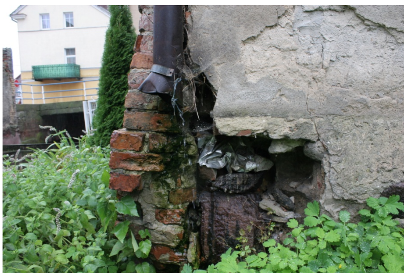
Rys. 23 Odspojenie podmywanej ściany szczytowej przybudówki
