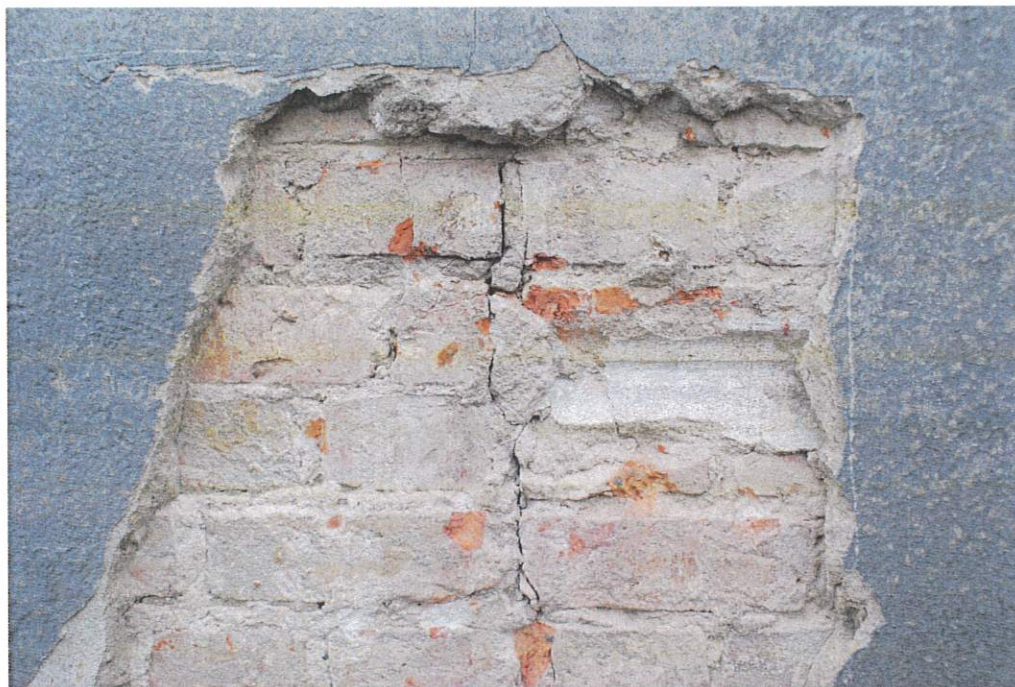
Fot. nr 5 PN przedstawia fragment odkrywki nr 1, z zarysowanym szwem po zamurowanej witrynie oraz zachowany fragment poziomej dekoracji opracowanej w tynku na elewacji frontowej parteru.
