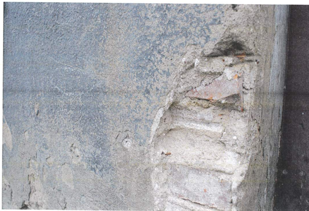
Fot. nr 12 PN fragment odkrywki nr 3. Zachowany niewielki fragment profilowanego pasa oraz bruzda wykuta w licu muru.
