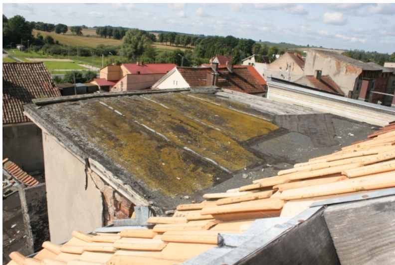
Rys. 10 Połąć dachowa nad częścią I piętra budynku głównego - papa, dachówka na budynku głównym
