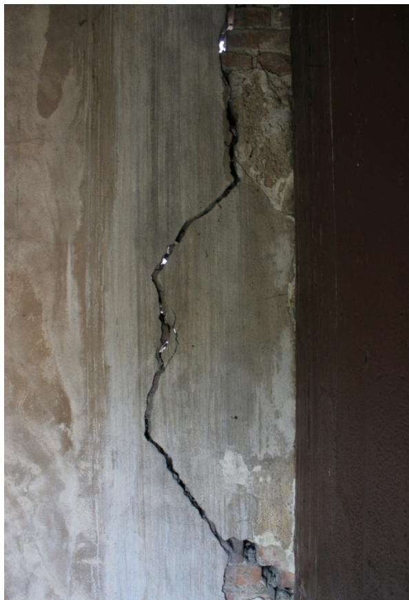
Rys. 5 Pęknięta na wylot ściana szczytowa znajdująca się ponad przyległym budynkiem
