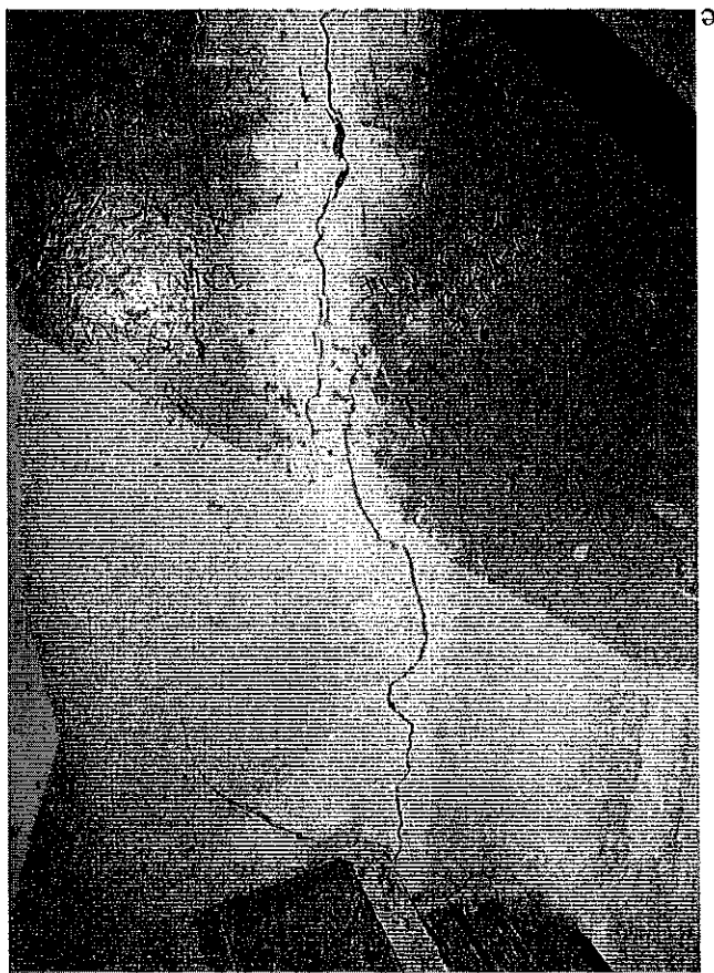
Rys. 5 Pęknięta na wylot ścienna szczytowa znajdująca się ponad przyległym budynkiem
