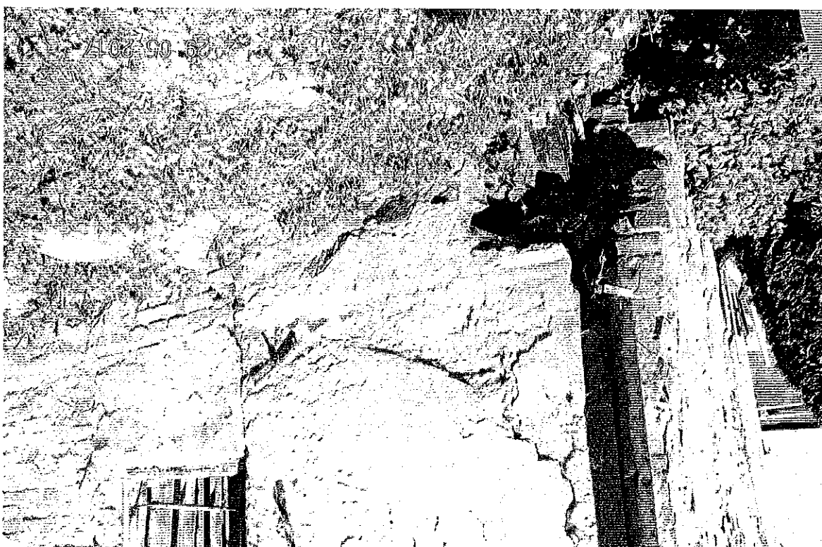
Zdjęcie 7 Spękana ściana narożna budynku na skarpie przy rzece
