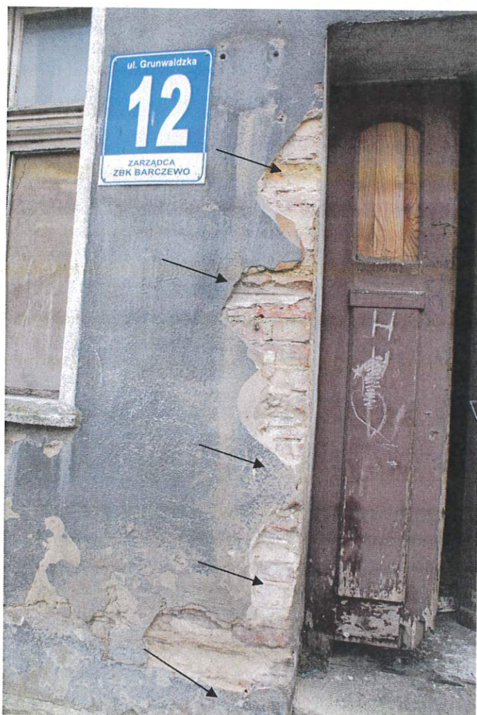
Fot. nr 11 PN. Odkrywka nr 3 wykonana wzdłuż krawędzi otworu drzwiowego w elewacji frontowej (parter). Strzałki wskazują zachowane fragmenty poziomych pasów dekorujących elewację frontową, umieszczonych w odległości co 37 cm, tworzących pseudoboniowanie.
