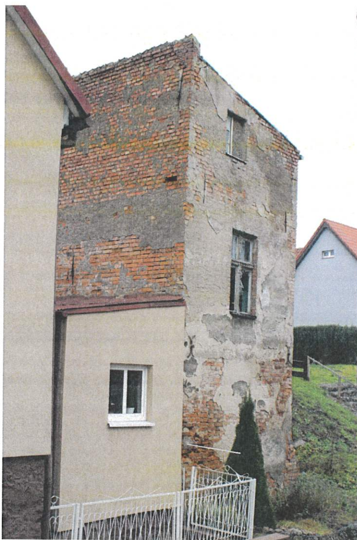
Fot. nr 46PD Fragment elewacji południowej oficyny- narożnik zachodni. Daleko posunięta destrukcja cegły- lasowanie. Cegła ułożona w wążku krzyżowym.
