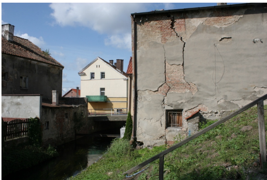
Rys. 4 Spękana ściana podłużna przybudówki
