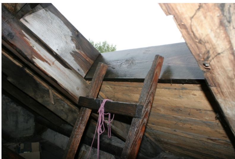
Rys. 18 Niezabezpieczony otwór wylazowy na połąć dachową nad głównym budynkiem
