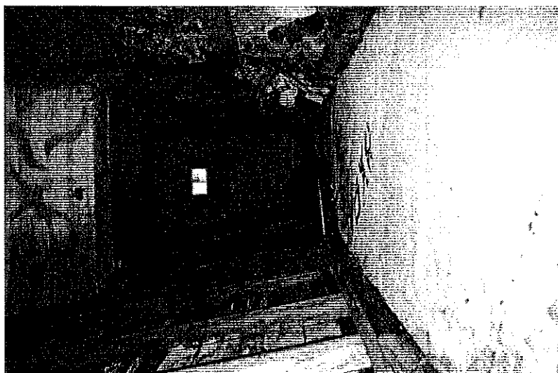
Rys. 11 Przecieki z dachu nad I piętrzem
