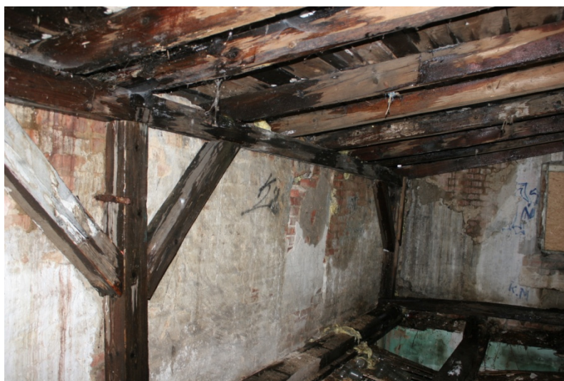
Rys. 14 Więźba dachu nad przybudówką, zawalony strop pod poddaszem
