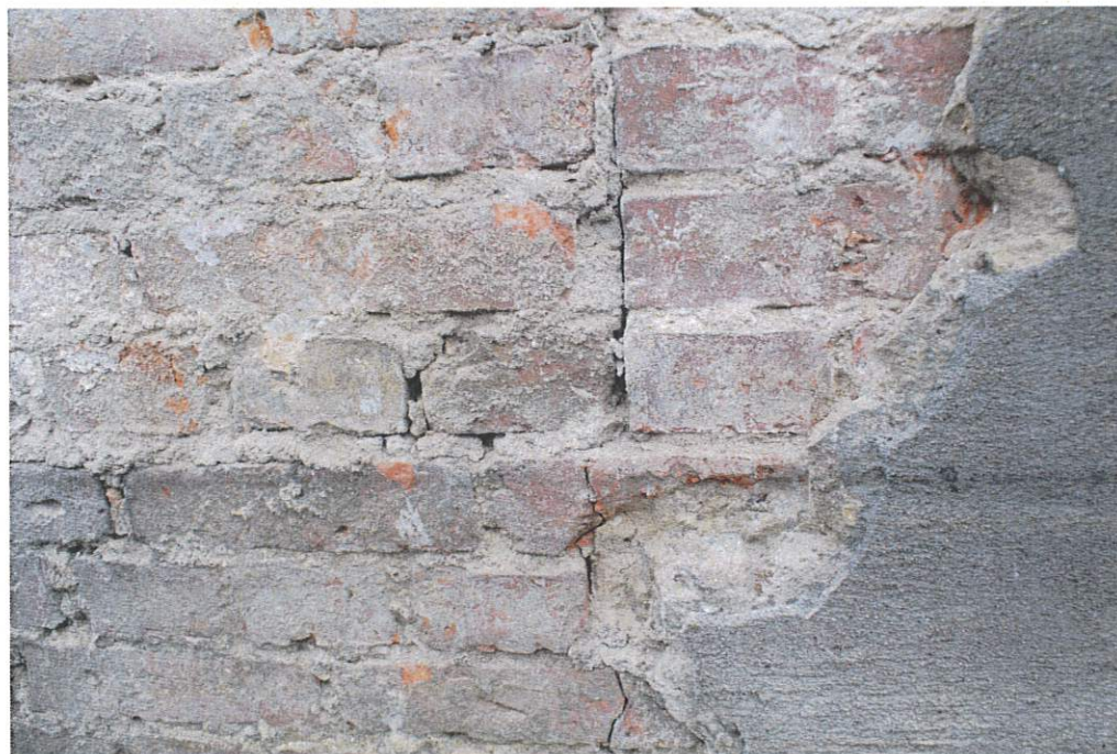
Fot. nr 6 PN przedstawia fragment odkrywki nr 1 z zarysowanym szwem po zamurowanej witrynie oraz niewielką odsadzkę na której osadzona była duża witryna okienna. Widoczna różnica pomiędzy ceglami lica elewacji i ceglami wypełniającymi otwór po witrynie oraz w sposobie kładzenia zaprawy.
