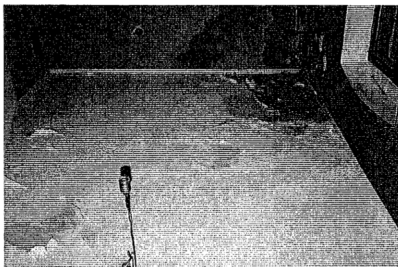
Rys. 10 Połączenie dachowe nad częścią I piętra budynku głównego - papa, dachówka na budynku głównym
