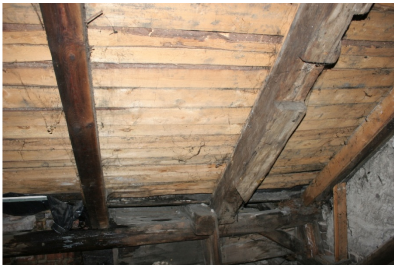
Rys. 16 Więźba nad budynkiem głównym, widoczne ślady przeciekania i korozji biologicznej drewna
