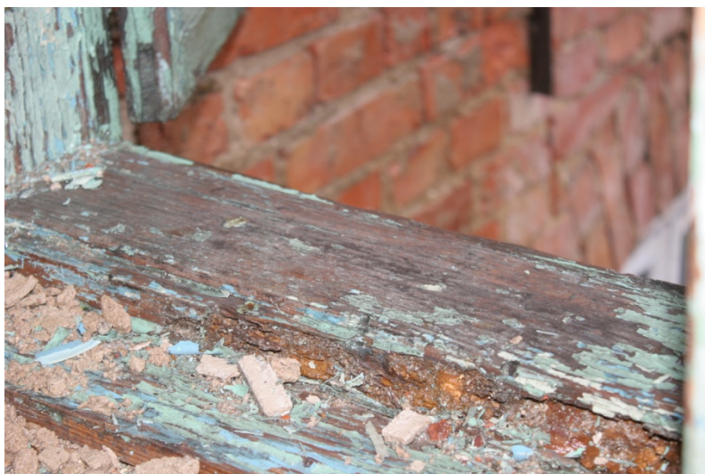
Rys. 8 Skorodowana rama okienna
