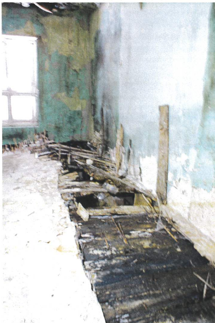
Fotografia nr 127 przedstawia zarwany strop w drugim pomieszczeniu I piętra oficyny.
