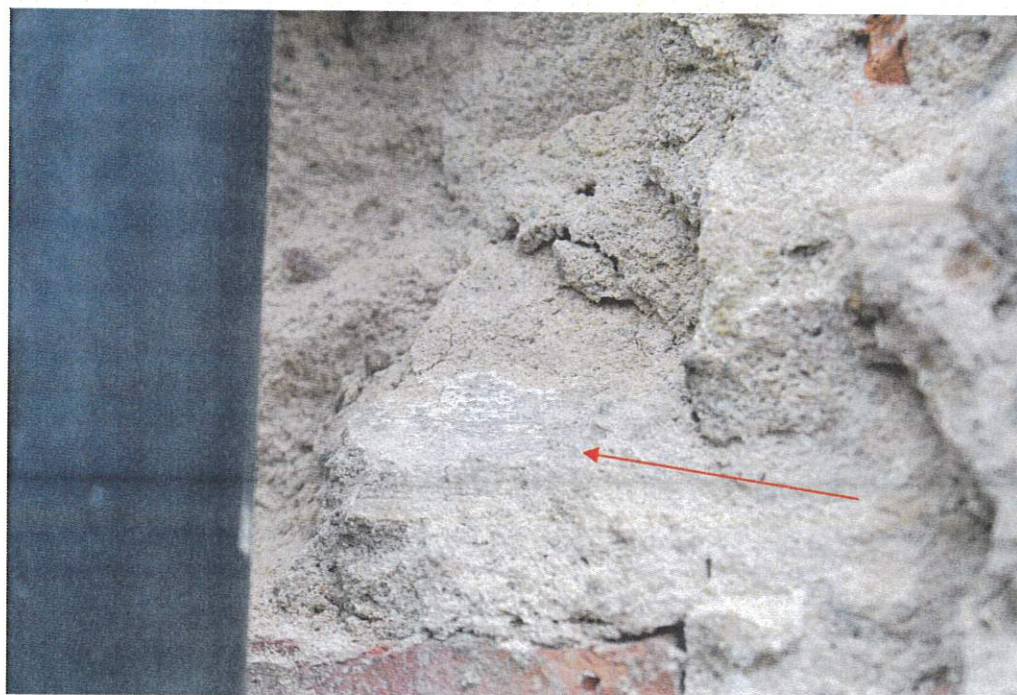
Fot. nr 8 PN fragment odkrywki nr 1 - wschodni narożnik. Zachowany niewielki fragment wyprofilowanego pasa z cieniutką warstwą pobiałą.
