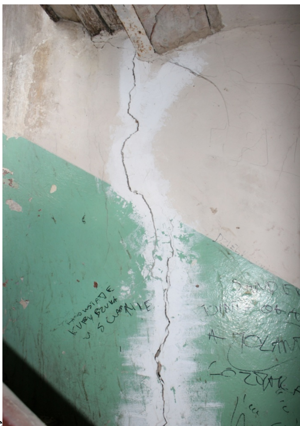
Rys. 6 Pęknięta na wylot ściana szczytowa oddzielająca od budynku przyległego
