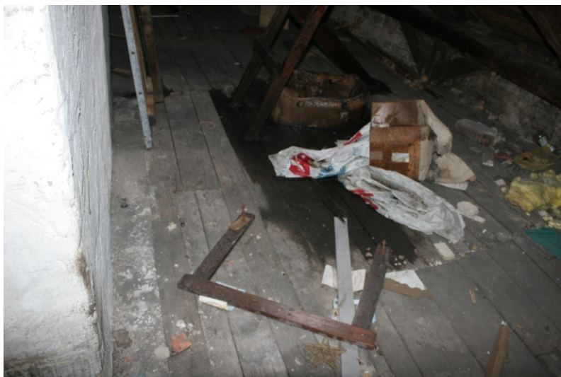
Rys. 17 Zalanie w obrębie poddasza nad budynkiem głównym
