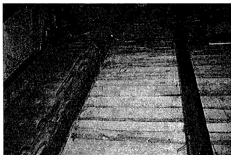
Rys. 16 Wieżba nad budynkiem głównym, widoczne ślady przeciekania i korozji biologicznej drewna
