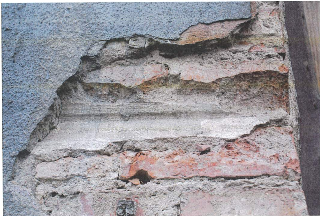
Fotografie nr 13 i 14 PN przedstawiają fragment odkrywki nr 3. Wyraźnie widoczna wykonana w licu muru półkolista bruzda z zachowanym dekoracyjnym profilowanym pasem
