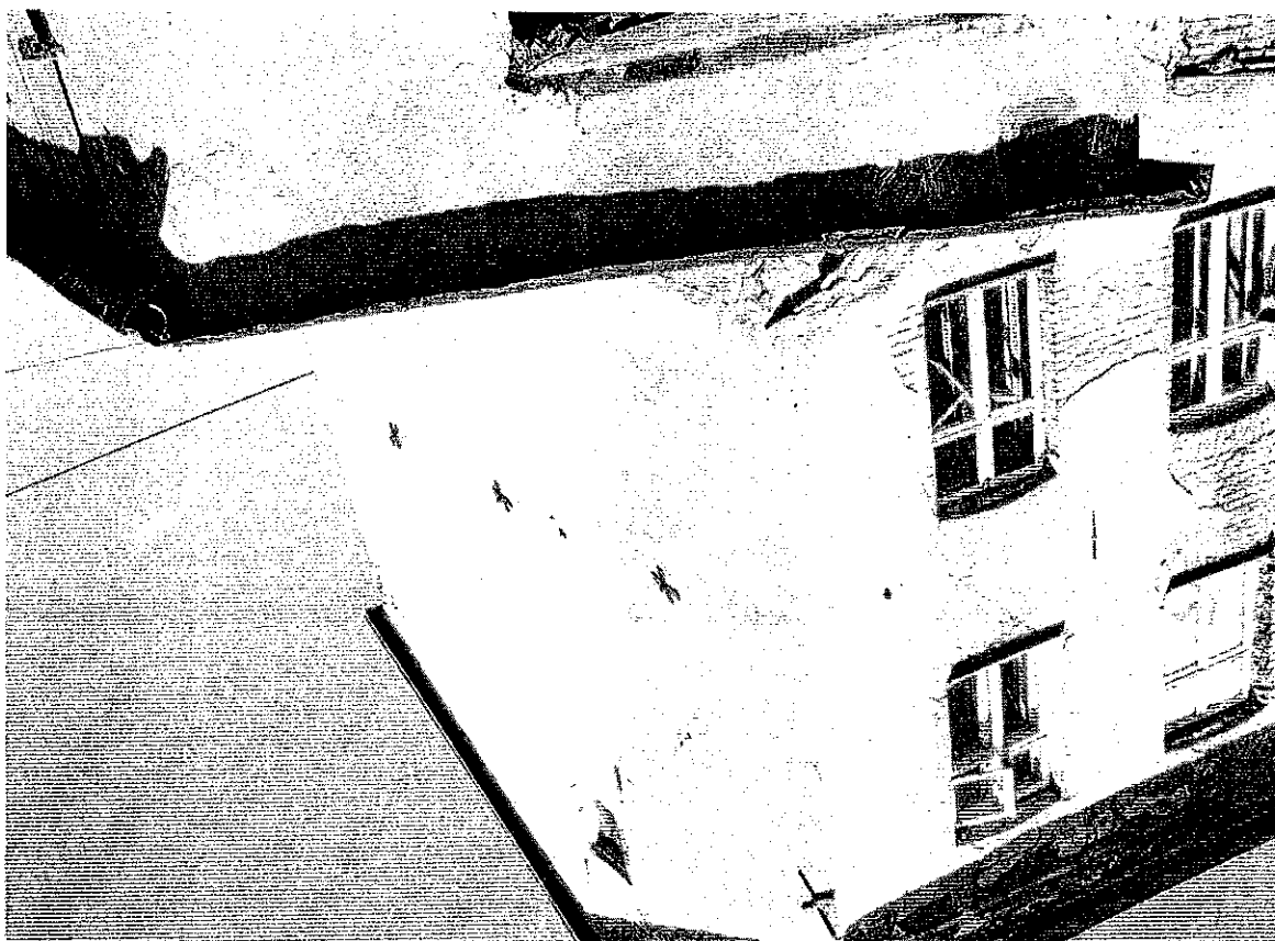
Zdjęcie 10 Widok elewacji z boku od strony podwórka - widoczne stężenia poziome ścian budynku
