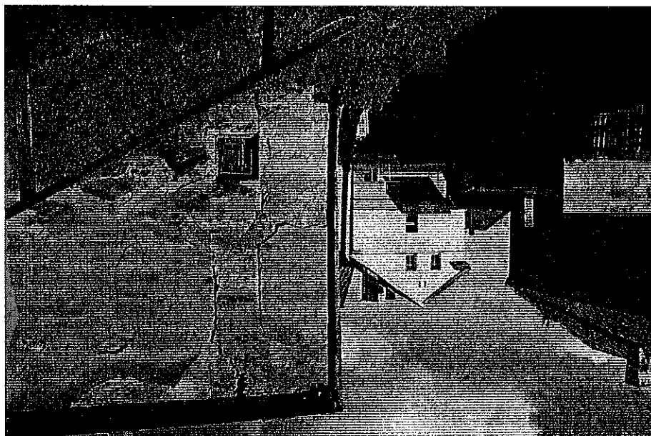
Rys. 4 Spękana ściana podłużna przybudówki
