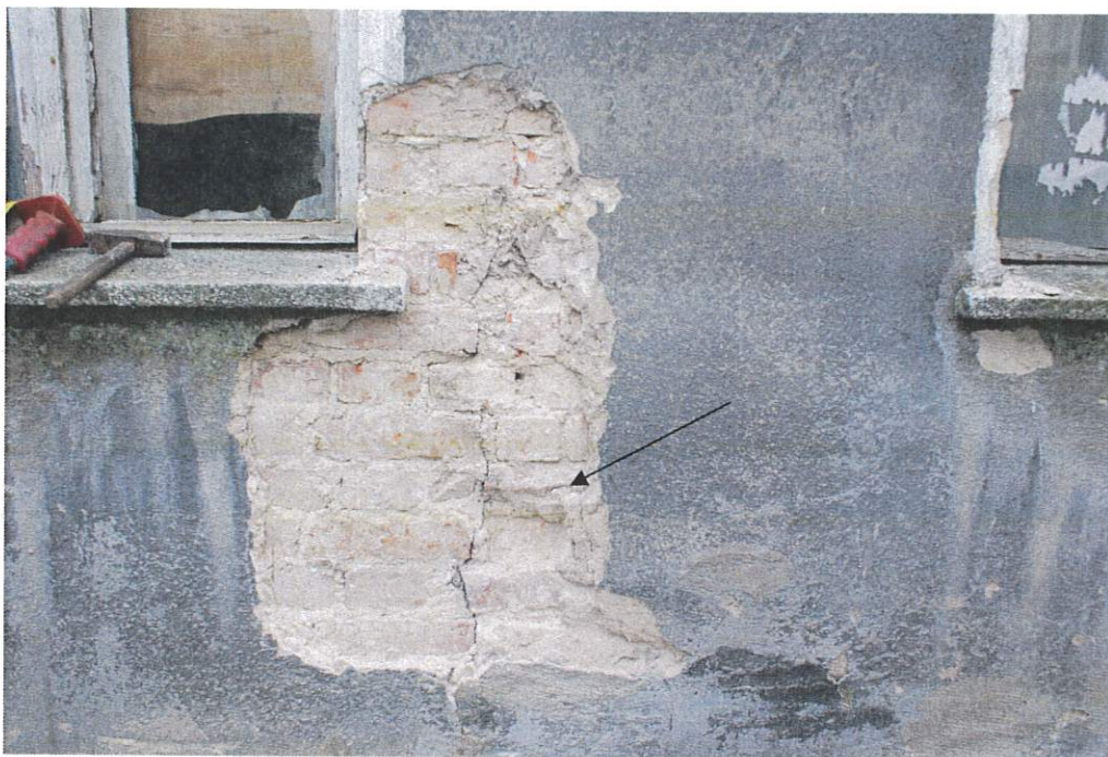
Fot. nr 9 PN. Odkrywka nr 2 wykonana na elewacji północnej - parter. Widoczny szew po zamurowanym otworze drzwiowym znajdującym się w drugiej osi elewacji frontowej. Widoczna próba dowiązania się do wątku muru. Ponadto widoczna bruzda w licu muru oraz niewielki fragment dekoracji poziomej.
