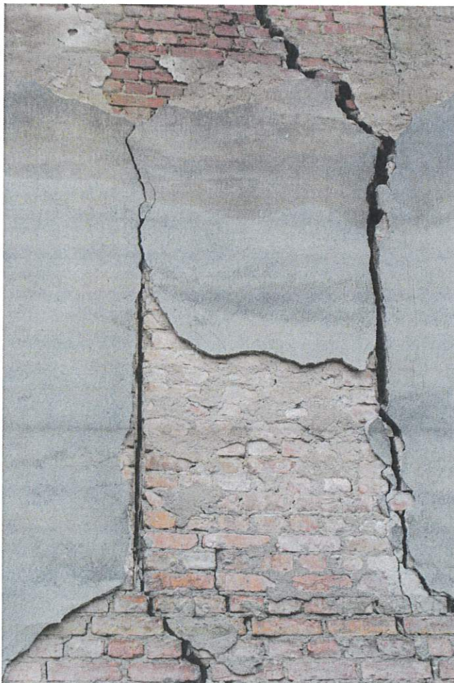
Fotografia nr 27W przedstawia fragment ściany wschodniej oficyny (przyziemie) z wtórnym, kwadratowym oknem umieszczonym w miejscu zamurowanego większego otworu okiennego. Po prawej odsłonięty watek ceglany. Cegły o wym. 25 cm x 12 cm x 6,5 cm murowane w wтку krzyżowym. Po lewej (od okna) kotwy spinające ścianę działową.
