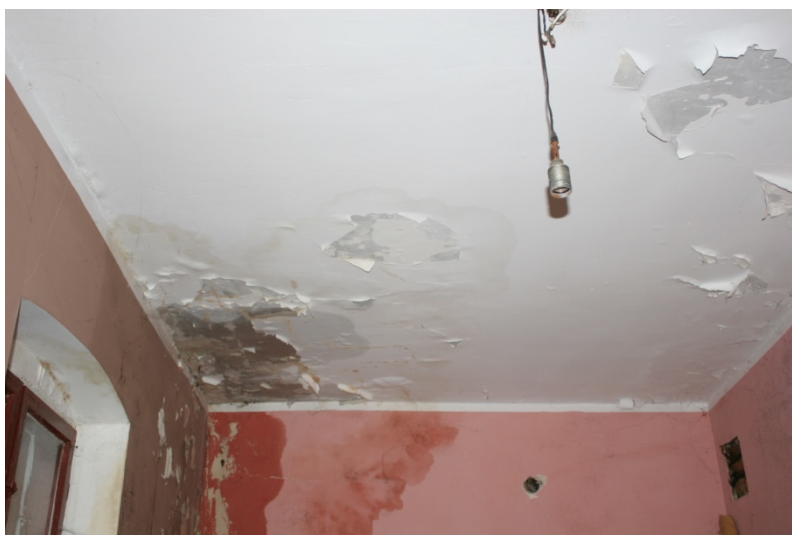
Rys. 11 Przecieki z dachu nad I piętrem
