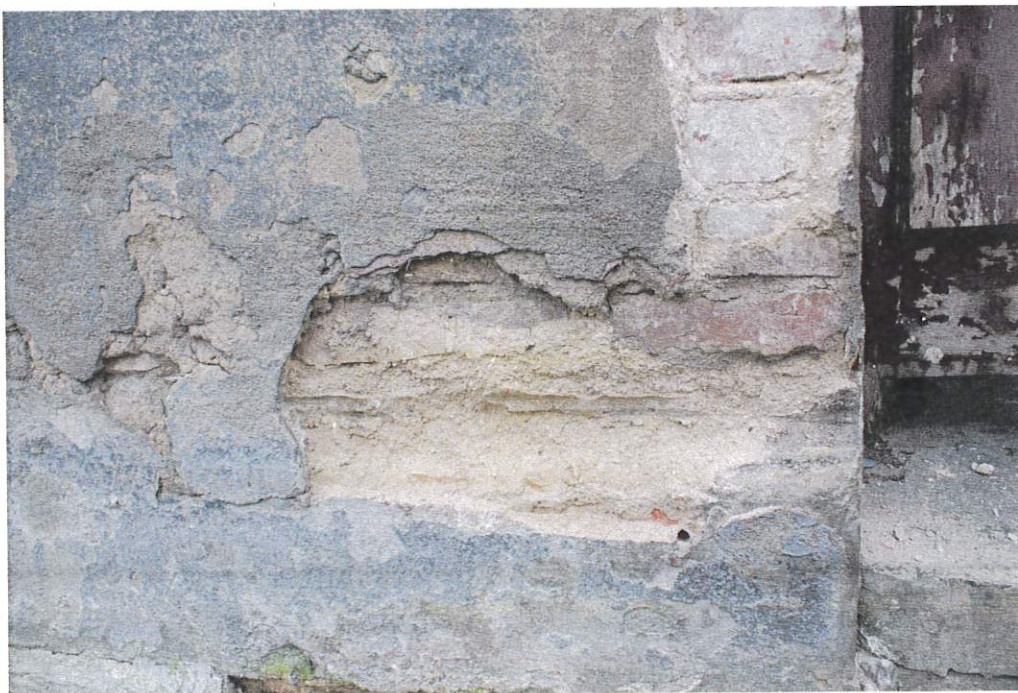
Fotografie nr 13 i 14 PN przedstawiają fragment odkrywki nr 3. Wyraźnie widoczna wykonana w licu muru półkolista bruzda z zachowanym dekoracyjnym profilowanym pasem
