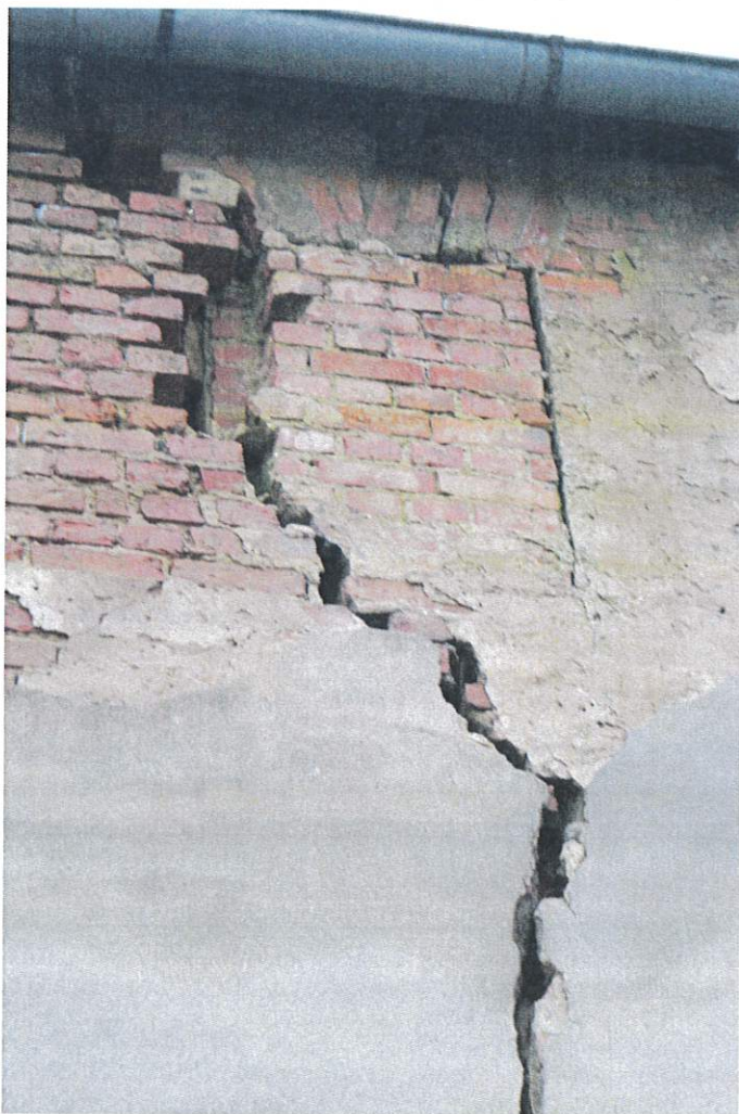
Fot. nr 29W przedstawia fragment ściany wschodniej oficyny - poddasze. Zamurowany pierwotny otwór okienny. Znaczna destrukcja muru. Ściana na skutek uszkodzonego południowo-wsch. narożnika, którego destrukcja naruszyła statykę muru, „rozjeżdża się”.
