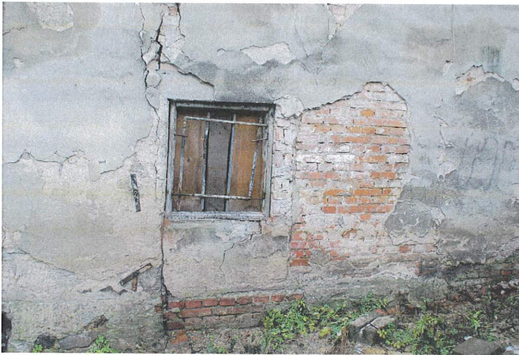
Fotografia nr 27W przedstawia fragment ściany wschodniej oficyny (przyziemie) z wtórnym, kwadratowym oknem umieszczonym w miejscu zamurowanego większego otworu okiennego. Po prawej odsłonięty watek ceglany. Cegły o wym. 25 cm x 12 cm x 6,5 cm murowane w wтку krzyżowym. Po lewej (od okna) kotwy spinające ścianę działową.
