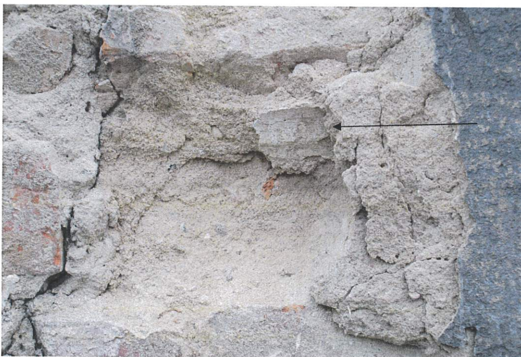
Fot. nr 10 PN fragment odkrywki nr 2 widoczna bruzda w licu muru oraz niewielki fragment opracowanej w tynku poziomej dekoracji z cienką warstwą pobiału.
