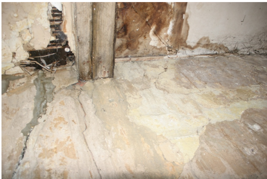
Rys. 20 Przecieki w obrębie stropu między II piętrem a poddaszem
