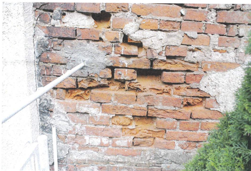
Fot. nr 46PD Fragment elewacji południowej oficyny- narożnik zachodni. Daleko posunięta destrukcja cegły- lasowanie. Cegła ułożona w wążku krzyżowym.
