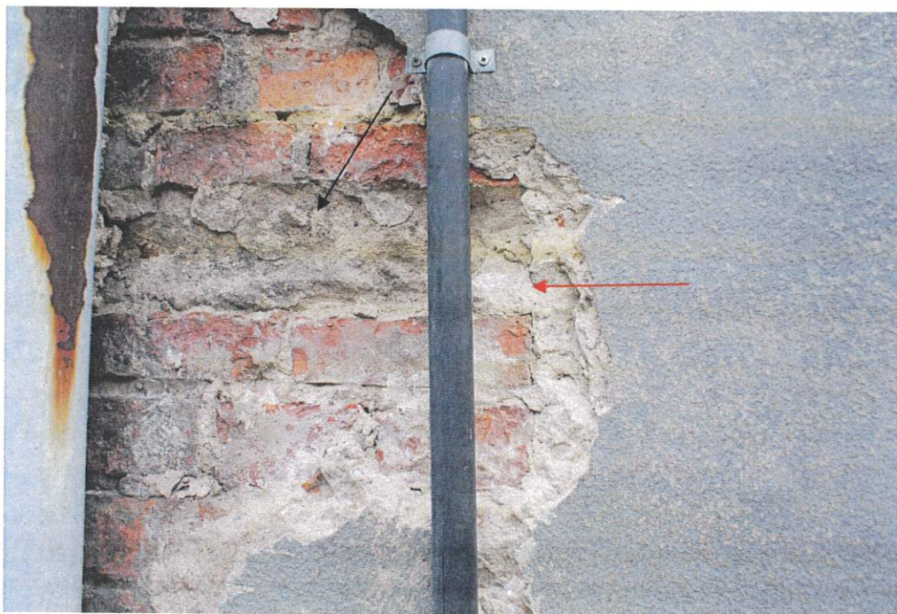
Fot. nr 7 PN fragment odkrywki nr 1 - wschodni narożnik. W celu wykonania poziomych pasów w ceglanym licu wykonano bruzdy, w których następnie wykonano w tynku profilowane pasy. Strzałka wskazuje wtórne wypełnienie tynkiem bruzdy.
