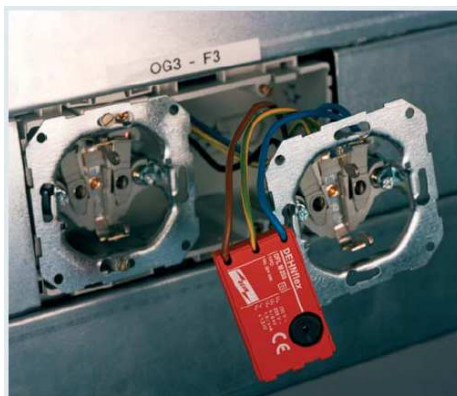
Widok ochronnika klasy D do wbudowania
