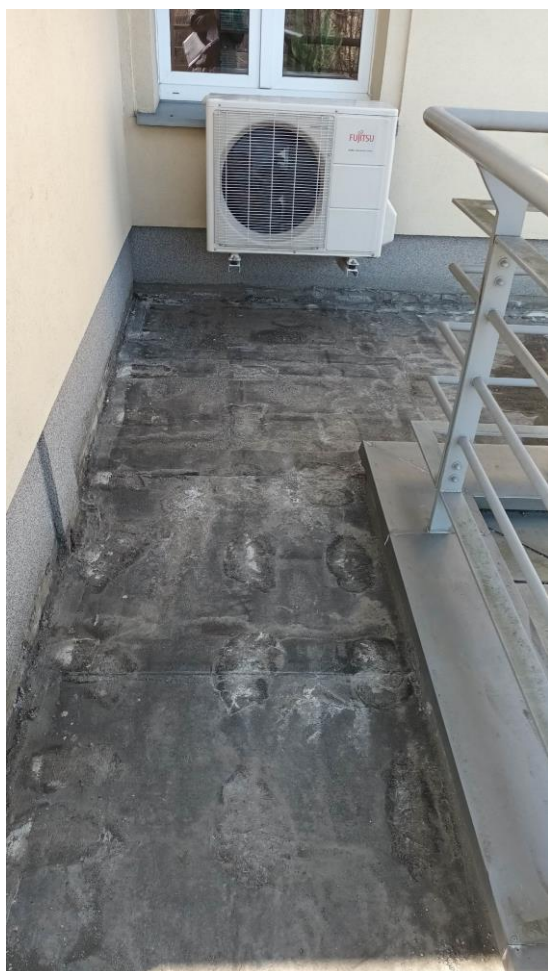
b) pokrycie tarasu (położenie nowych warstw hydroizolacji);
