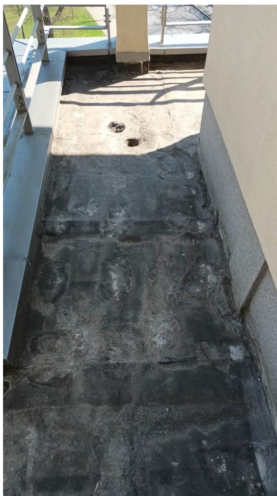
b) pokrycie tarasu (położenie nowych warstw hydroizolacji);
